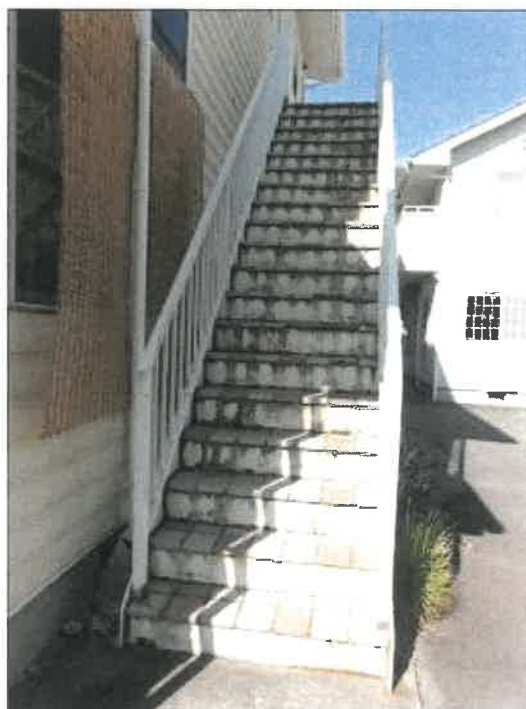
物件 4 建物の 2 階居宅部分への階段の状況
