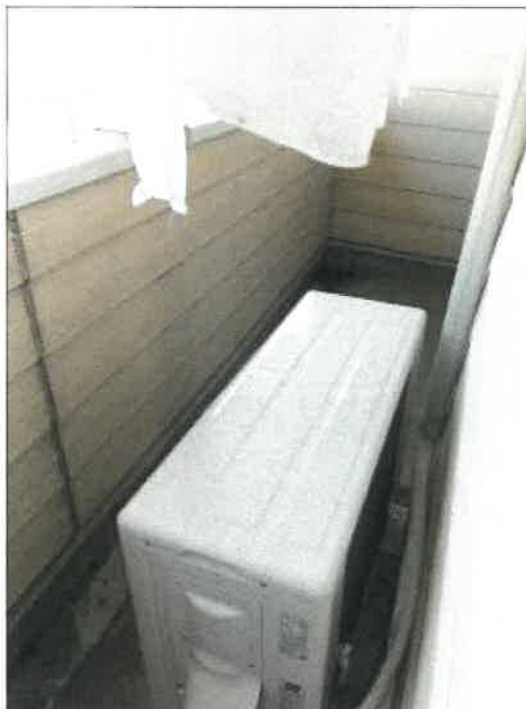
物件4 建物の2階居宅部分のベランダの状況
