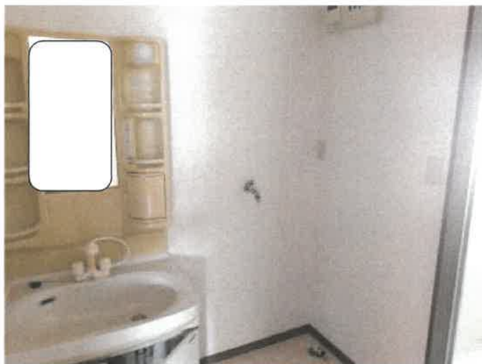
物件 6 建物 1 0 2 号室洗面脱衣所の状況
