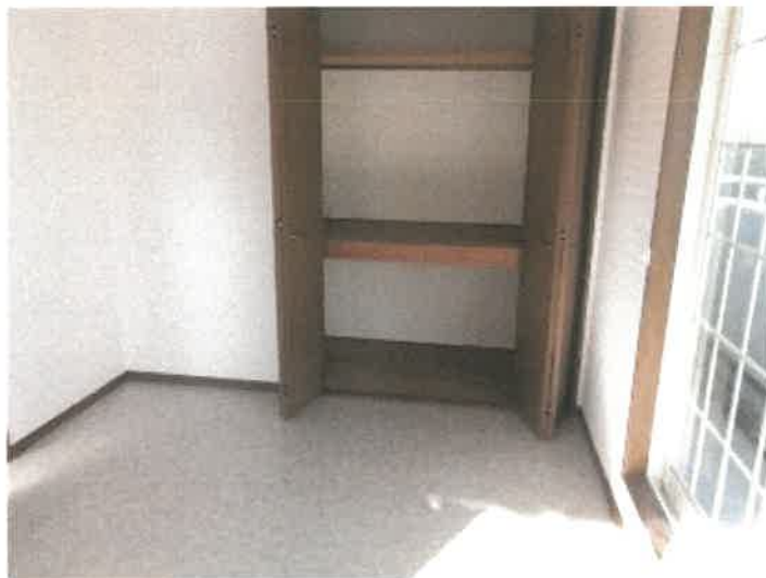
物件5建物102号室南側洋室の状況
