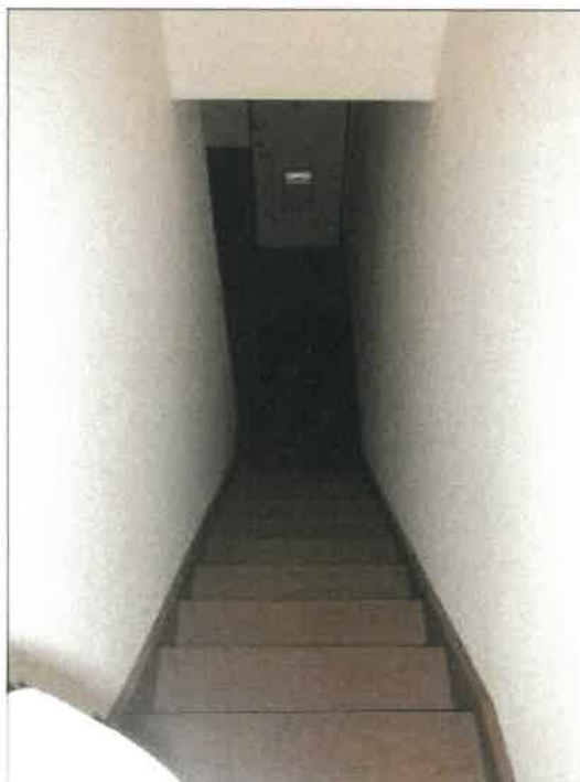
物件 5 建物 2 0 2 号室階段の状況
