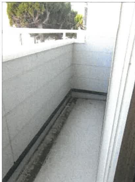
物件6建物102号室ベランダの状況
