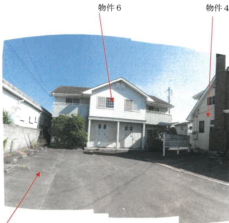
物件 6 建物北側の状況
