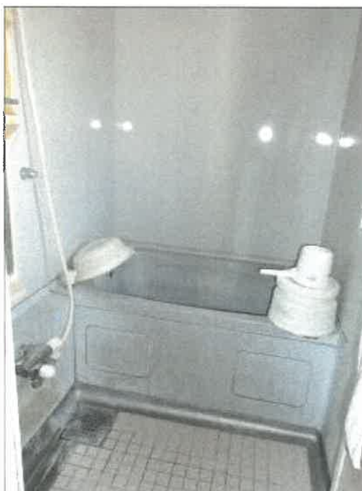
物件 4 建物の 2 階居宅部分の浴室の状況
