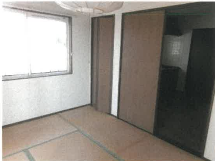
物件 5 建物 1 0 1 号室北側和室の状況
