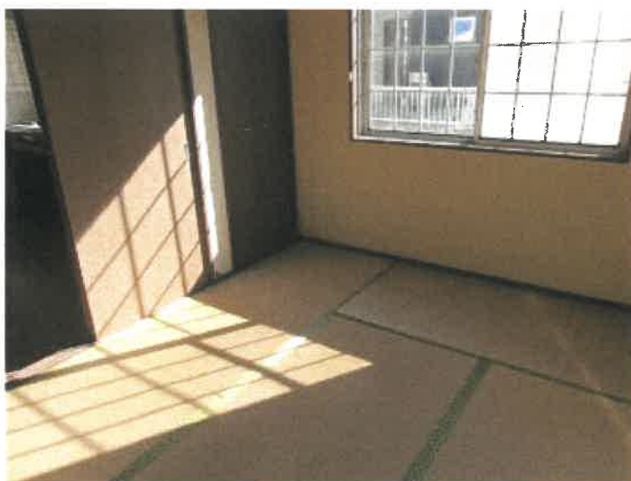
物件5建物102号室北側和室の状況
