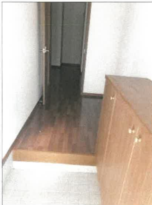
物件6建物101号室玄関周りの状況
