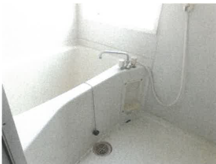
物件 6 建物 1 0 2 号室浴室の状況
