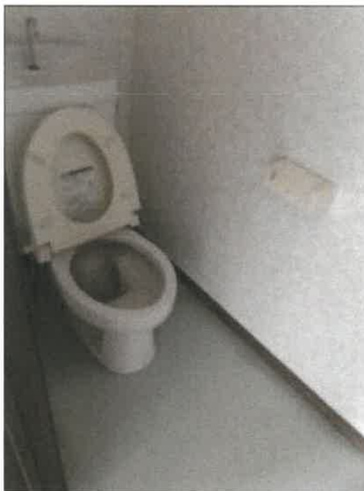
物件5建物101号室トイレの状況
