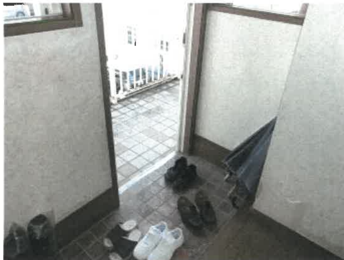
物件4建物の2階居宅部分の玄関周りの状況
