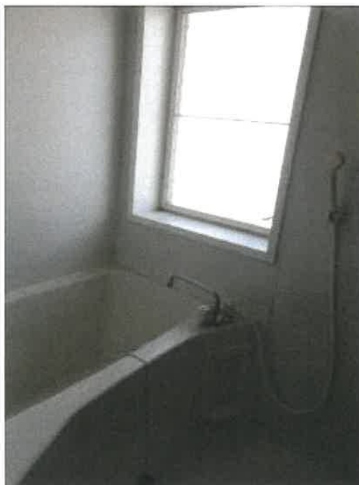
物件 5 建物 2 0 2 号室浴室の状況
