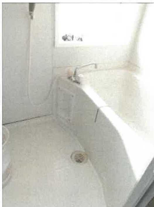
物件 5 建物 2 0 1 号室浴室の状況
