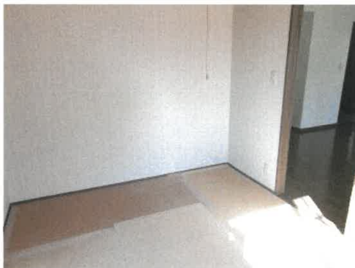
物件6建物102号室北側和室の状況
