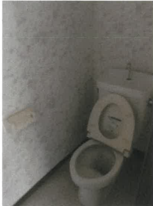
物件6建物102号室トイレの状況
