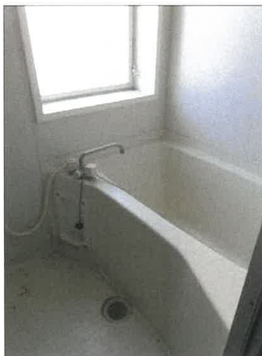
物件 5 建物 1 0 1 号室浴室の状況
