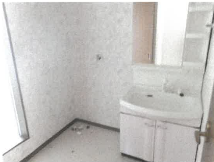
物件 5 建物 1 0 1 号室洗面脱衣所の状況
