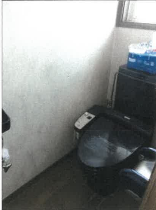
物件4 建物の2階居宅部分のトイレの状況
