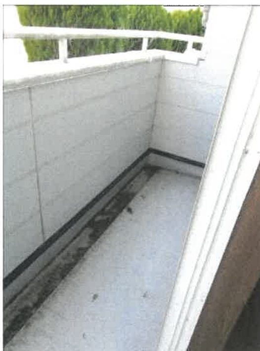
物件5建物101号室ベランダの状況
