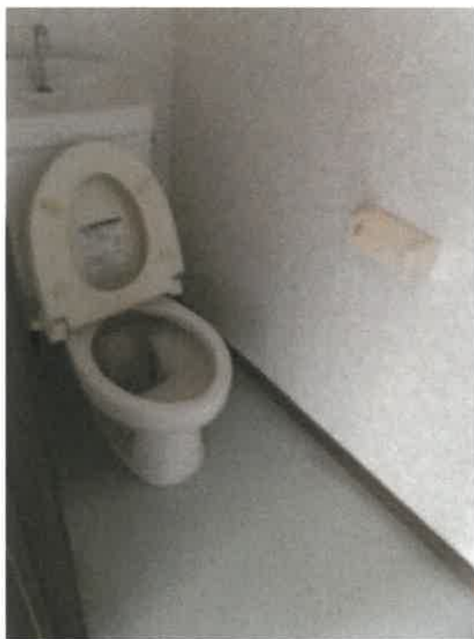
物件6建物101号室トイレの状況
