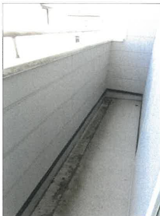
物件 6 建物 2 0 1 号室ベランダの状況
