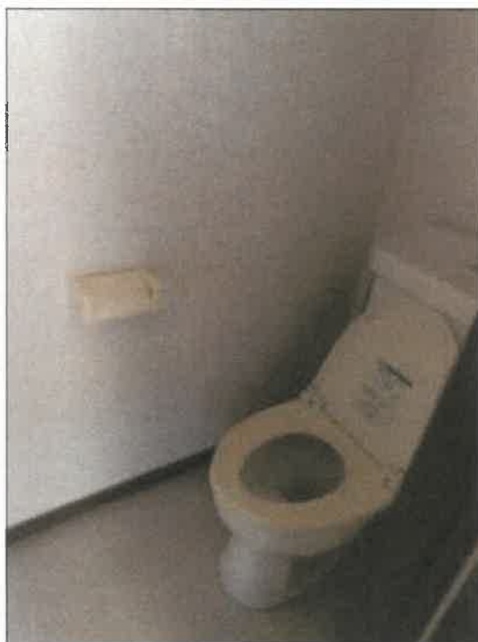
物件5建物202号室トイレの状況
