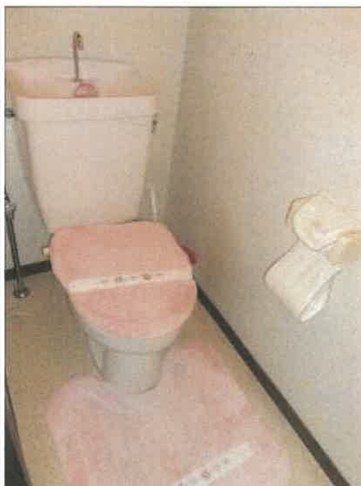
物件5建物201号室トイレの状況
