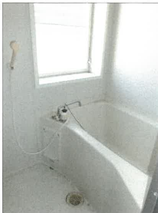
物件6建物101号室浴室の状況
