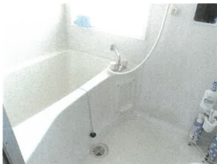
物件 6 建物 2 0 2 号室浴室の状況
