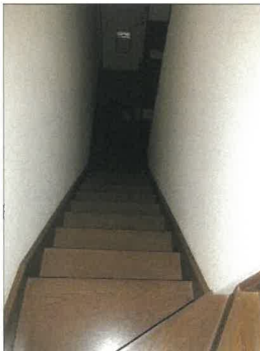
物件 6 建物 2 0 1 号室階段の状況
