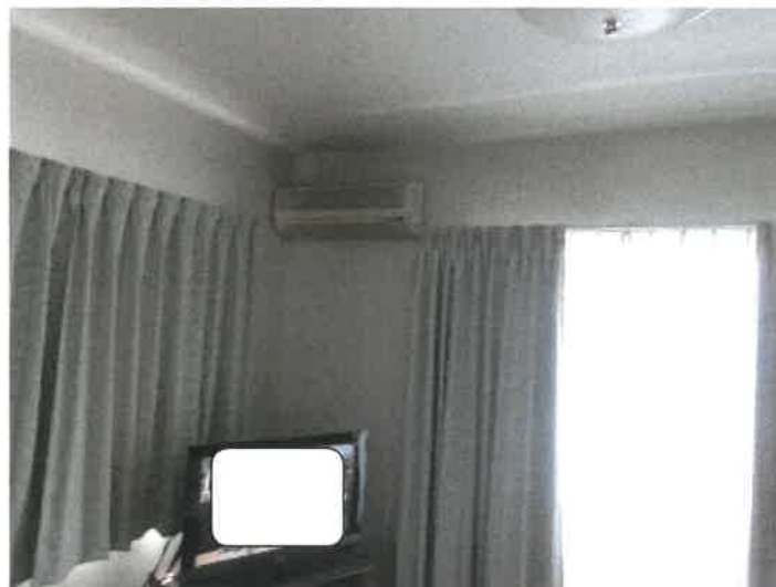
物件 5 建物 2 0 1 号室南側洋室の状況
