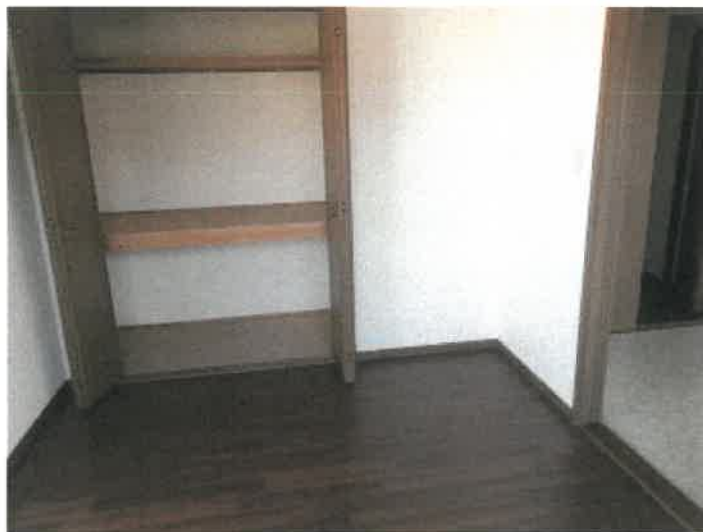
物件 6 建物 2 0 1 号室南側洋室の状況
