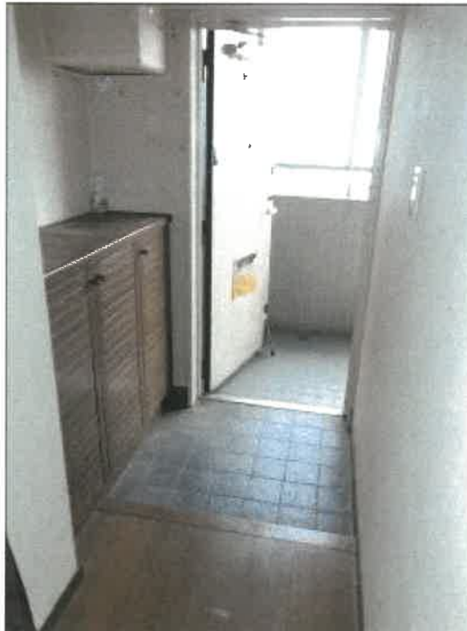
受命物件（301号室）の玄関内の状況
