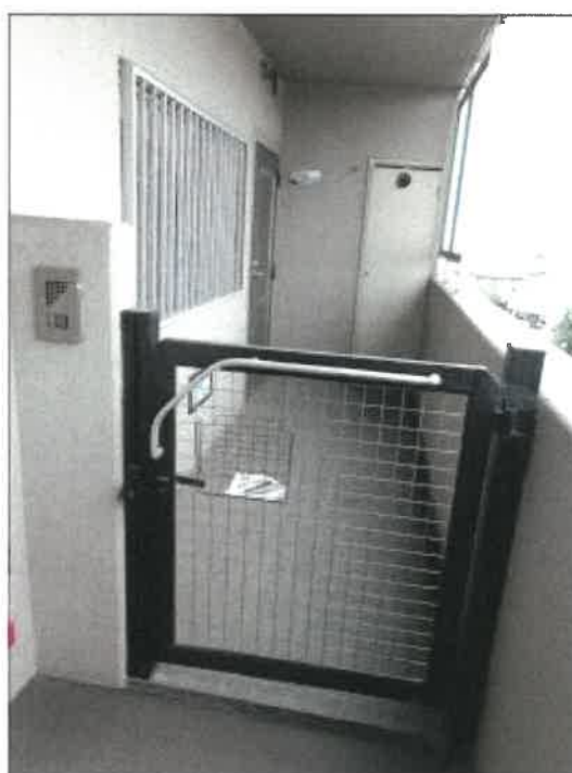
受命物件（301号室）の玄関門扉付近の状況
