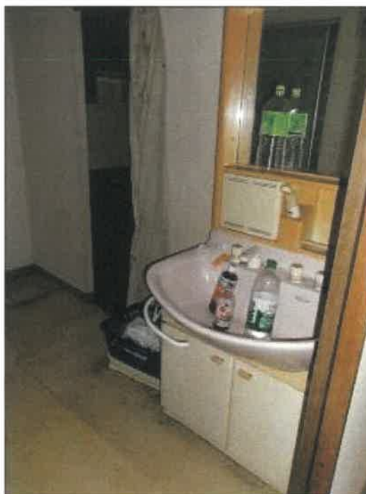
受命物件（301号室）の洗面脱衣所の状況
