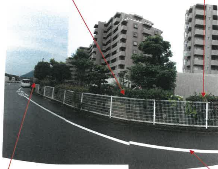
物件1 符号2 土地及び符号1 土地北東側境界付近の状況
