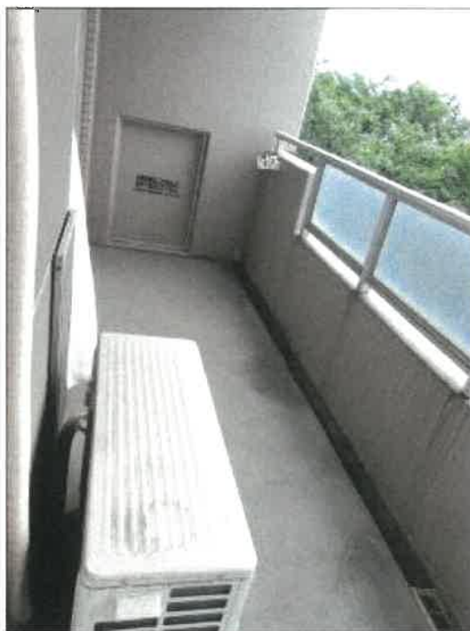
受命物件（301号室）のベランダの状況
