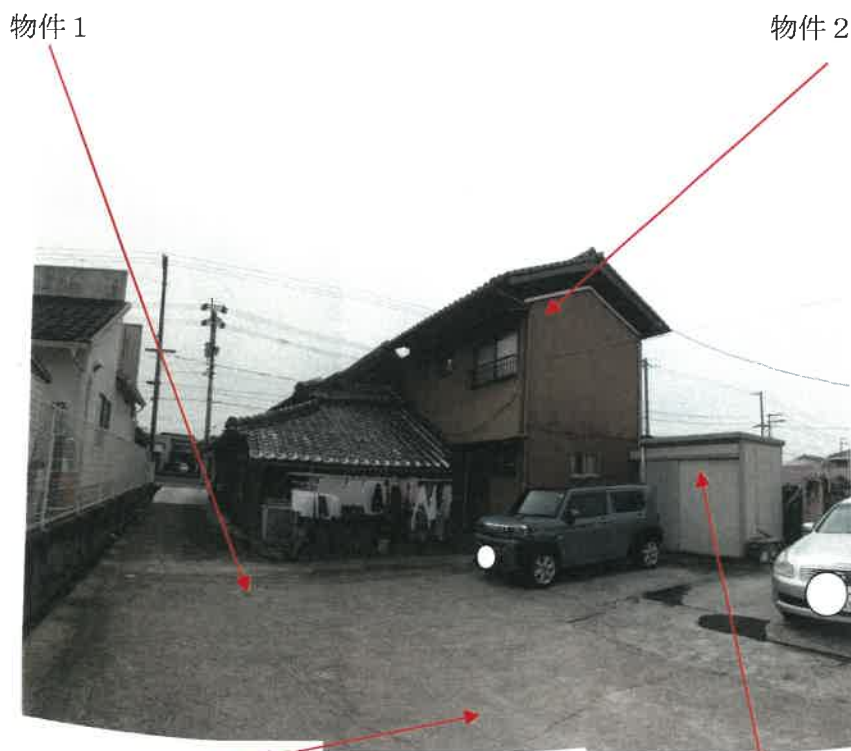
物件2 建物の北東側及び南東側の状況
