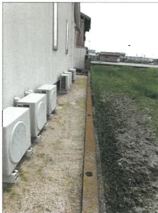
物件 3 建物北西側の状況
