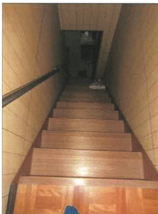
物件2建物の階段の状況
