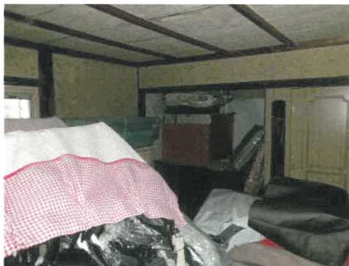
物件 2 建物の 1 階南西端中央の和室 8 畳の南東側和室 4 畳の状況
