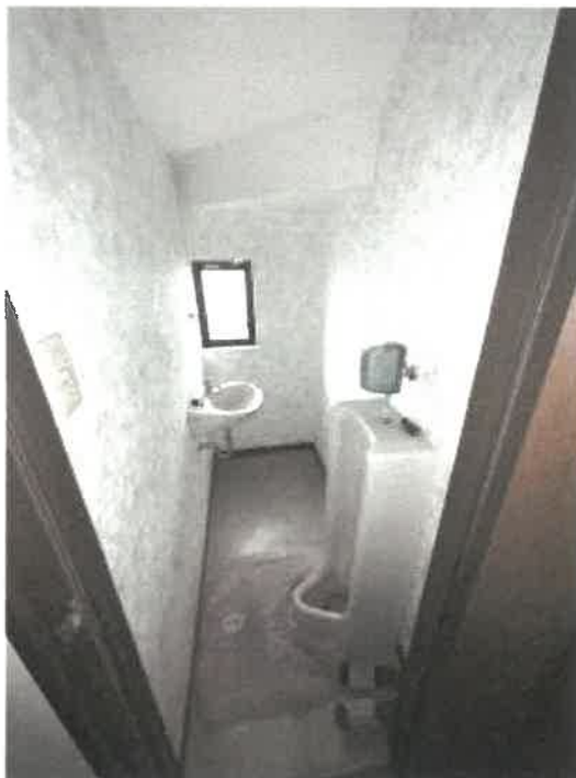
物件2 1階トイレ（小）の状況
