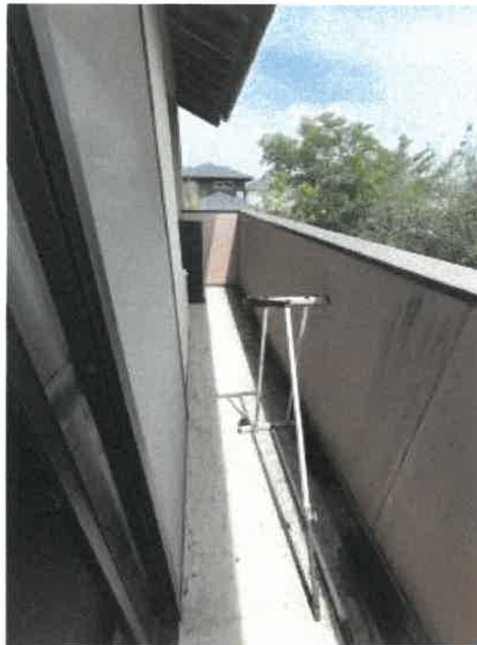
物件2 ベランダの状況
