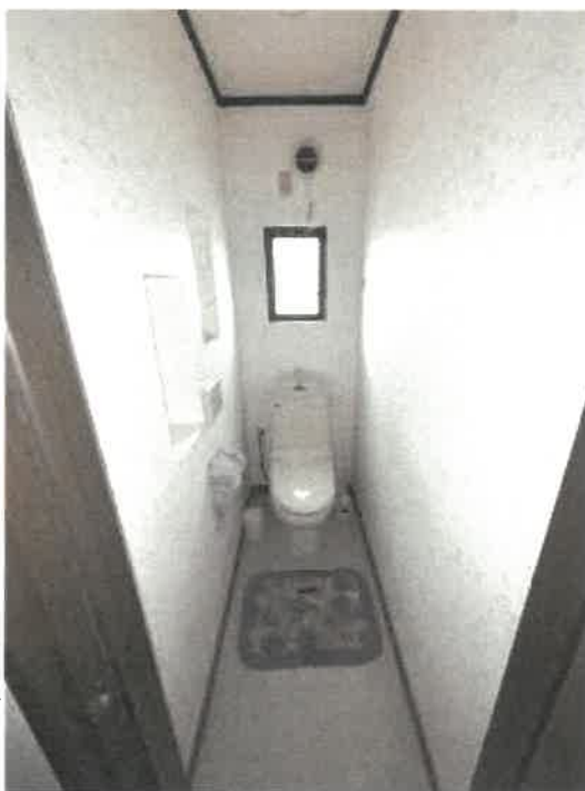
物件2 1階トイレ（大）の状況
