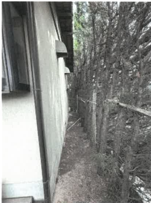
物件1 西側の状況
