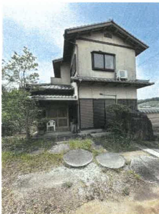
物件1 中央部付近の状況
