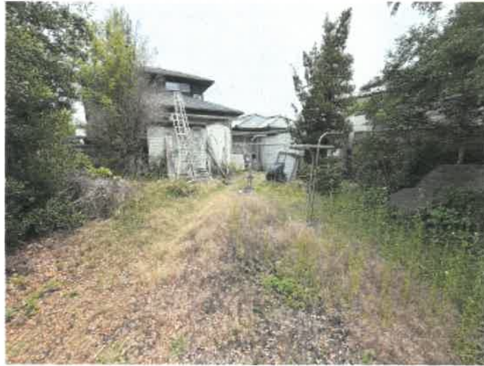
物件 1 南東側の状況
