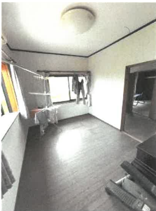
物件2 2階東側洋室の状況
