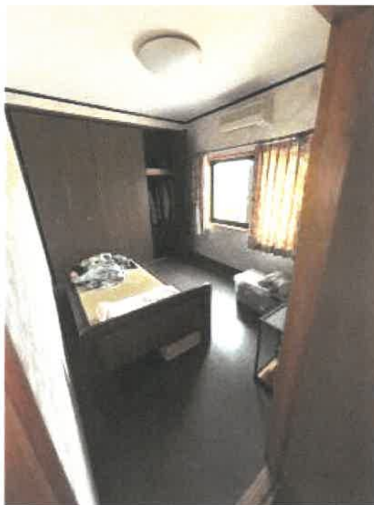
物件 2 2階北西側洋室の状況
