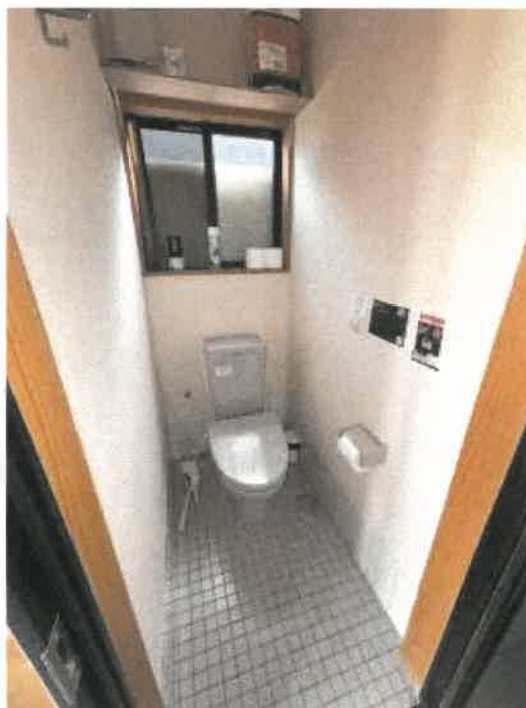
物件2 女性用トイレの状況
