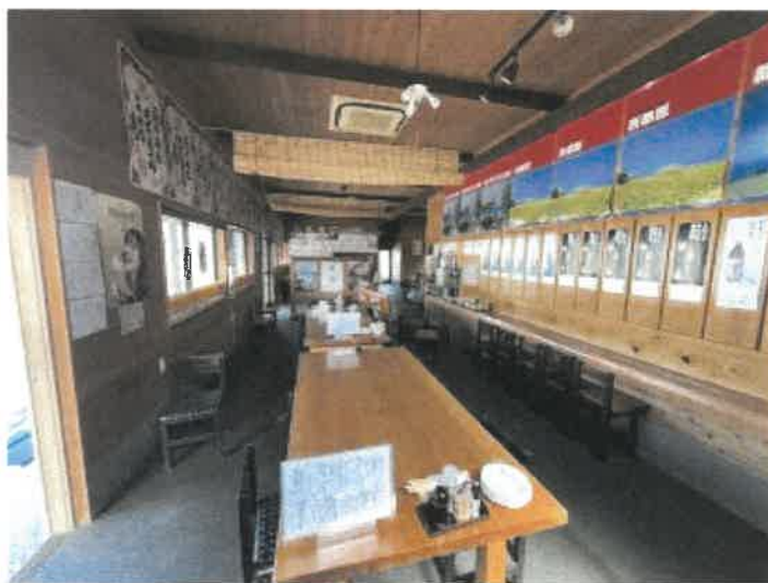
物件2 店舗南東側の状況
