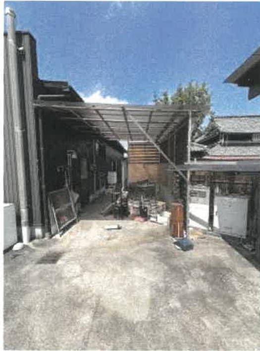
物件2 北東側下屋の状況
