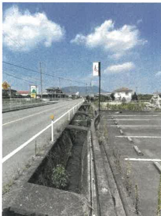
物件1 南側の状況
