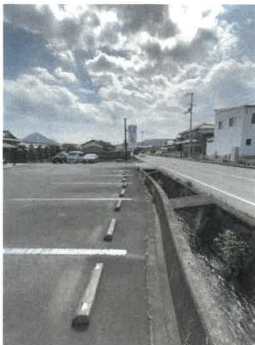
物件1 南西側の状況
