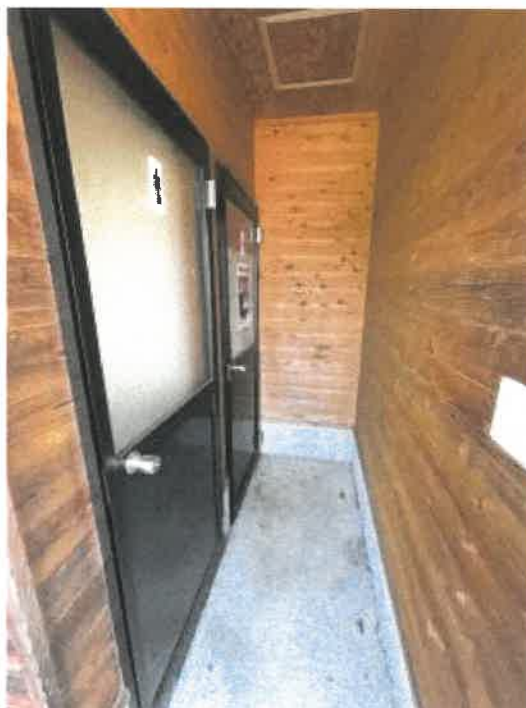
物件 2 北西側トイレ前の状況
