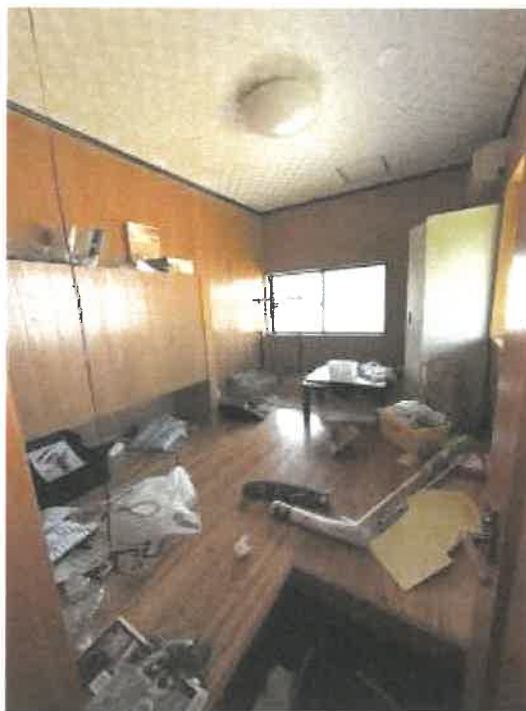
物件 2 事務室・休憩室の状況
