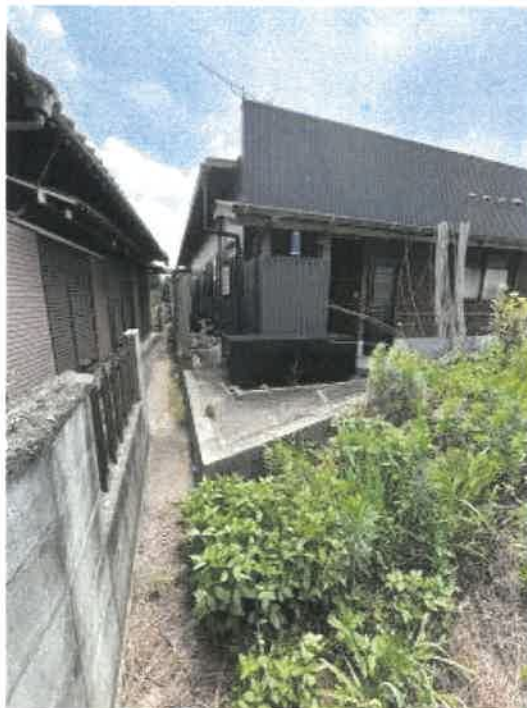
物件1 北西側の状況
