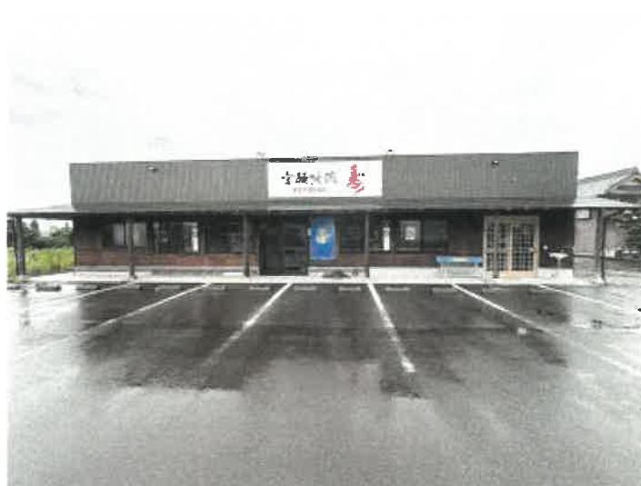
物件2 南側の状況
