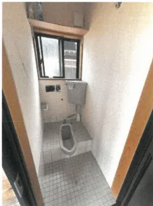
物件2 男性用トイレの状況
