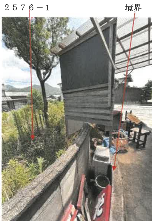
物件2 北東側下屋の状況
