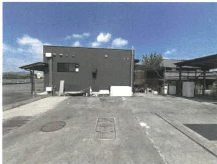
物件2 東側の状況
