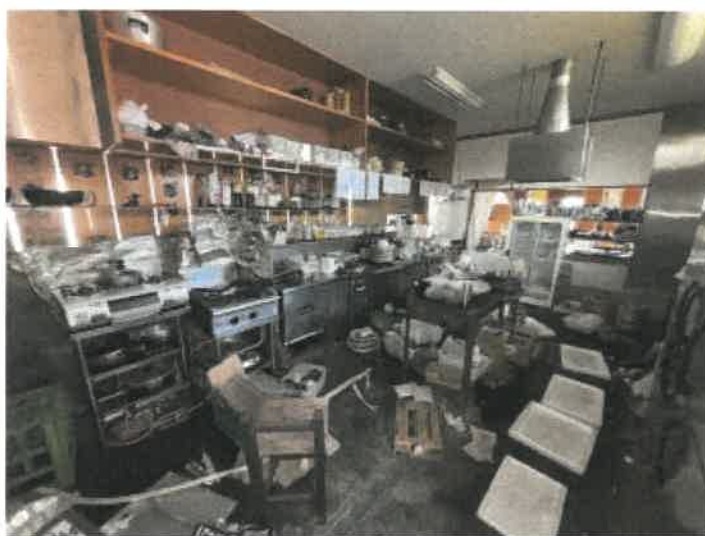
物件2 厨房内の状況
