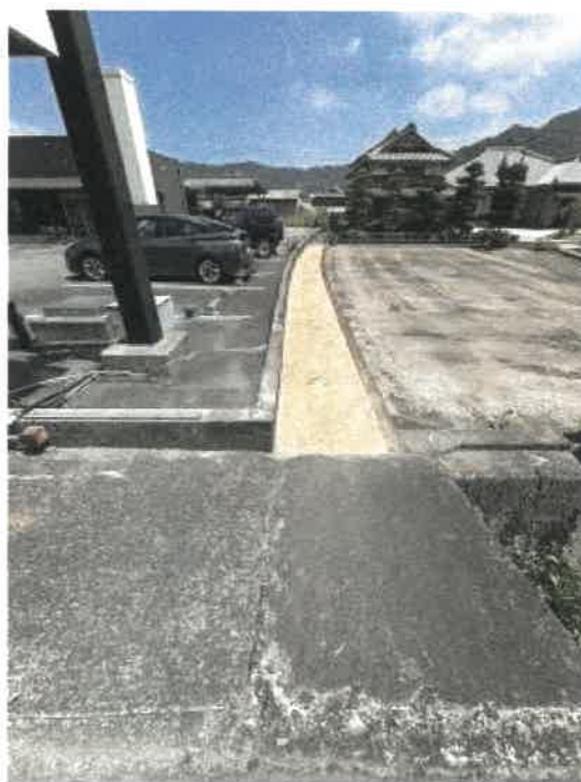
物件1 東側境界付近の状況
