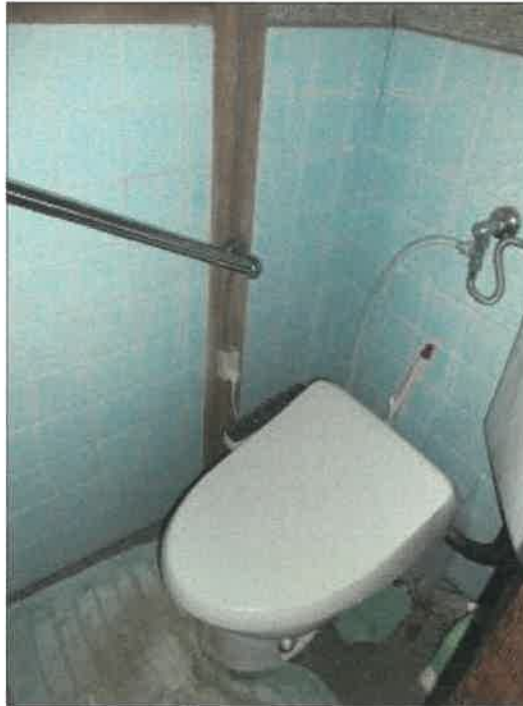
物件2建物の1階トイレの状況
