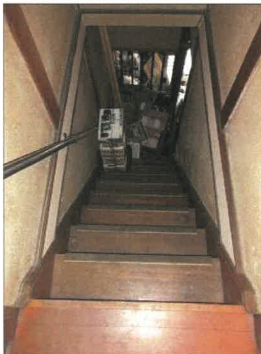
物件2建物の階段の状況
