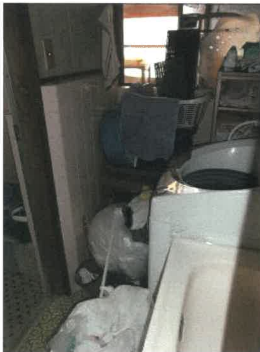
物件 2 建物の 1 階洗面脱衣所の状況
