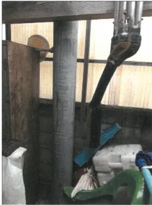
物件1 土地北東角の宅内電柱の状況
