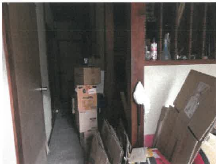
物件 2 建物玄関内の玄関前廊下の状況
