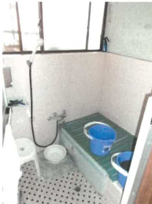
物件2建物の1階浴室の状況
