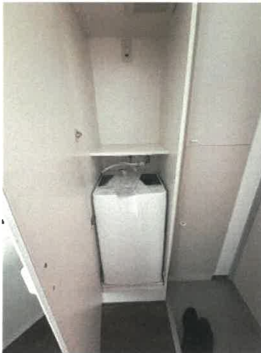
洗濯機置場の状況
