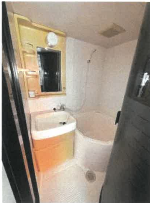
ユニットバスの状況
