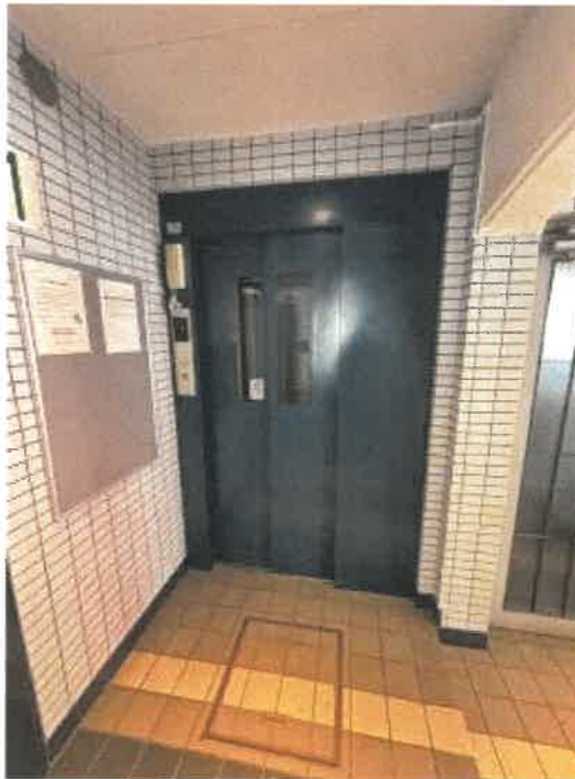
エレベータ前の状況
