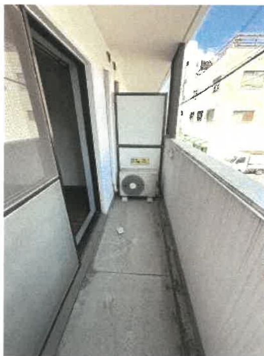
バルコニーの状況
