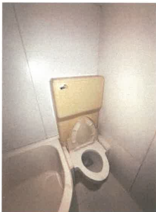
ユニットバスの状況
