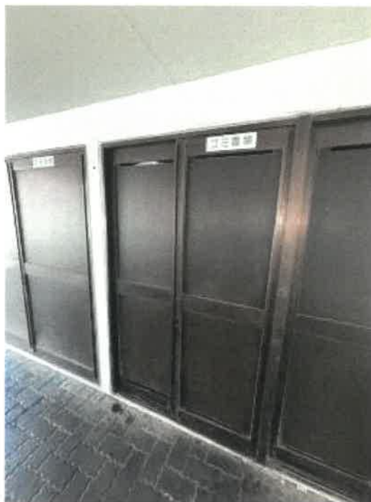
ゴミ置場の状況
