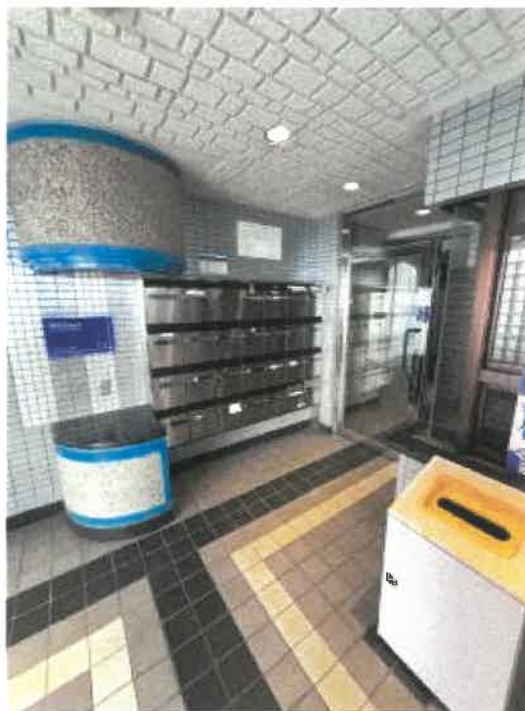
マンション入口付近の状況
