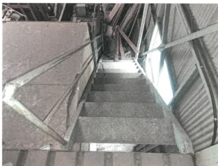
物件 8 建物の倉庫・作業所の南側ロフト部分への階段の状況
