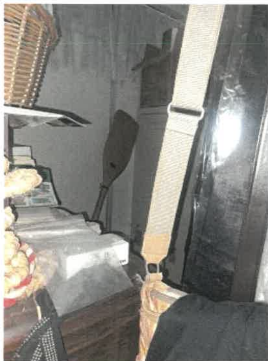
物件 8 建物の北東側の事務所部分の北側書庫の状況
