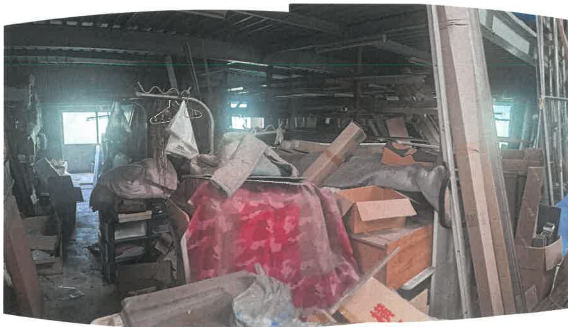
物件 8 建物の倉庫・作業所の南側洋室西側の状況
