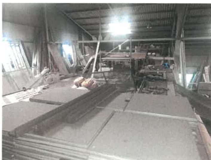
物件 8 建物の倉庫・作業所の南側ロフト部分の状況
