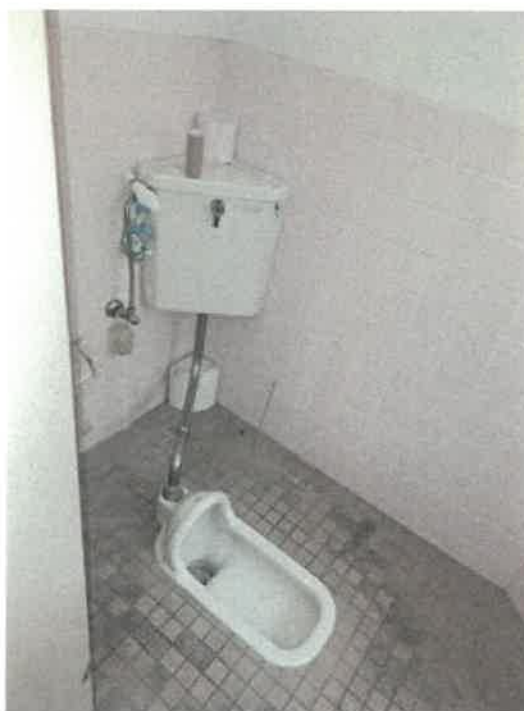
物件8 建物の北東側の事務所部分の東側トイレの状況
