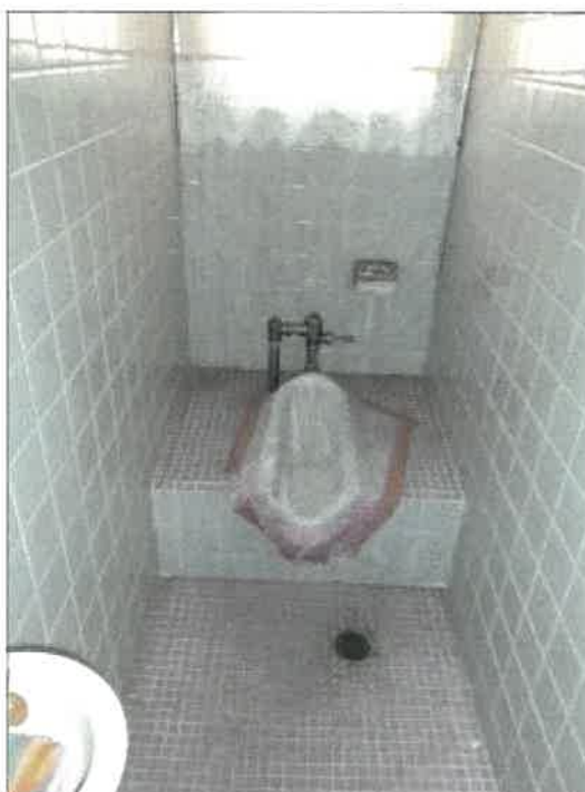
物件2 建物の3階南側東側のトイレの状況
