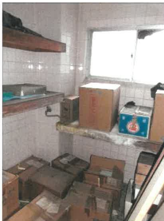
物件2建物の2階北東角浴室の状況
