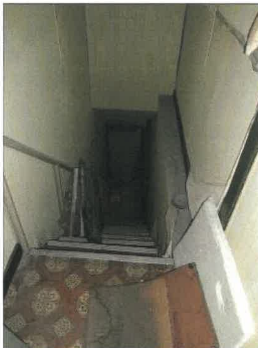
物件 4 建物の 2 階から 1 階への階段の状況
