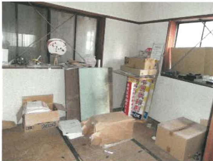
物件 4 建物の 2 階東側居室部分東側和室の状況
