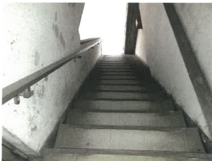
物件 2 建物の 2 階から 1 階への階段の状況
