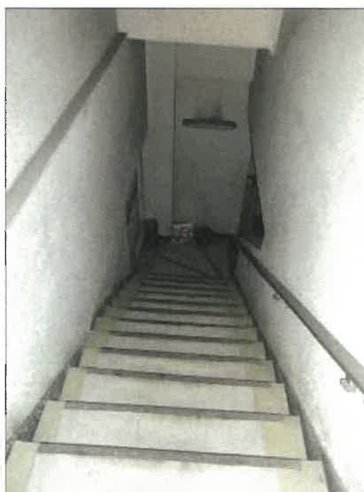
物件2物の3階から2階への階段の状況
