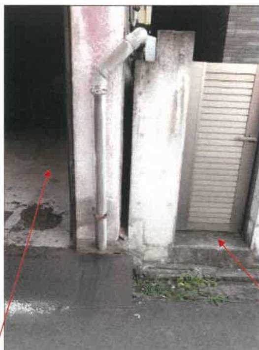
物件3土地南側境界付近の状況 物件3 目的外土地19番14
