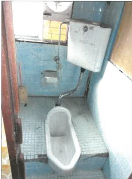
物件 4 建物の 2 階事務所のトイレの状況
