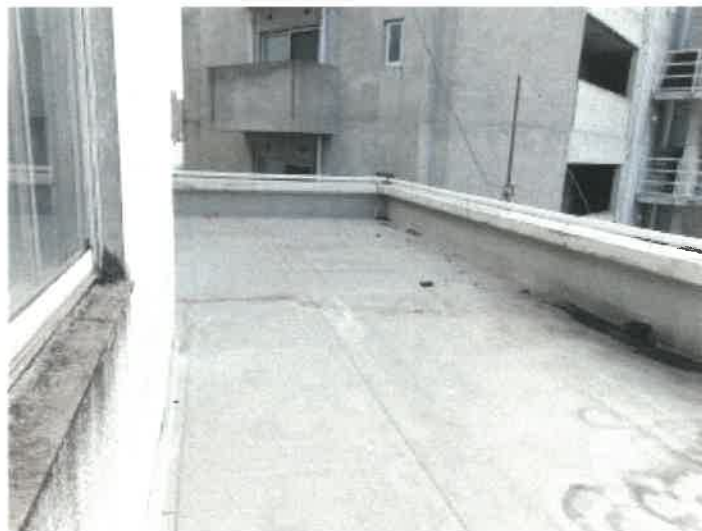
物件 2 建物の 4 階屋上の状況
