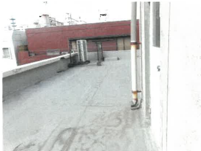
物件 2 建物の 4 階屋上の状況
