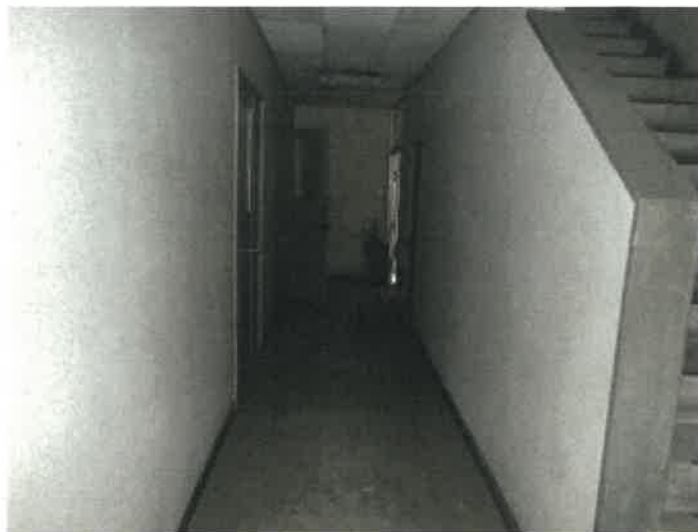
物件2建物の2階室外廊下の状況
