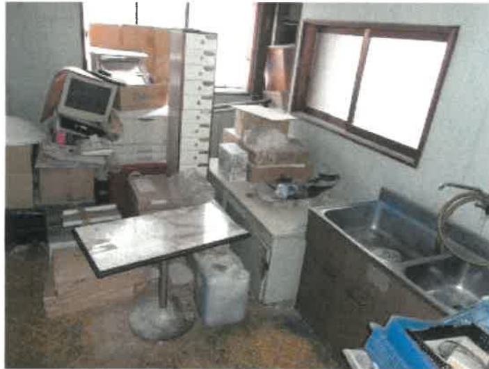
物件 4 建物の 2 階東側居室部分東側キッチンの状況
