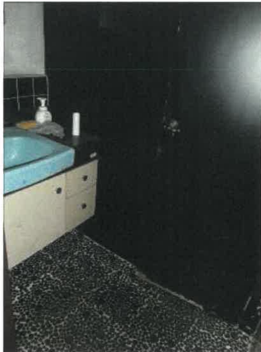
物件 4 建物の 1 階トイレの状況
