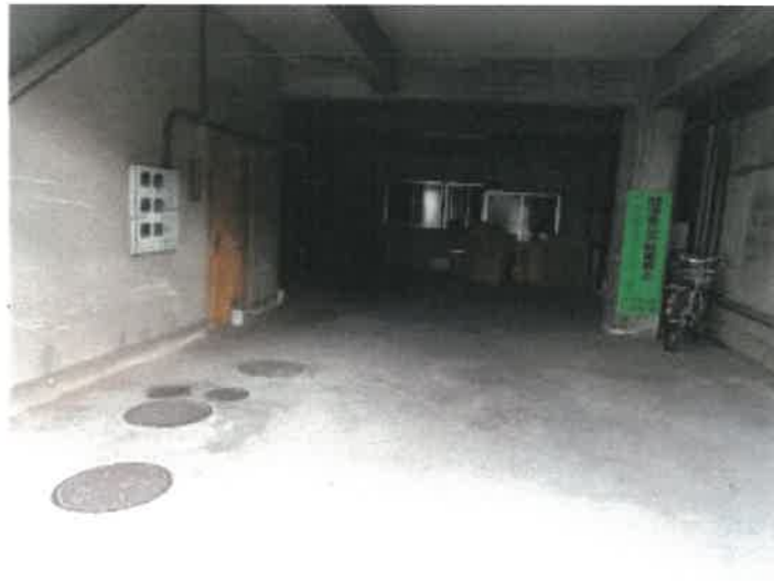
物件 2 建物の 1 階駐車場部分の状況
