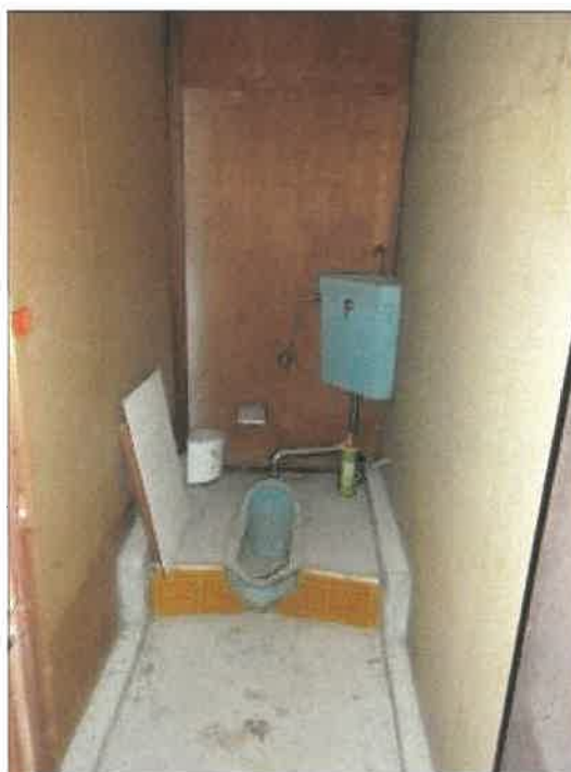
物件 4 建物の 2 階東側居室部分のトイレの状況
