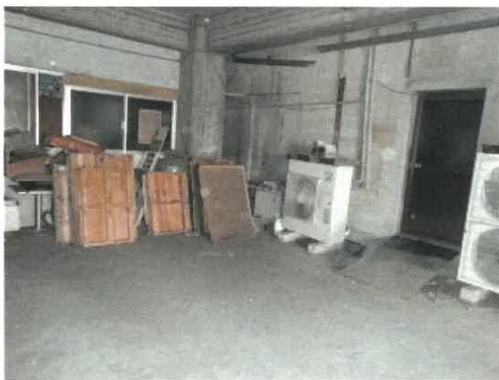
物件 4 建物 1 階駐車場部分の状況
