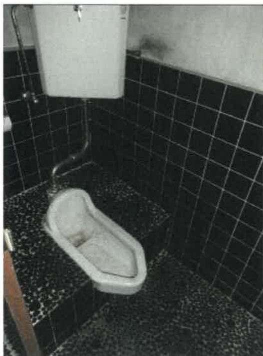
物件 4 建物の 1 階トイレの状況
