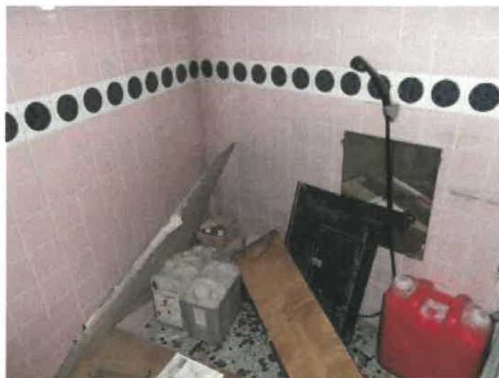
物件 4 建物の 1 階南東角浴室の状況
