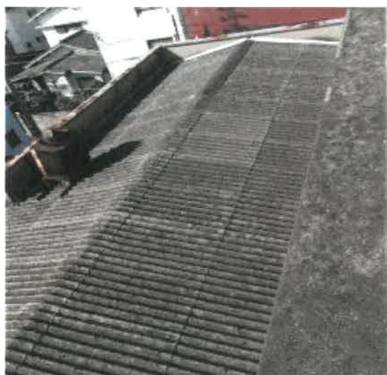
物件 4 建物の屋根の状況
