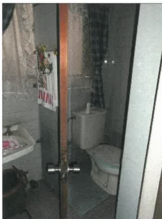
物件2建物の2階室外トイレ・洗面所の状況
