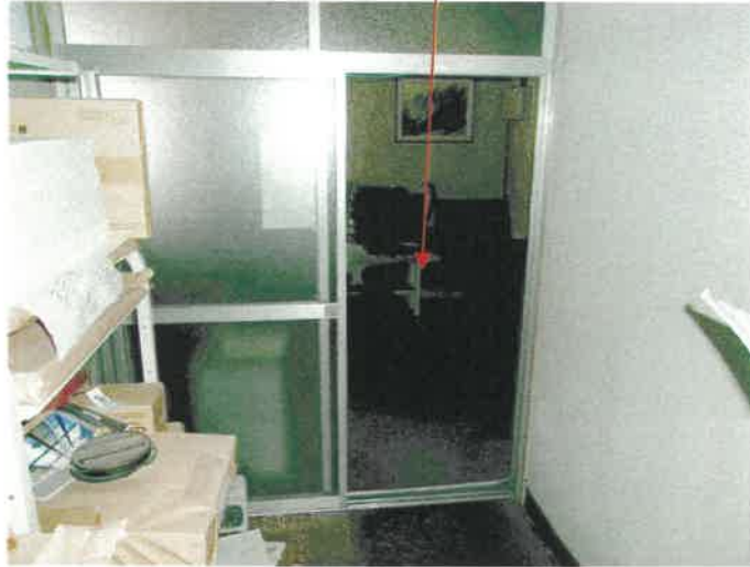
物件 4 建物の 2 階事務所から物件 2 建物事務所への通路の状況
