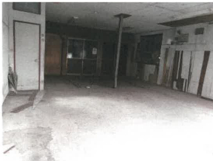
物件 4 建物 1 階駐車場部分の状況
