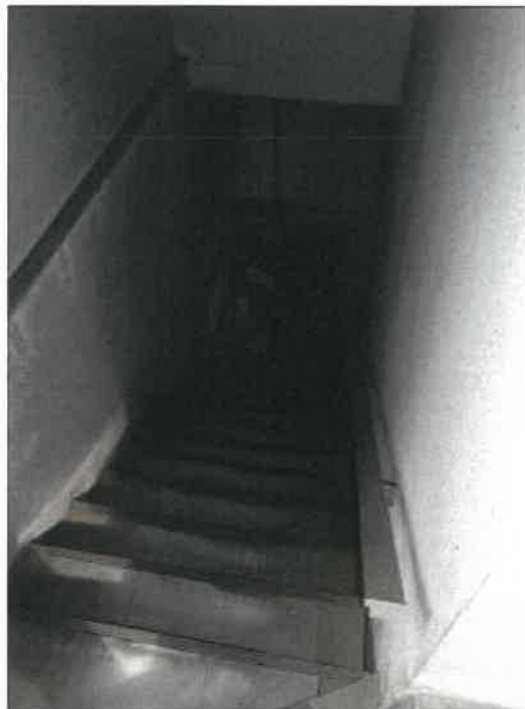
物件2建物の4階から3階への階段の状況
