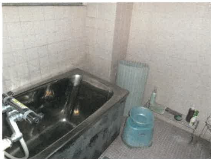
物件2建物の3階浴室の状況
