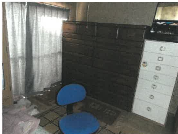
物件 2 建物の 3 階リビング東側和室の状況
