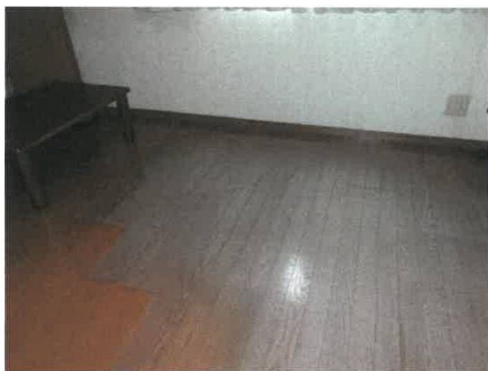
物件2建物の2階中の洋室の状況
