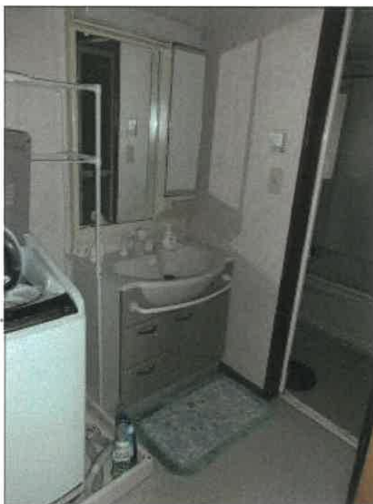
物件2建物の1階洗面脱衣所の状況
