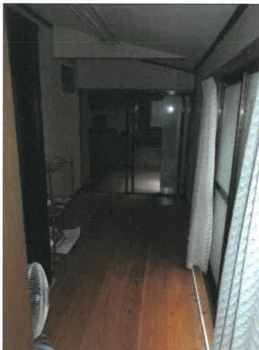
物件3主である建物北端ホール（廊下）部分の状況（増築部分） 物件2建物の1階LDK
