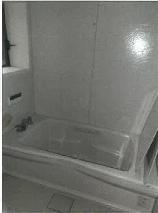
物件 2 建物の 1 階浴室の状況
