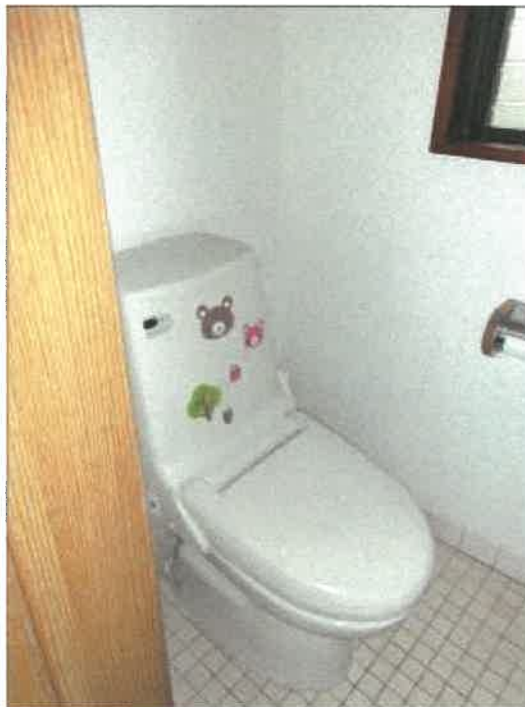
物件 2 建物の 1 階トイレの状況
