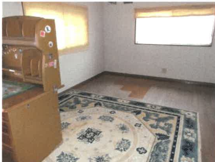
物件 2 建物の 2 階北端洋室の状況
