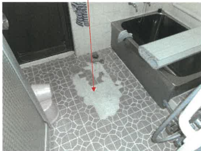
物件 3 主である建物浴室の状況
