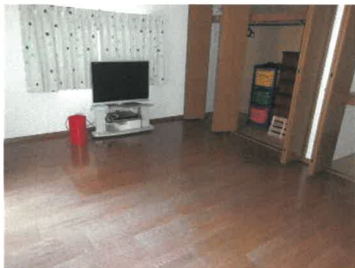
物件2建物の2階南端洋室の状況
