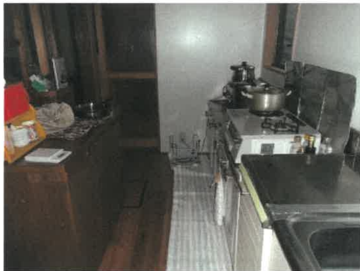
物件3主である建物北端台所部分の状況（増築部分）
