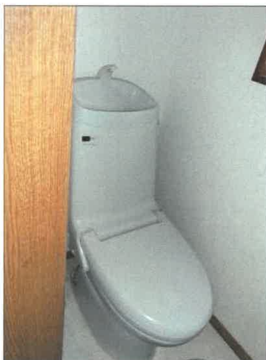
物件 2 建物の 2 階トイレの状況
