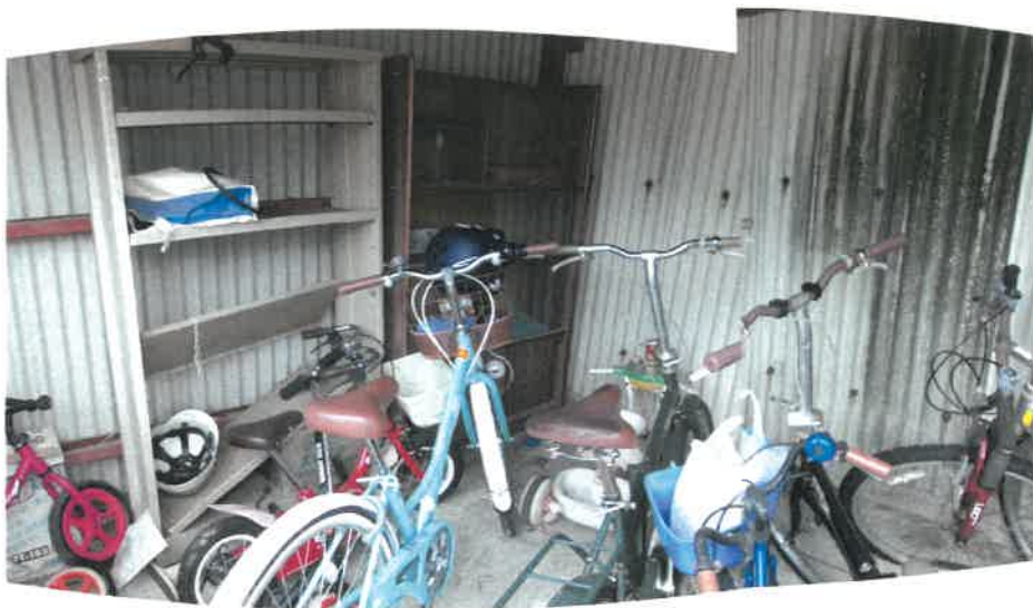
物件3附属建物南東側自転車置場の状況
