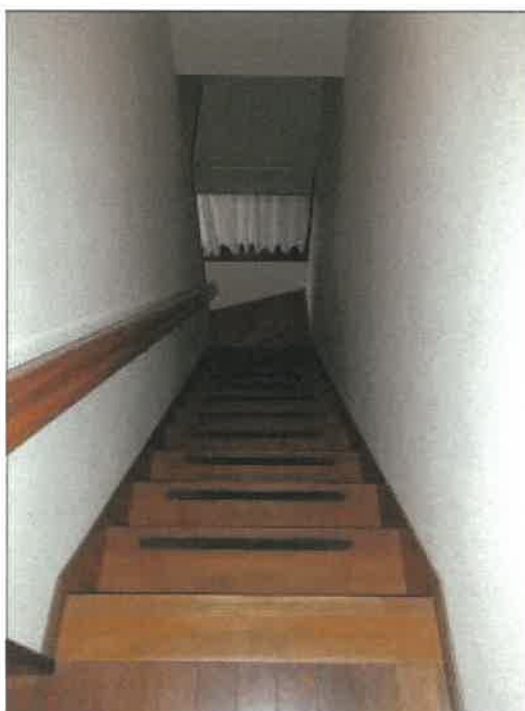
物件 2 建物の階段の状況
