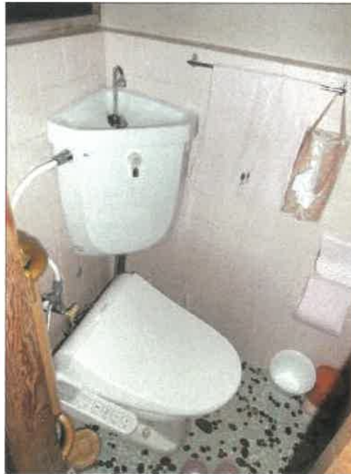
物件 3 主である建物トイレの状況 水漏れの補修
