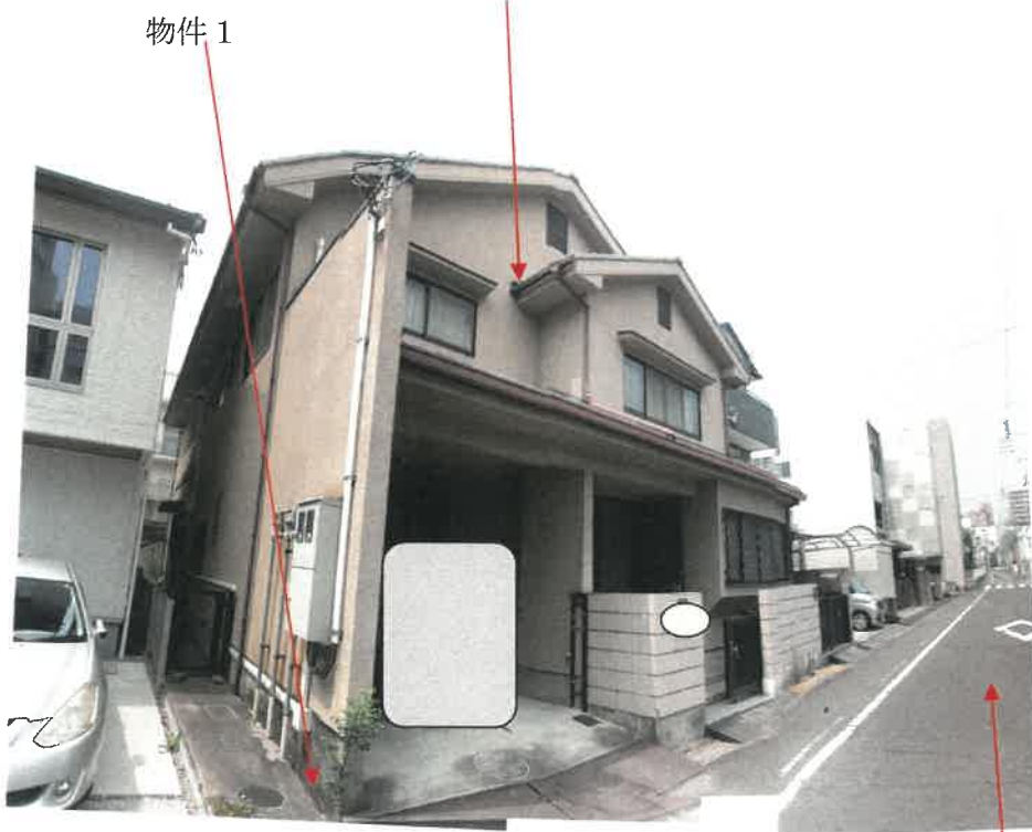
物件 1 土地北側及び東側境界付近の状況
