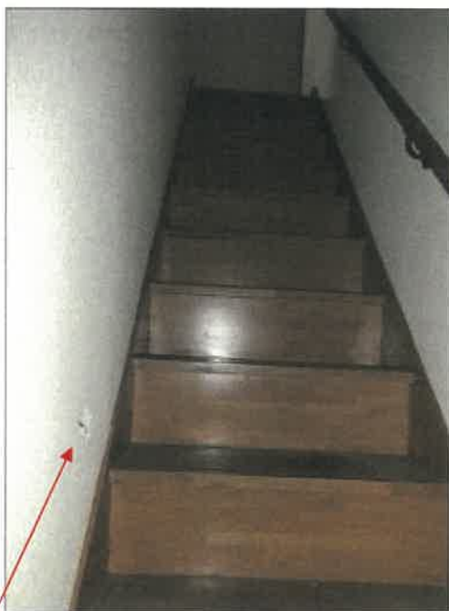
物件 2 建物の階段の状況
