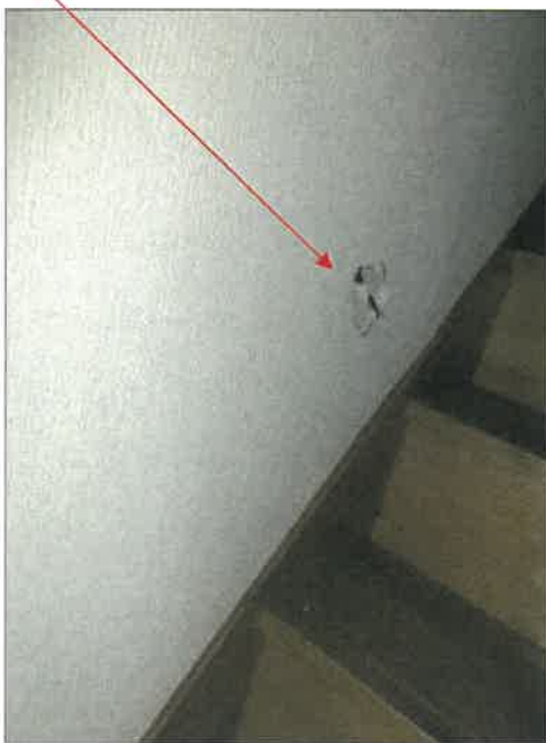
物件 2 建物の階段の状況
