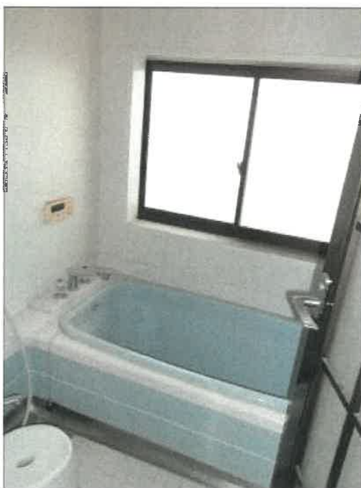
物件2建物の2階の浴室の状況
