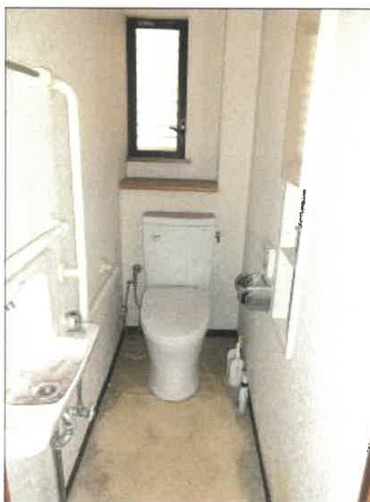
物件 2 建物の 1 階トイレの状況
