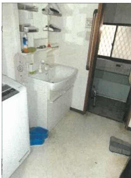
物件 2 建物の 1 階洗面脱衣所の状況
