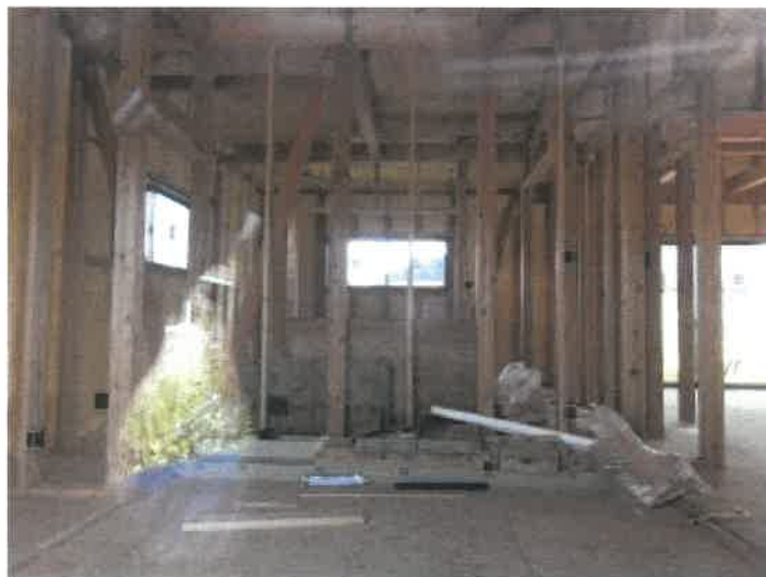
目的外建物（未登記）の内部の状況（サッシ窓から）
