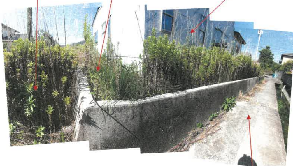
物件1 土地北側境界付近の状況
