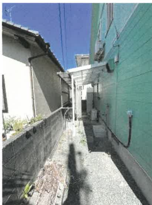
物件 2 南西側の状況
