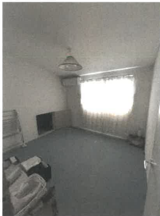
物件3 2階東側洋室の状況
