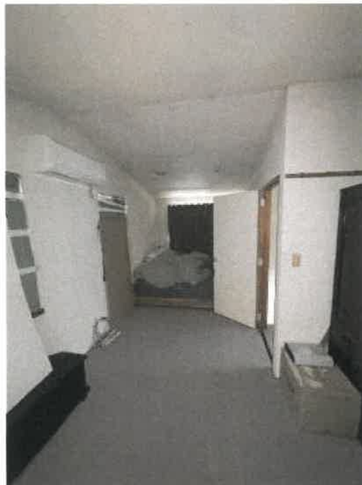
物件3 2階南側洋室の状況
