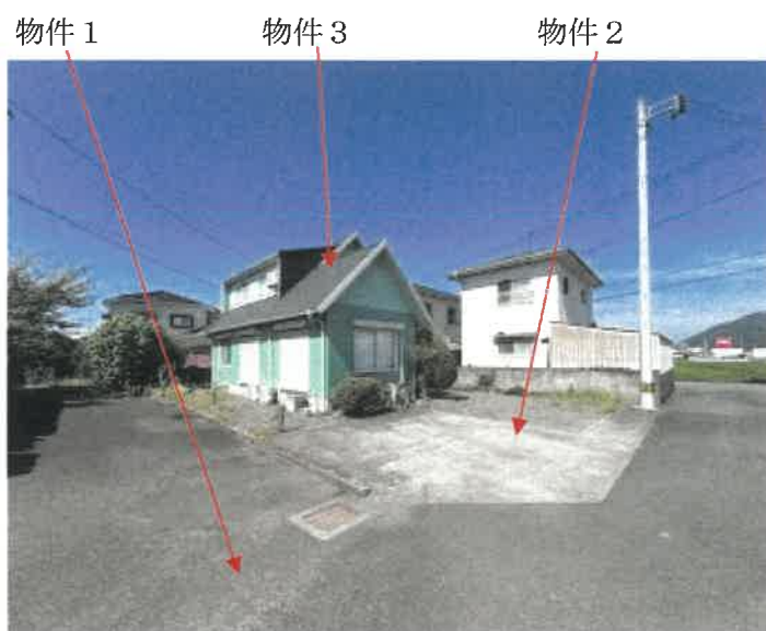
物件 2 北東側の状況
