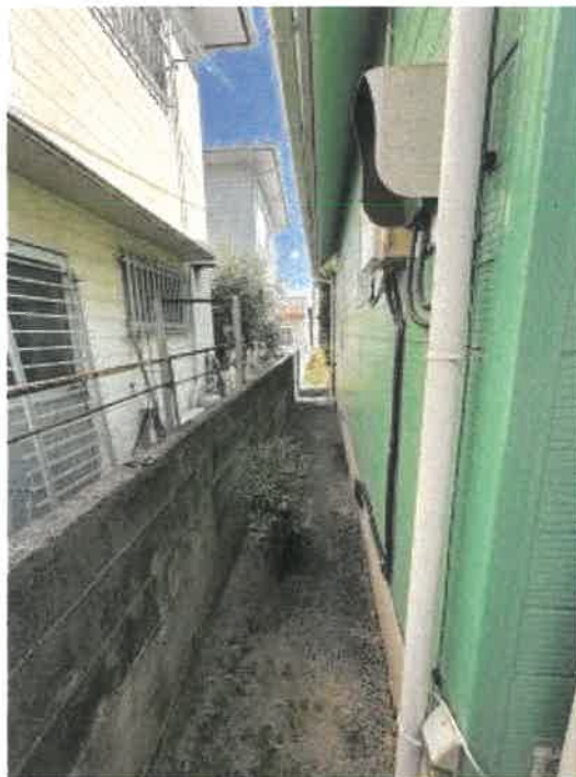
物件2 北西側の状況
