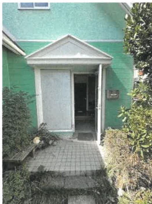
物件3 玄関付近の状況
