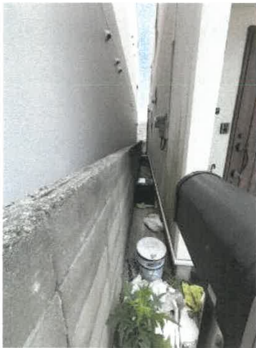
本件物件北西側の状況
