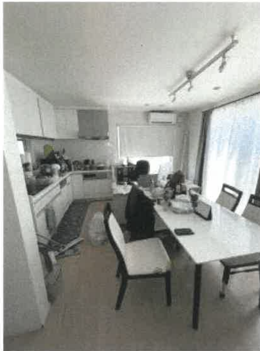
物件2 1階台所の状況
