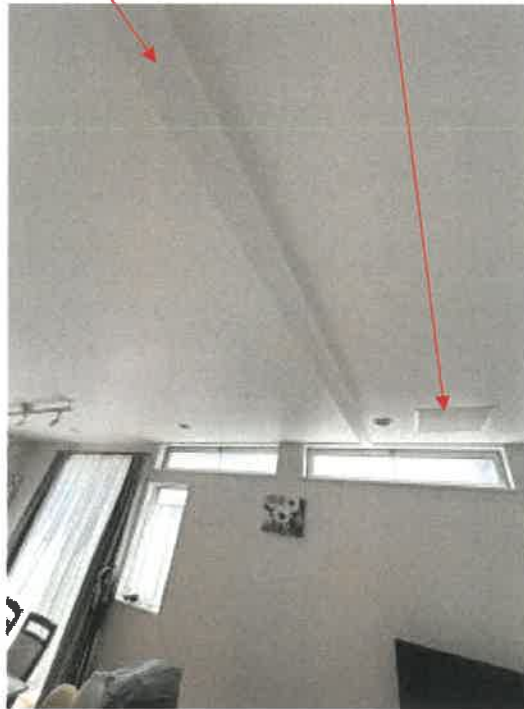
物件2 1階天井の状況
