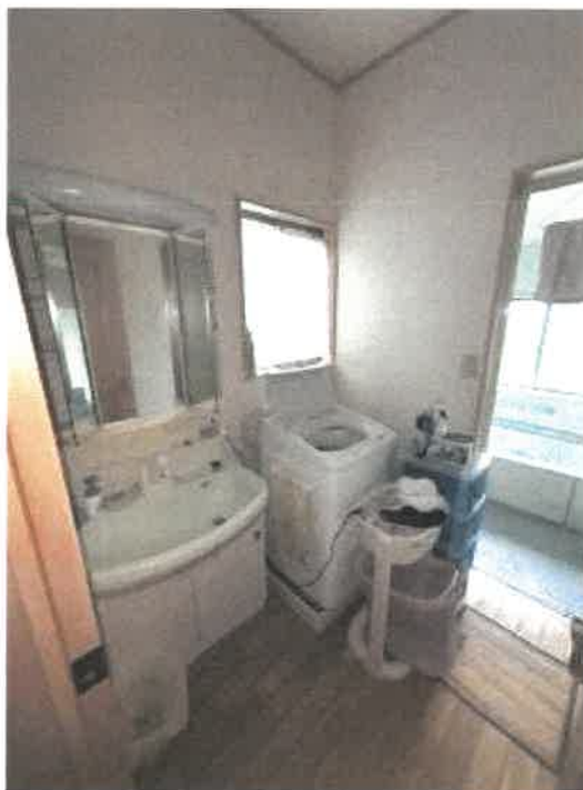
物件2 1階洗面・脱衣所の状況
