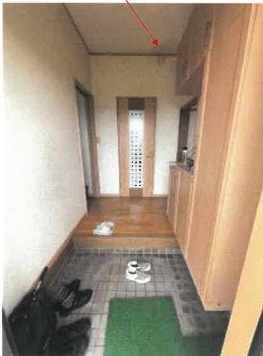
物件2 玄関内の状況
