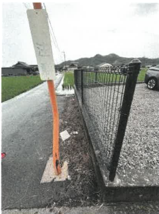
本件物件北西側の状況
