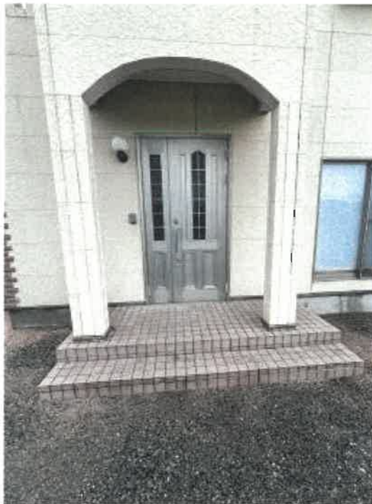
物件2 玄関付近の状況
