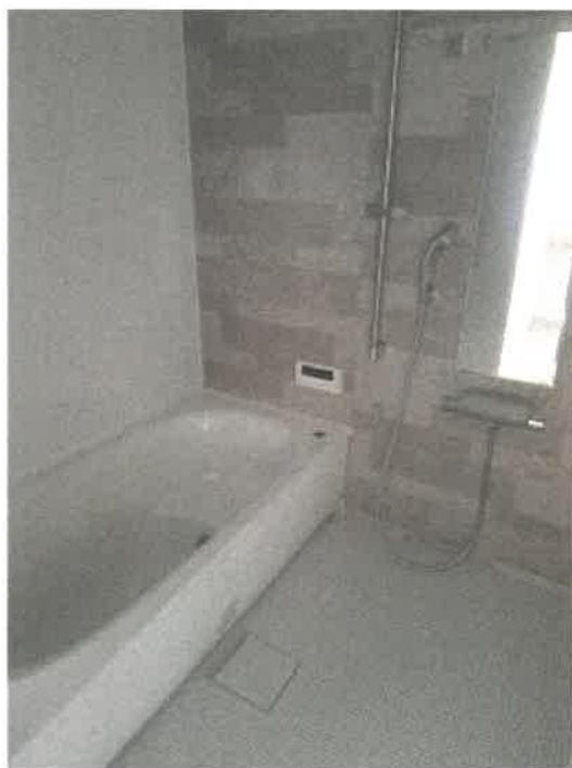
物件 2 建物の浴室の状況
