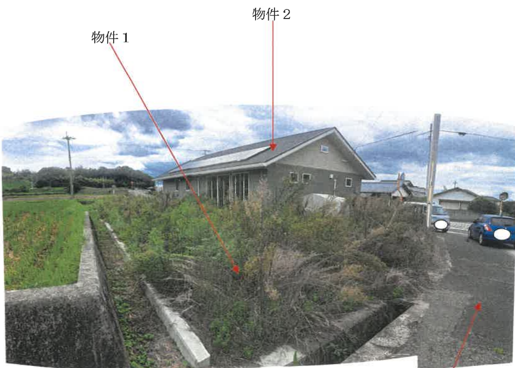
物件1 土地東側及び南側境界付近の状況
