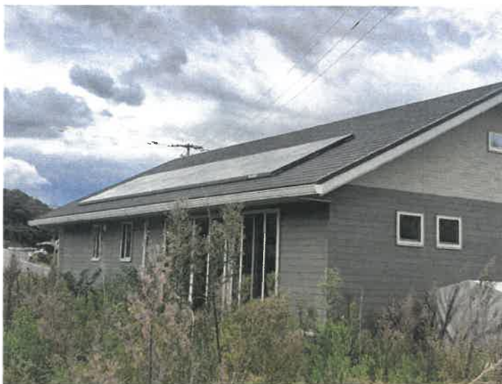
物件 2 建物の屋根の太陽光発電パネル設置の状況
