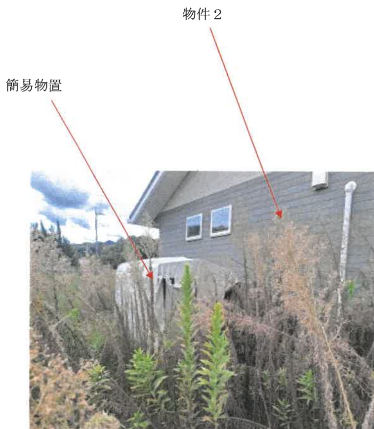
物件 2 東側の簡易物置設置状況
