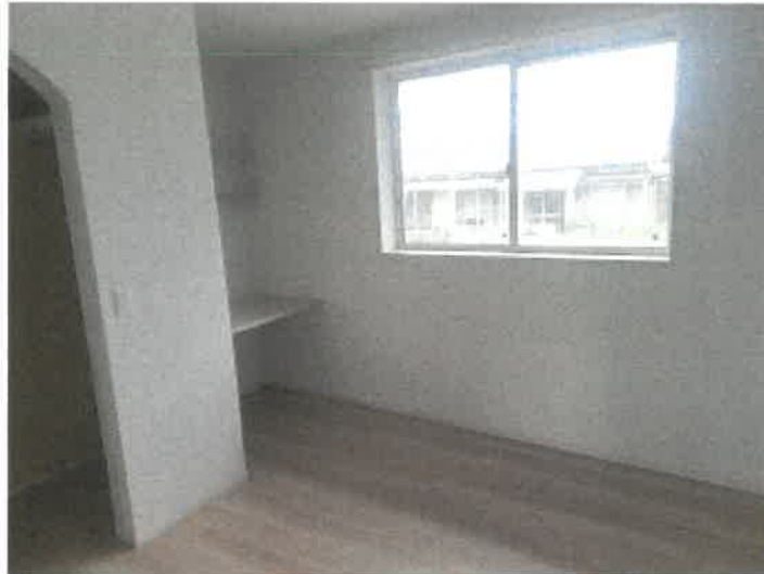
物件 2 建物の北側中の洋室の状況
