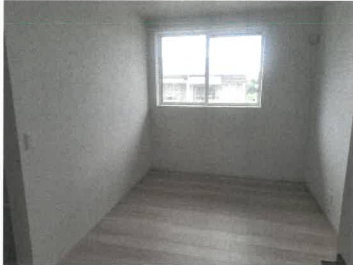
物件 2 建物の北側西端洋室の状況
