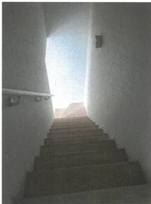
物件2建物のロフトから1階への階段の状況
