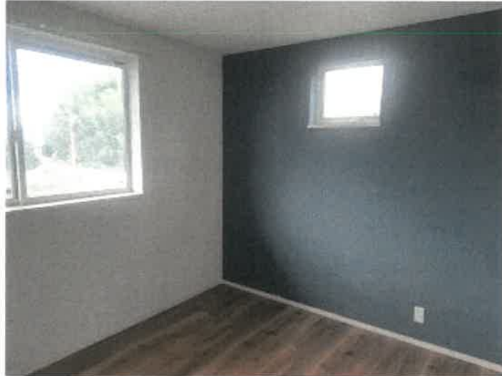
物件 2 建物の北側東端洋室の状況
