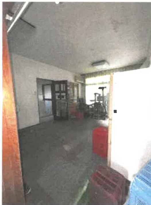
物件2 1階リビングダイニングの状況
