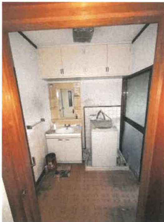
物件2 1階洗面所・脱衣所の状況
