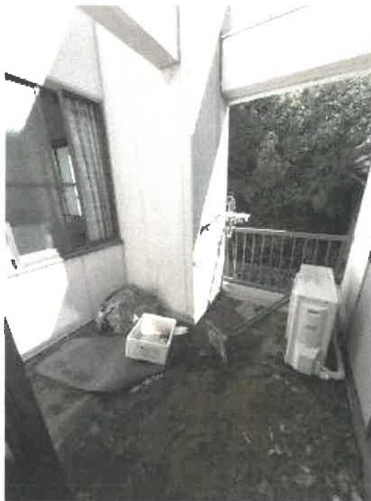
物件2 2階バルコニーの状況
