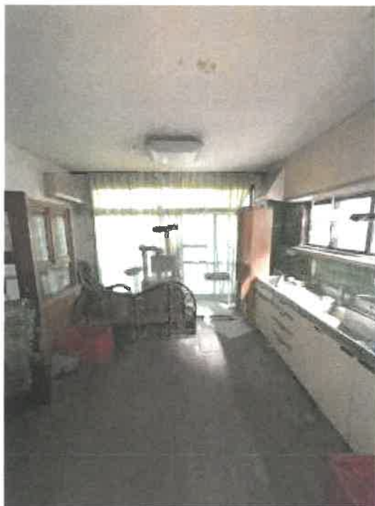
物件2 1階リビングダイニングの状況
