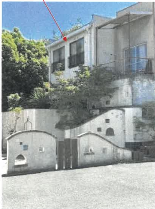
本件物件の北西側の状況
