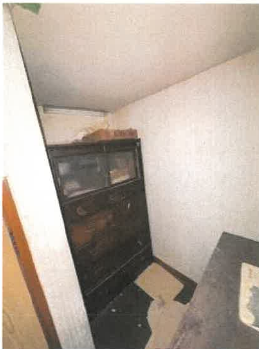
物件2 1階階段下収納の状況
