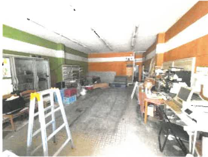
物件2 1階店舗内の状況
