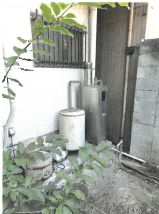
物件 1 北西側の状況
