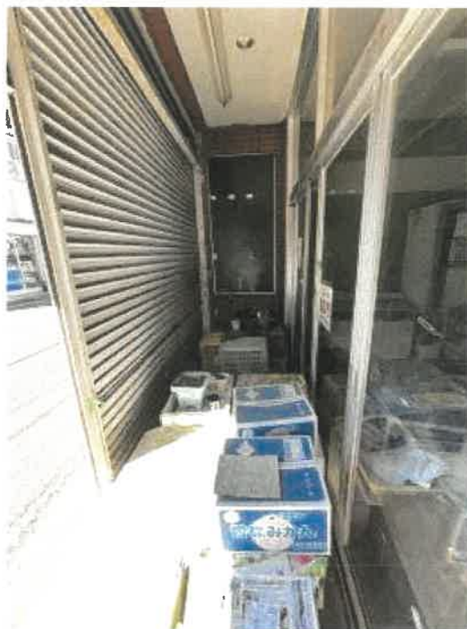
物件 2 南西側の状況
