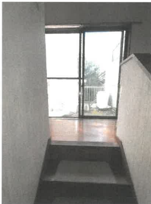
物件2 2階廊下の状況
