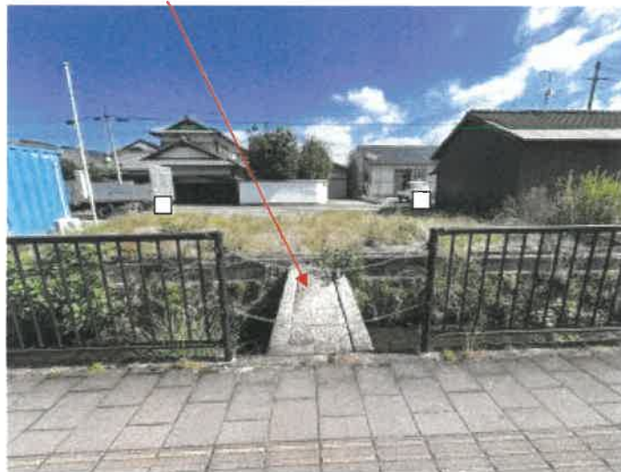
物件1 南西側の状況
