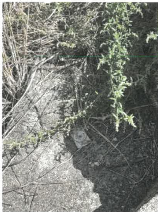
物件 1 南側境界付近の状況
