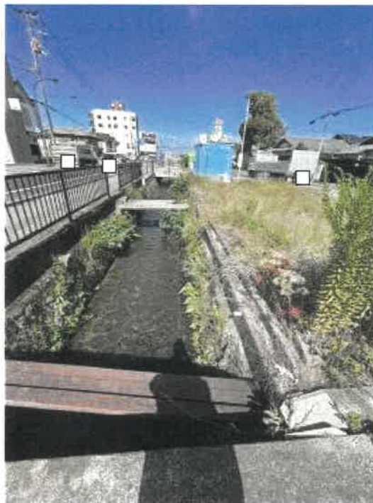
物件1 南側の状況
