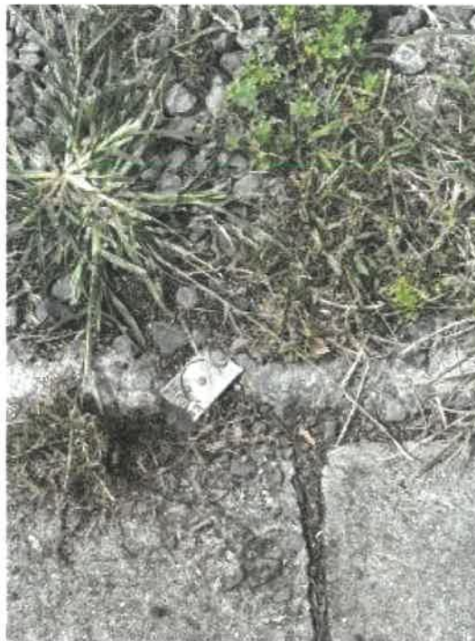
物件1 北側付近の境界標の状況
