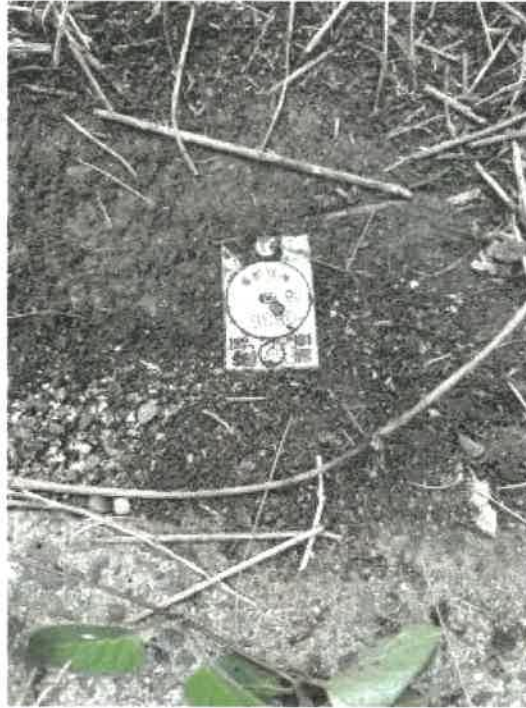
物件 2 北西側の境界標の状況
