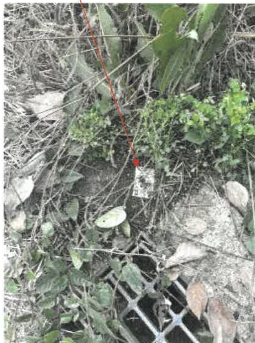
物件 2 北側付近の状況
