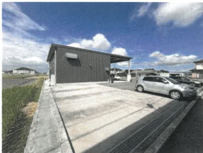
本件物件南東側の状況
