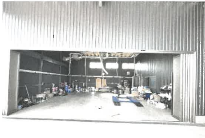
物件2 作業室（倉庫）内の状況
