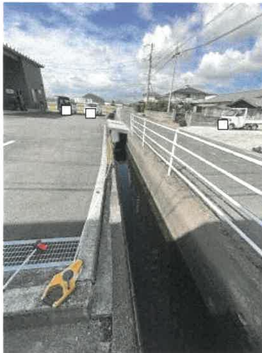
本件物件北東側の状況
