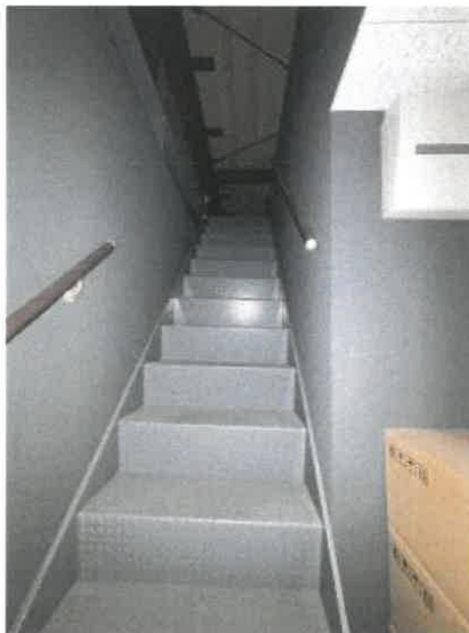
物件2 倉庫内の屋根裏への階段の状況
