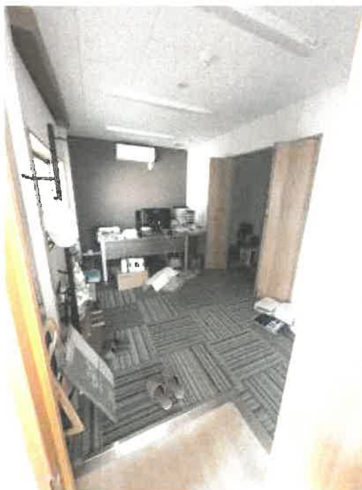
物件 2 事務室奥の休憩室の状況
