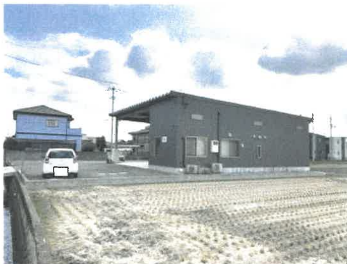
本件物件北西側の状況
