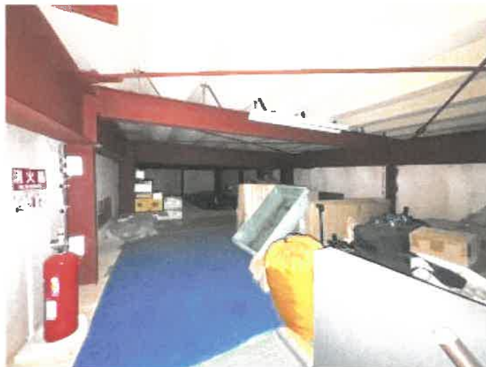
物件2 屋根裏の状況
