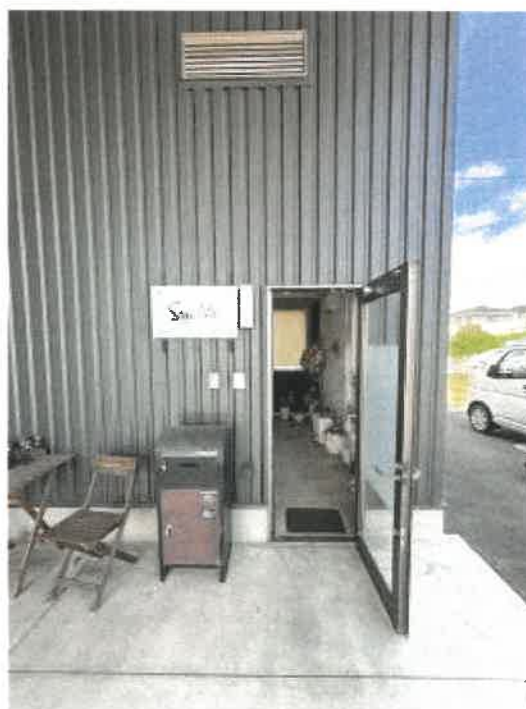
物件2 事務室入口付近の状況
