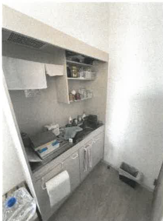
物件 2 事務室内の流し台の状況
