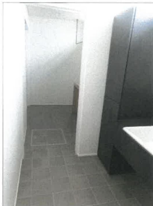
物件 3 建物の洗面所付近の状況
