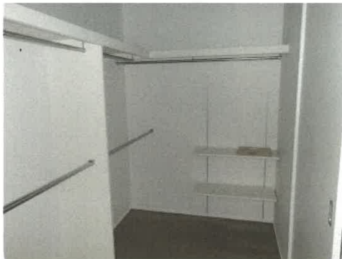
物件 3 建物の北東側W I Cの状況
