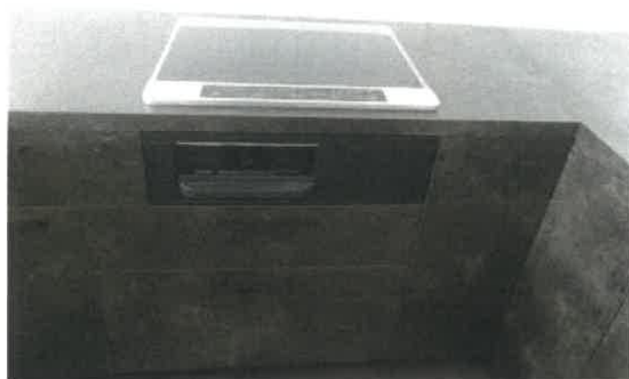
物件 3 建物のキッチンの I H キッキングヒーター設置の状況
