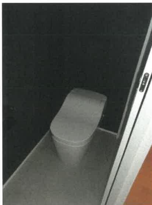
物件3建物のトイレの状況
