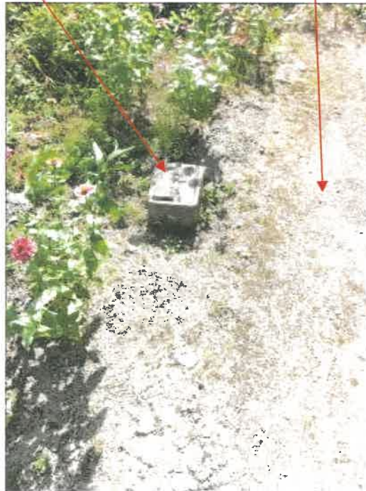
物件1～5, 7土地北西側中央付近の上水道量水器の状況
