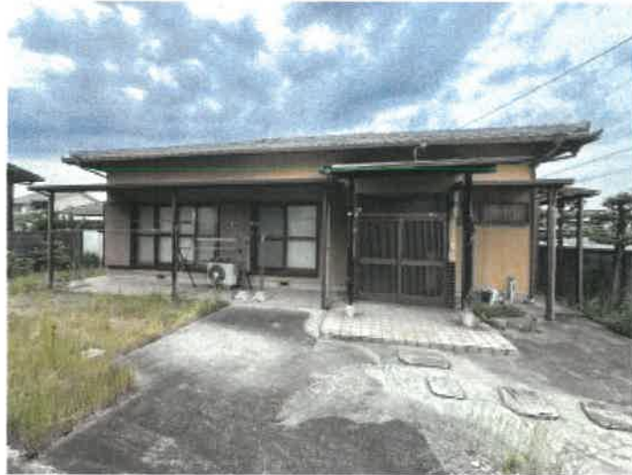
物件2 南東側の状況
