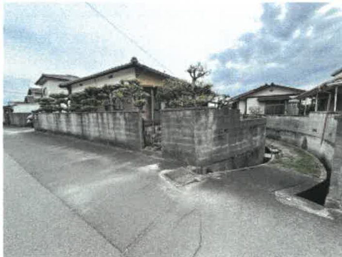
本件物件北東側の状況
