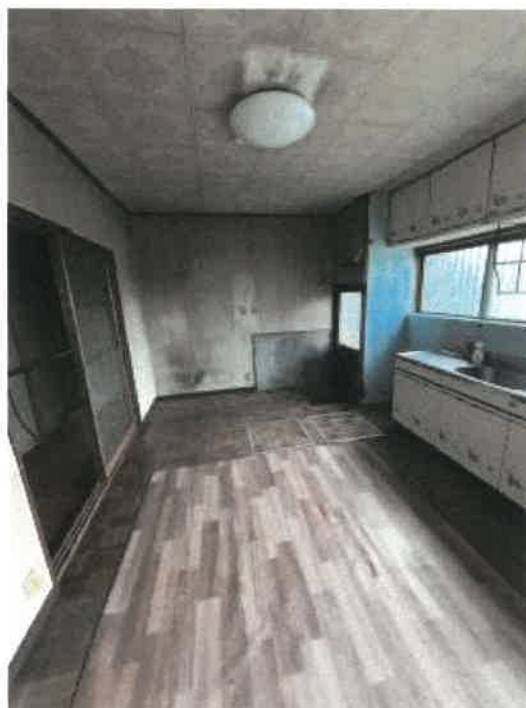
物件2 台所の状況
