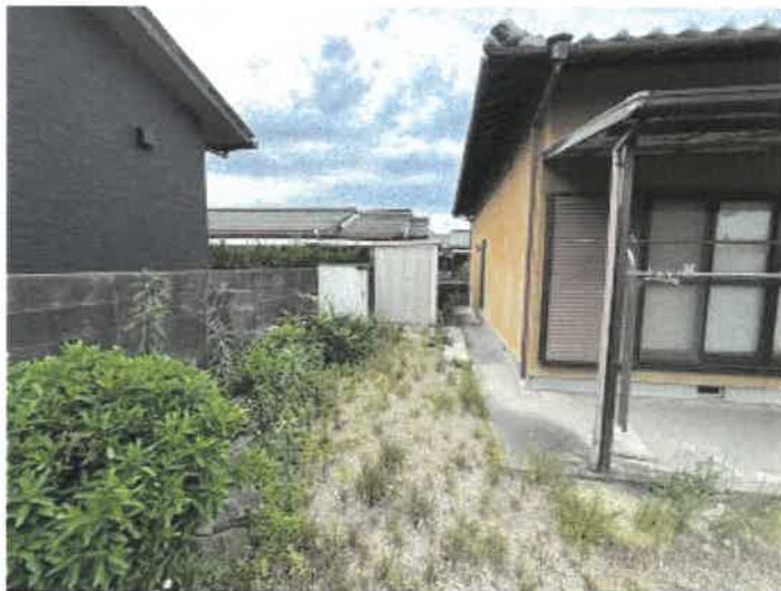
物件 1 西側の状況
