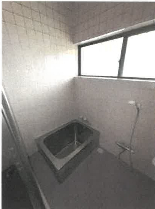
物件 2 浴室の状況
