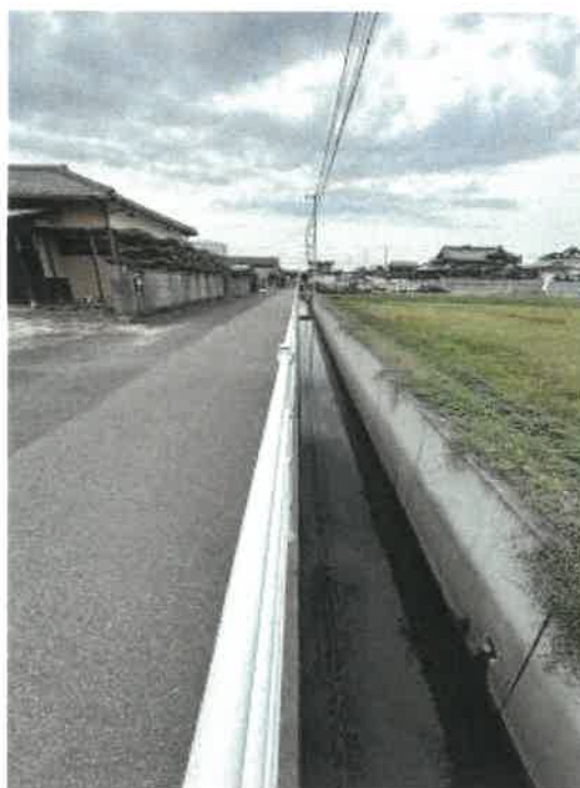
前面道路及び水路の状況
