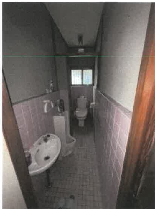
物件2 トイレの状況
