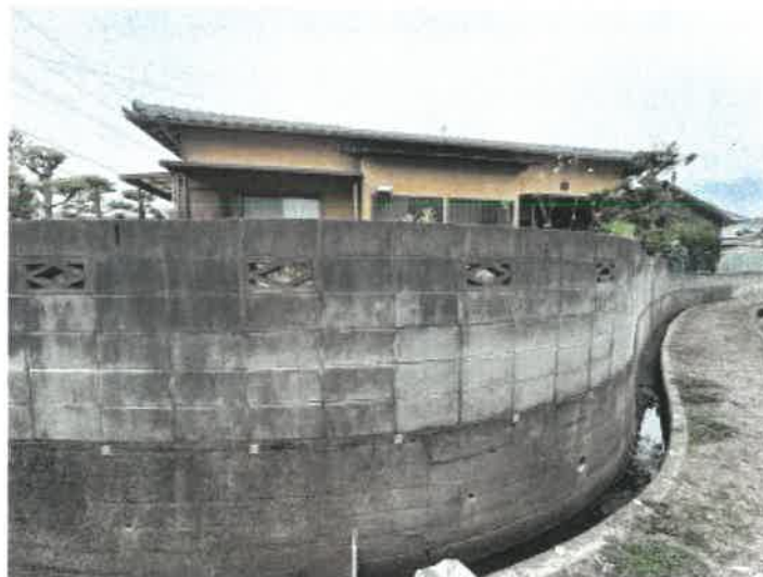
本件物件北西側の状況
