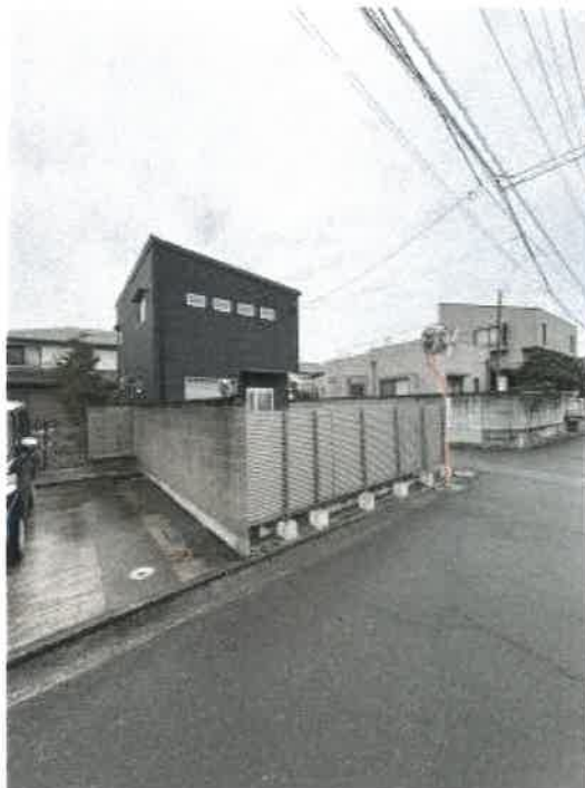
本件物件北東側の状況
