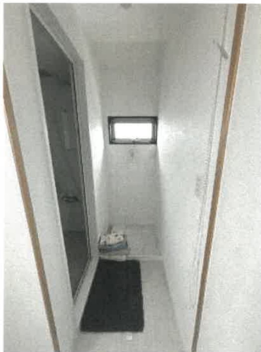
物件 3 2階脱衣所付近の状況
