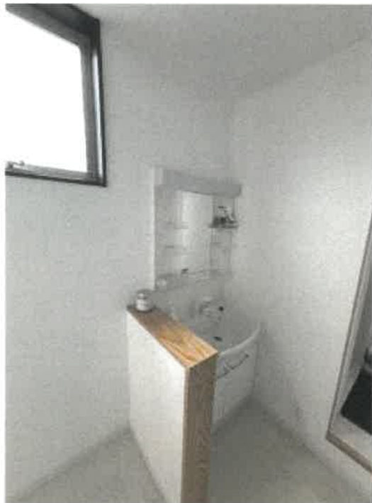
物件 3 2階洗面台付近の状況
