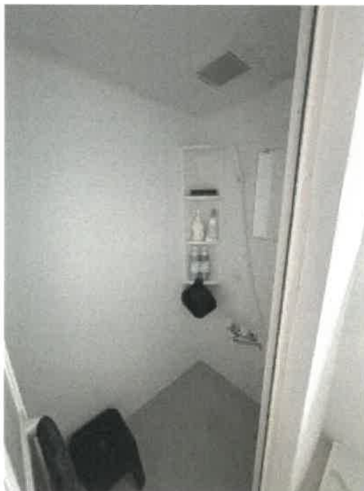
物件3 2階シャワー室の状況
