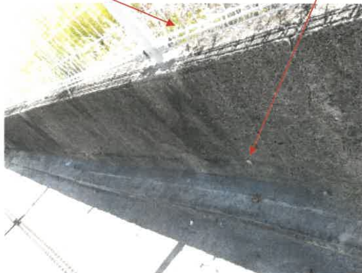
物件 2 土地西側コンクリート擁壁の境界ピンの状況
