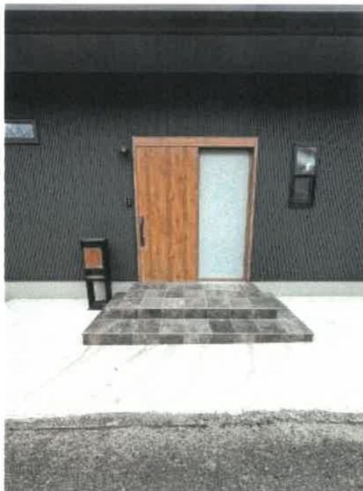
物件2 玄関付近の状況
