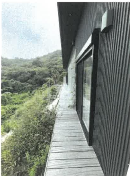
物件2 東側ウッドデッキの状況
