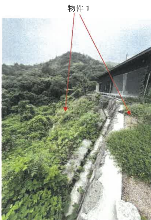
物件1 北東側の状況
