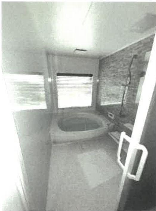
物件2 浴室の状況
