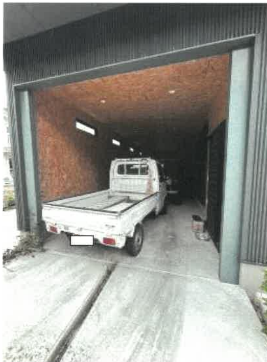
物件2 車庫の状況
