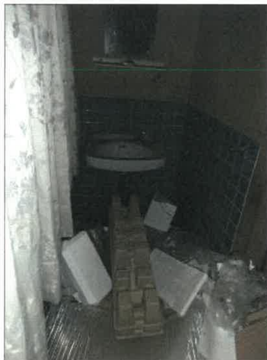
物件4主である建物の1階南西角のトイレの洗面所の状況
