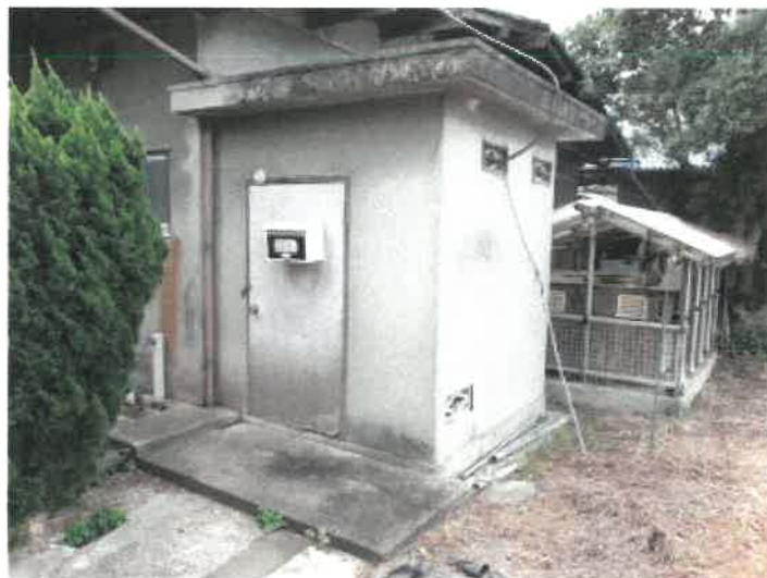
物件4主である建物の1階北東角の外から出入りする物置の状況
