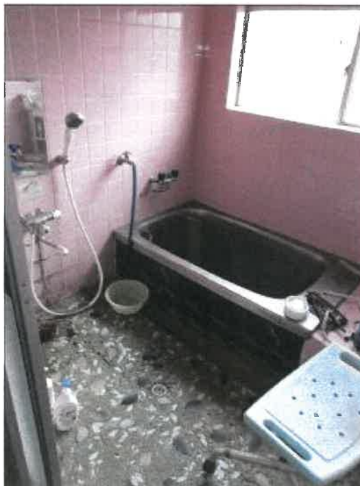
物件4主である建物の1階浴室の状況
