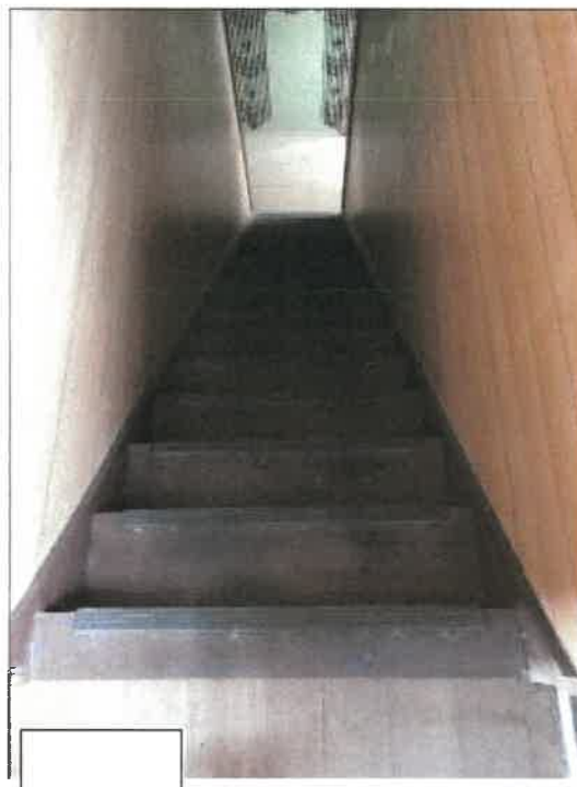
物件 5 建物の階段の状況
