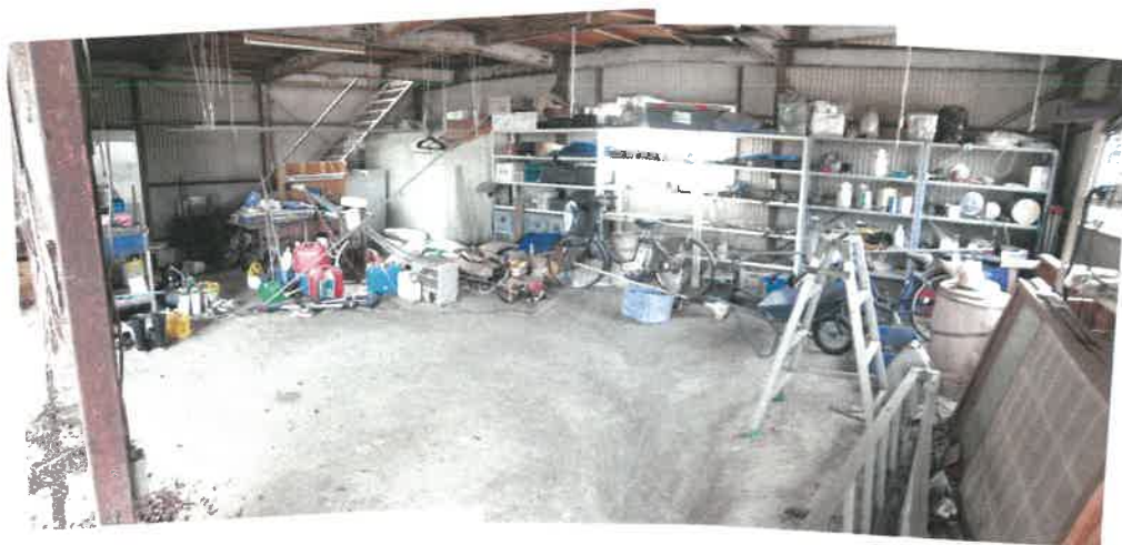
物件 4 建物附属建物符号 1 の 1 階部分の状況
