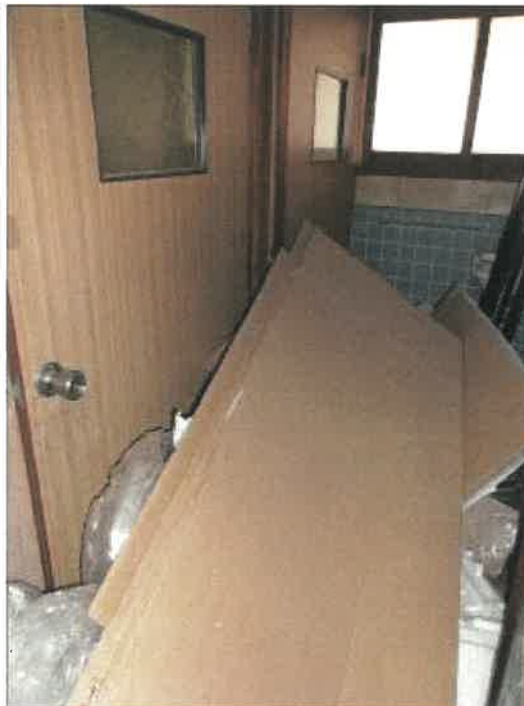
物件4主である建物の1階南西角のトイレの廊下の状況
