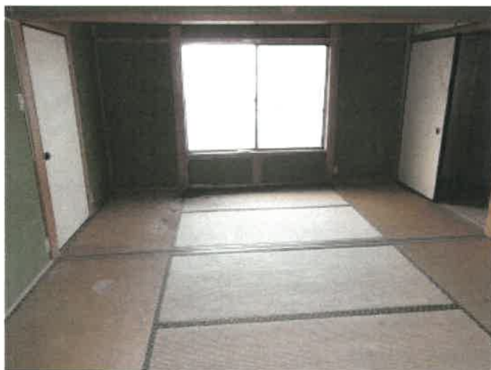
物件 5 建物の 2 階和室の状況
