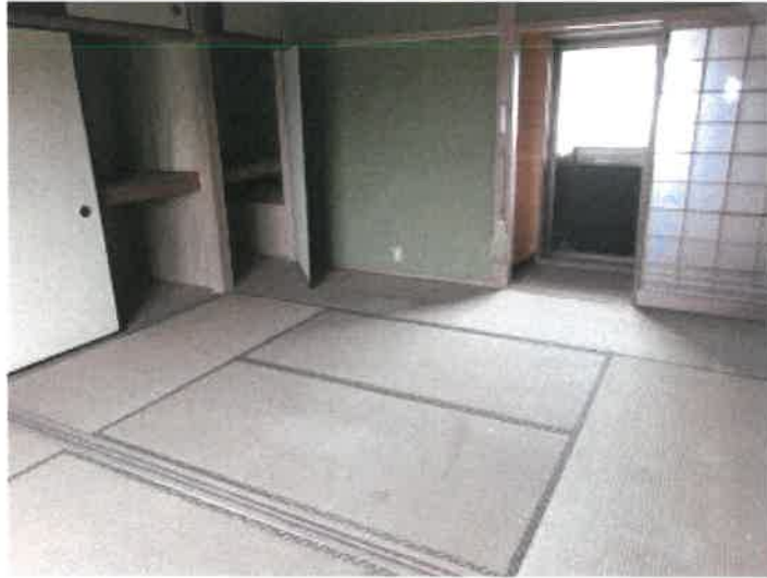
物件 5 建物の 2 階和室の状況
