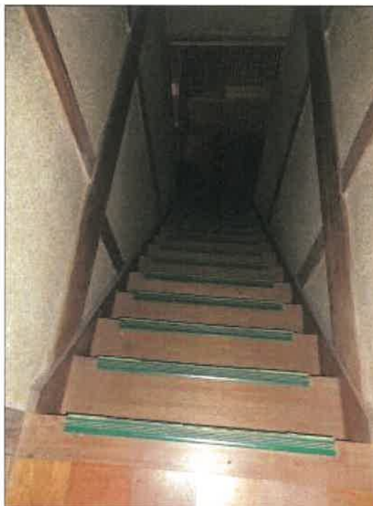
物件4主である建物の階段の状況
