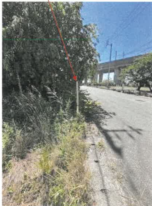
本件物件北西側電柱支持ワイヤーの状況
