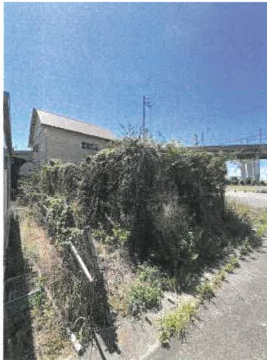
本件物件南東側の状況
