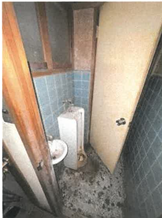
物件3 1階男性用トイレの状況
