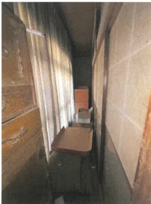
物件3 1階南西側縁側の状況
