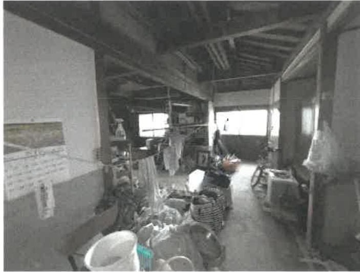
物件3 作業場南西側の状況
