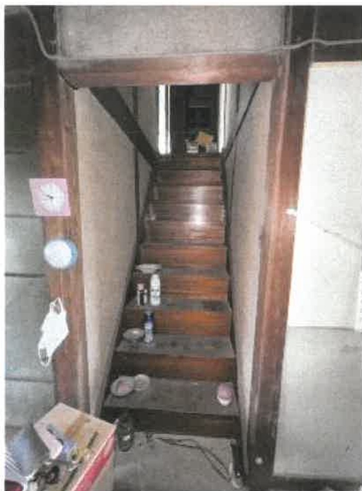
物件3 階段の状況
