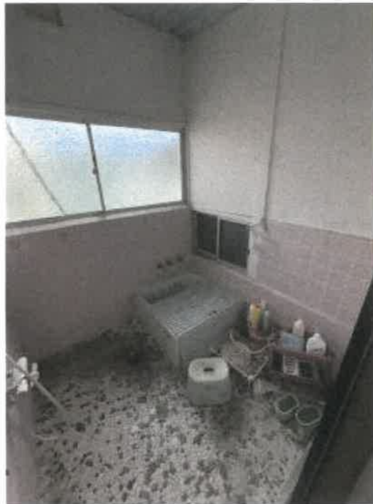
物件3 1階浴室の状況
