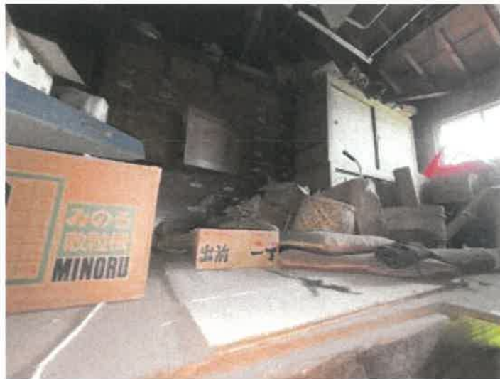
物件3 作業場の屋根裏の状況
