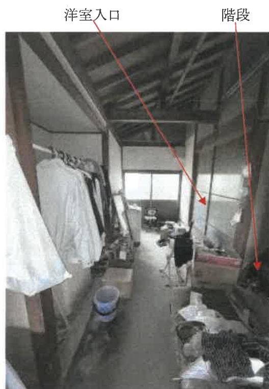
物件3 作業場北側の状況
