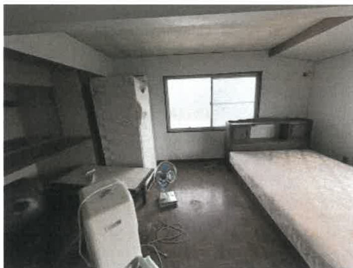
物件3 北東側2階洋室の状況
