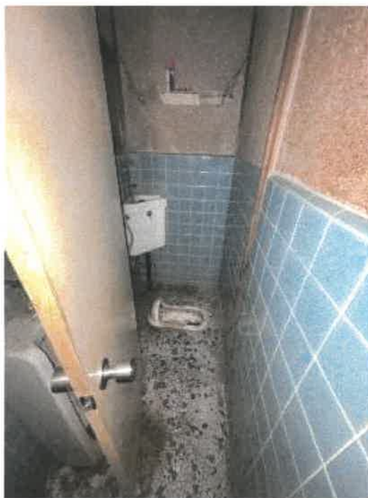
物件3 1階トイレの状況
