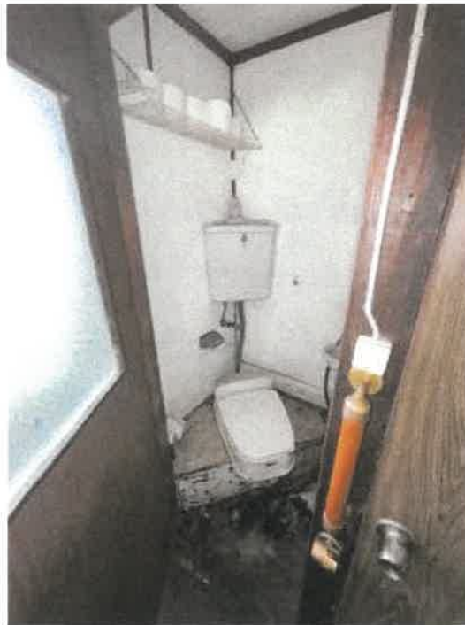
物件3 作業場西側のトイレの状況
