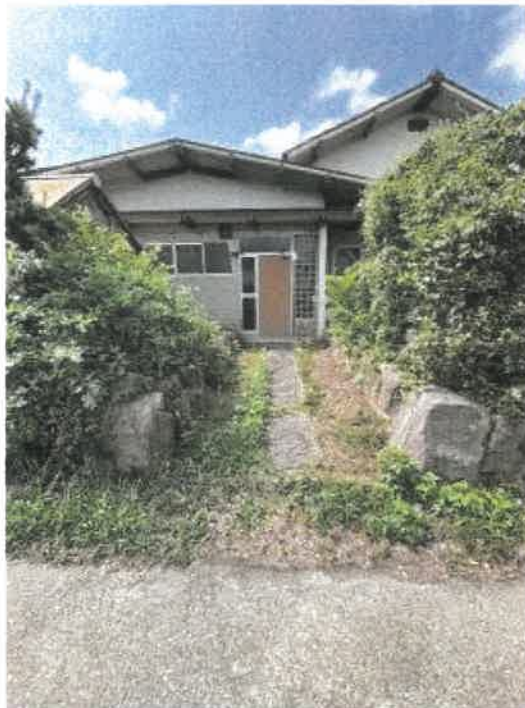
物件2 北側入口付近の状況
