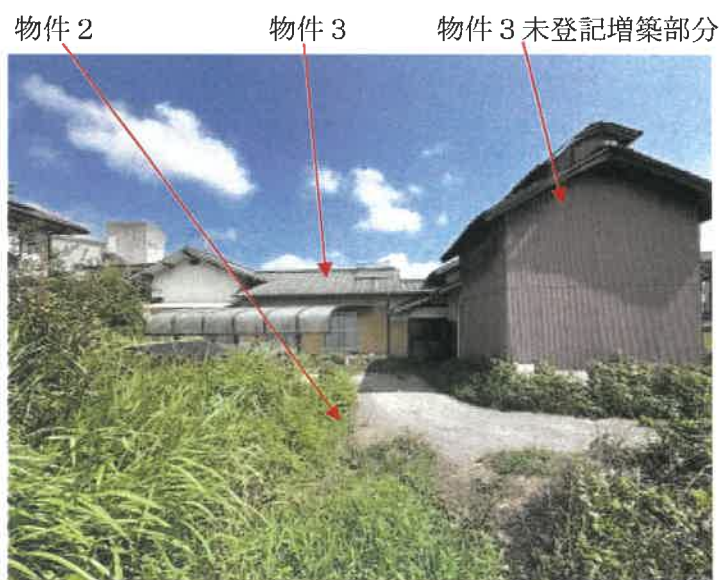
本件物件南側の状況
