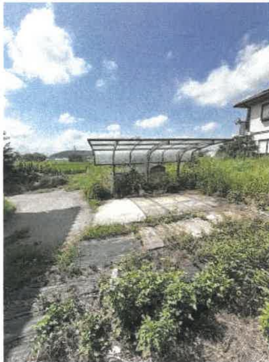
物件2 南西側カーポートの状況
