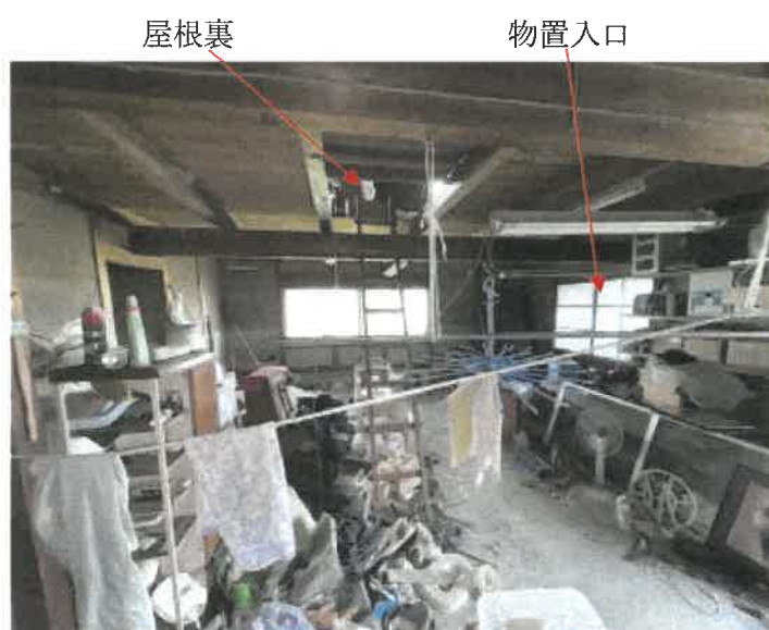
物件3 作業場の状況
