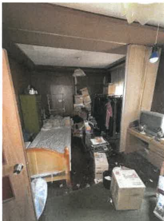
物件3 1階中央洋室の状況
