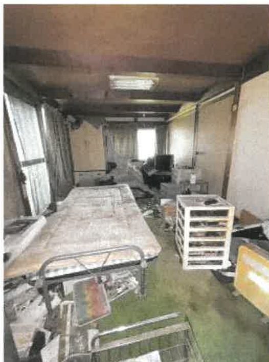
物件3 北東側1階洋室の状況
