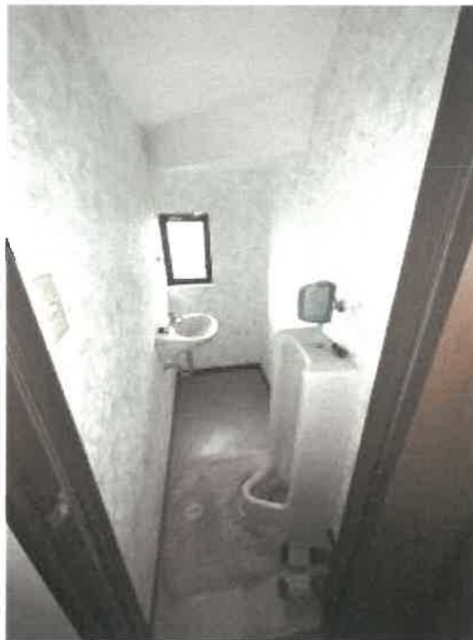
物件2 1階トイレ（小）の状況
