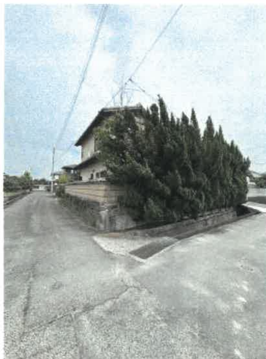
本件物件の北西側の状況
