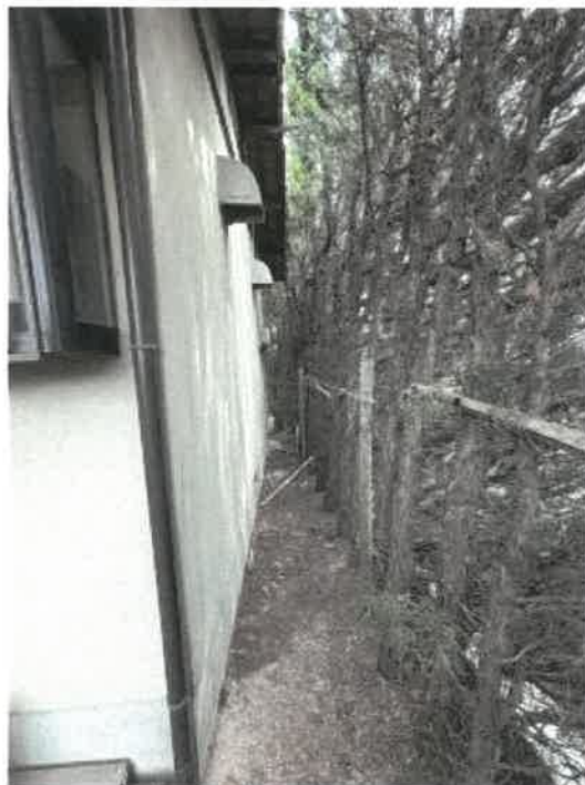
物件1 西側の状況
