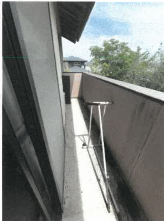
物件2 ベランダの状況
