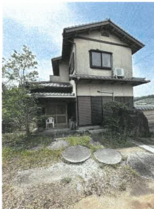
物件 1 中央部付近の状況
