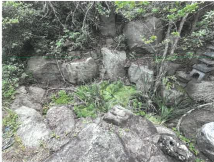
物件1 南西側池の状況
