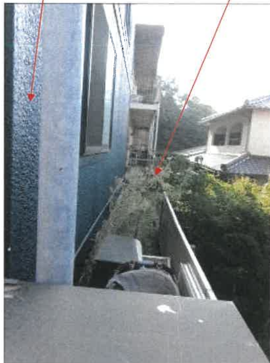
物件 1 土地北側境界付近の状況
