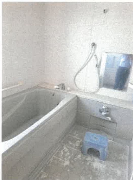
物件2建物の2階浴室の状況
