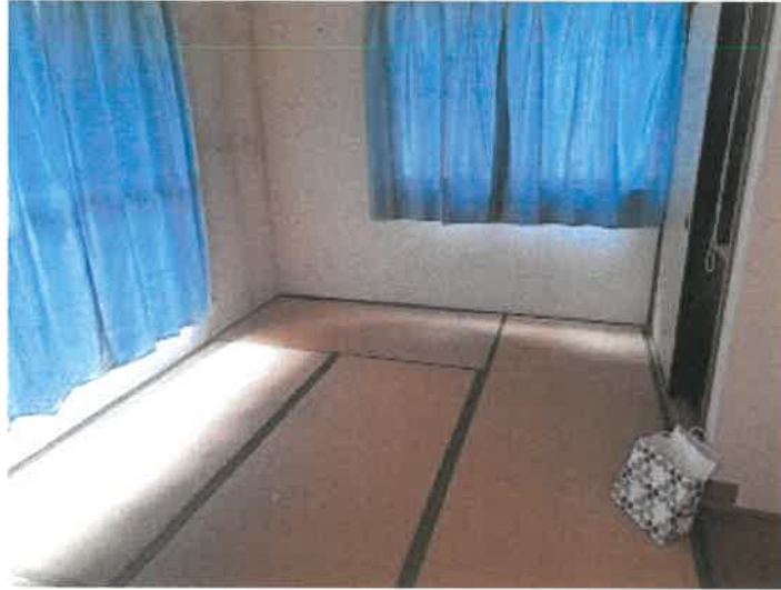
物件 2 建物の 1 階和室の状況
