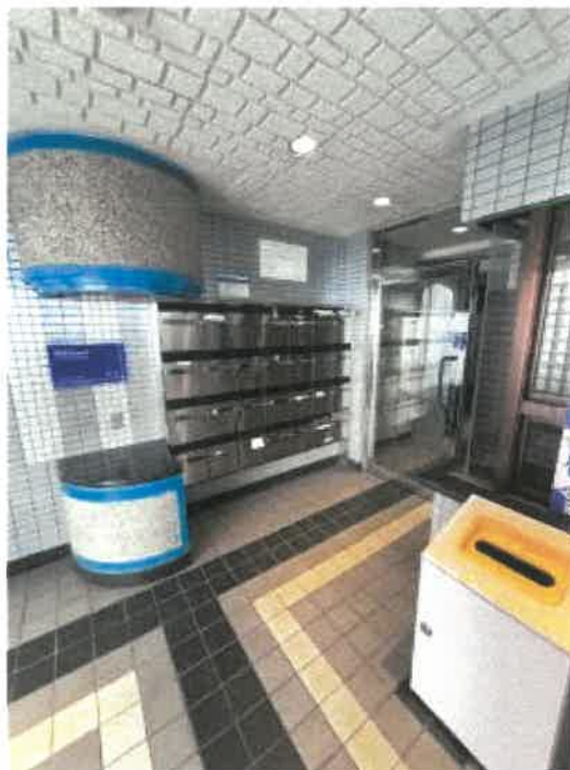
マンション入口付近の状況
