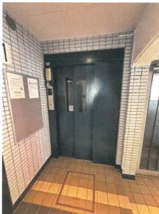
エレベータ前の状況
