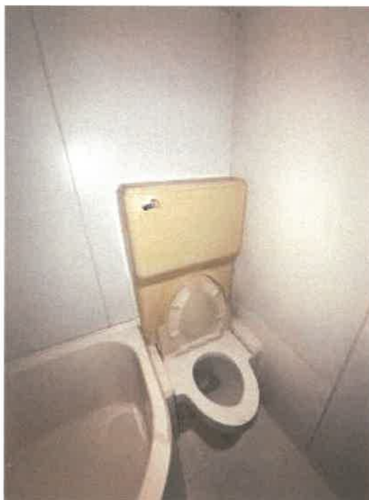
ユニットバスの状況
