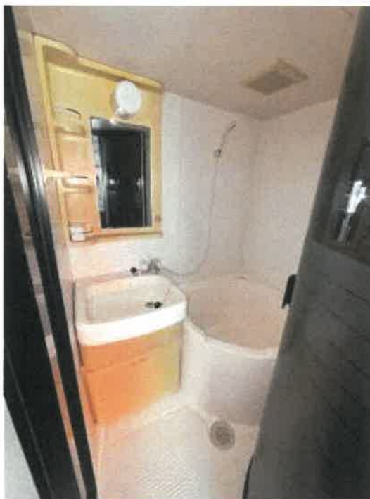
ユニットバスの状況
