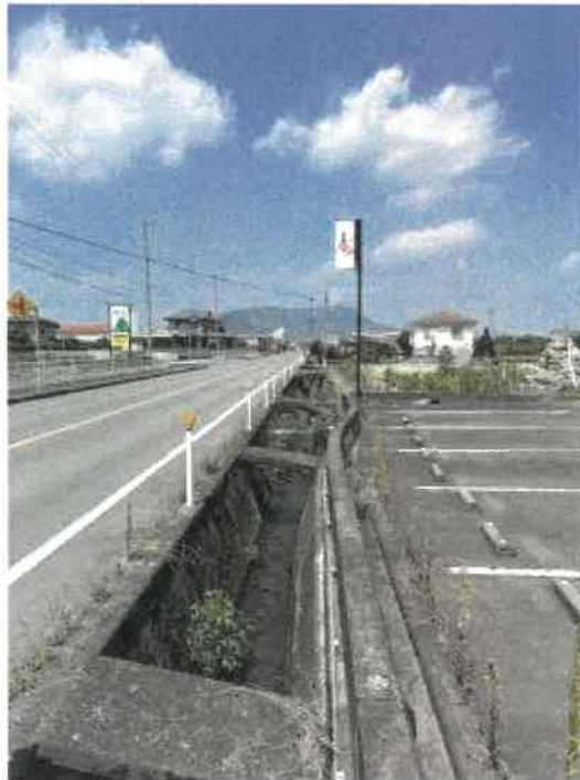
物件1 南側の状況
