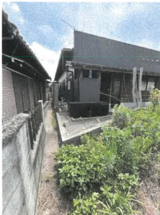
物件1 北西側の状況
