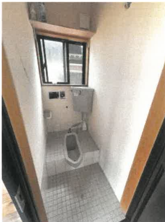
物件2 男性用トイレの状況
