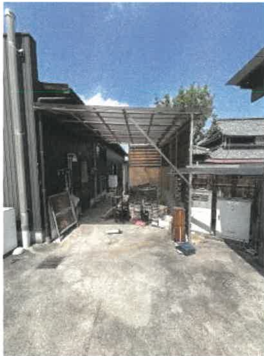
物件2 北東側下屋の状況
