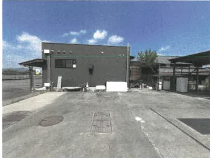
物件 2 東側の状況
