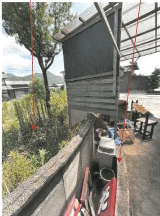
物件2 北東側下屋の状況
