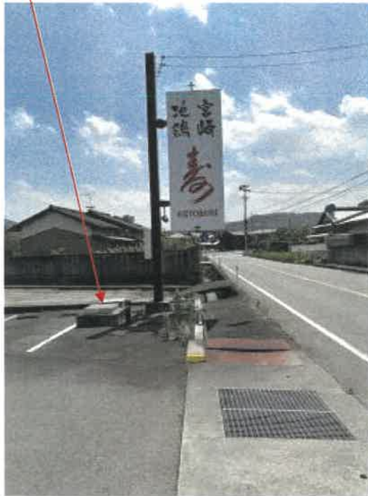
物件1 南東側の状況
