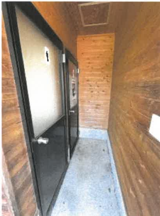
物件2 北西側トイレ前の状況
