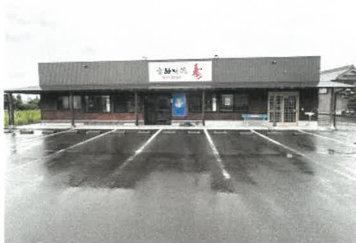
物件2 南側の状況
