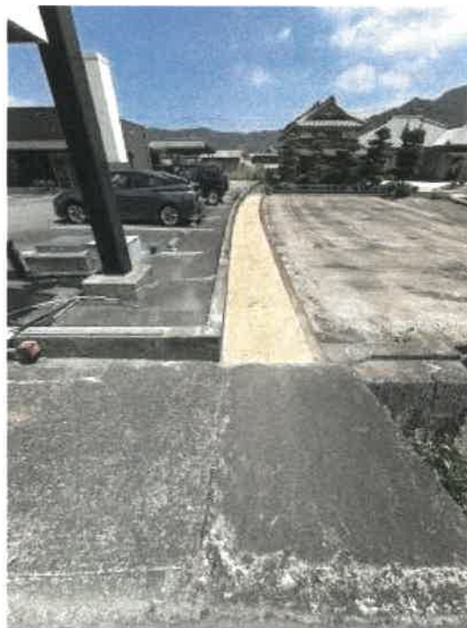
物件1 東側境界付近の状況
