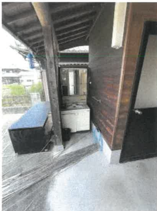
物件2 トイレ北西側手洗場の状況
