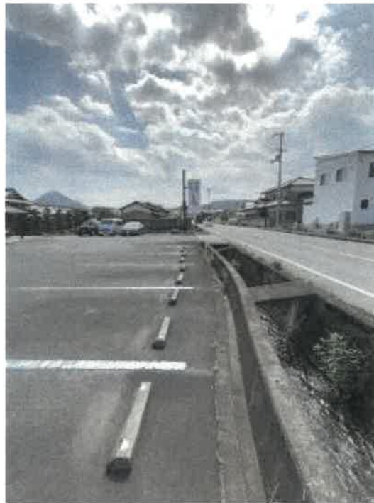
物件1 南西側の状況
