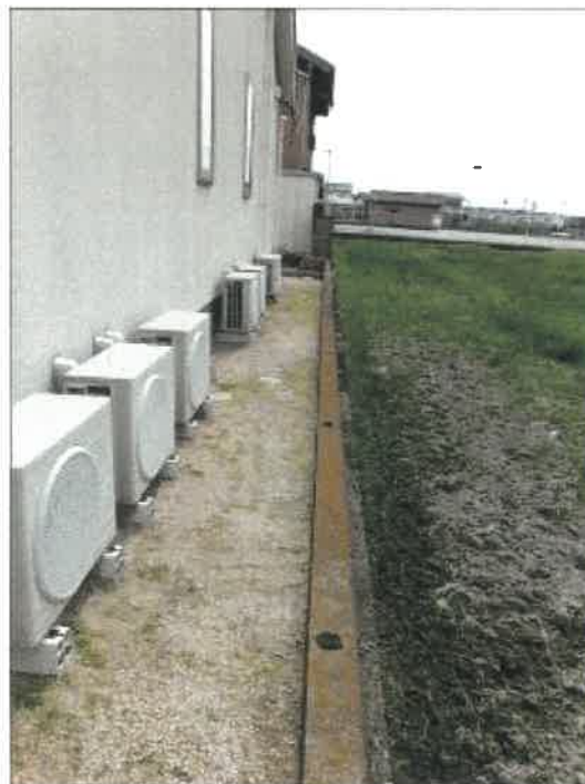
物件 3 建物北西側の状況
