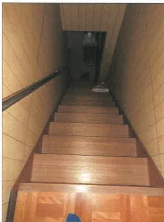
物件2 建物の階段の状況
