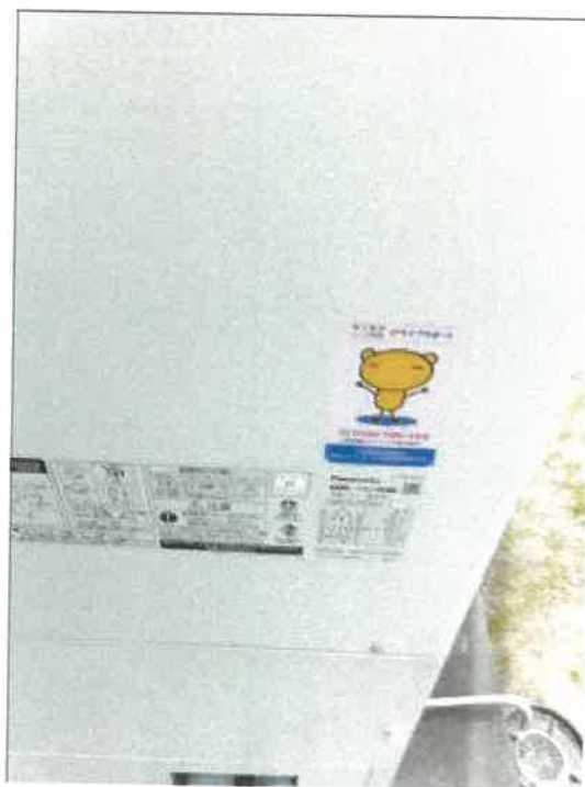
物件3建物北東側のエコキュートのリース票の状況
