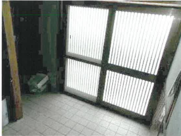
物件 2 建物の 1 階玄関内の状況
