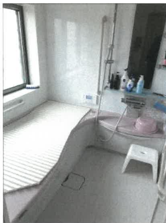
物件 3 建物の 1 階浴室の状況
