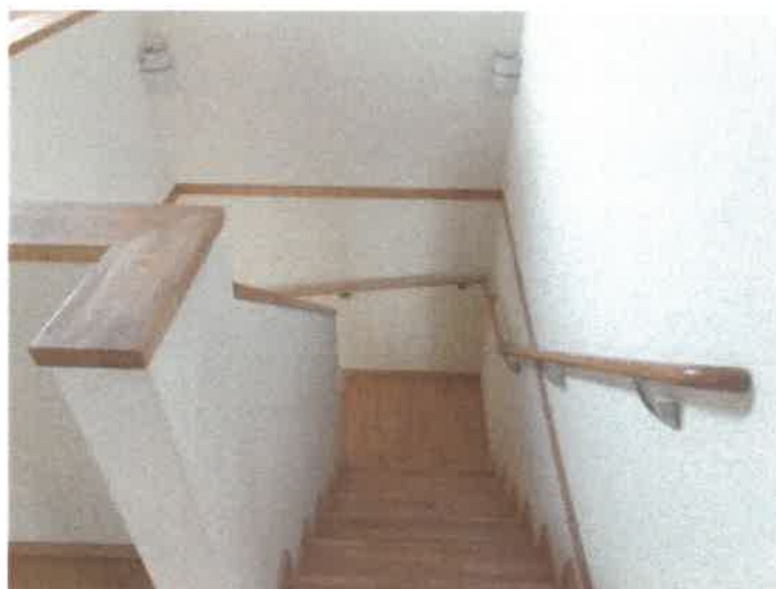
物件3建物の階段の状況
