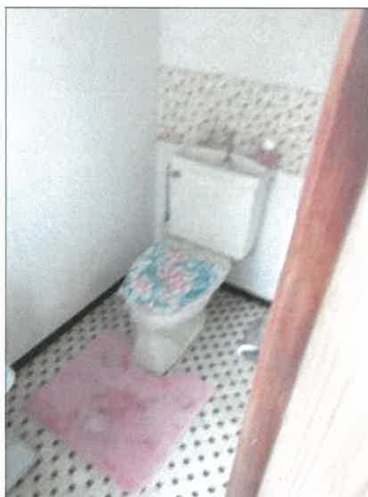
物件 2 建物の 1 階西角のトイレの状況
