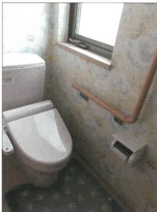
物件3建物の1階トイレの状況
