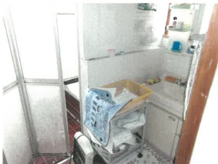
物件2 建物の1階洗面脱衣所の状況
