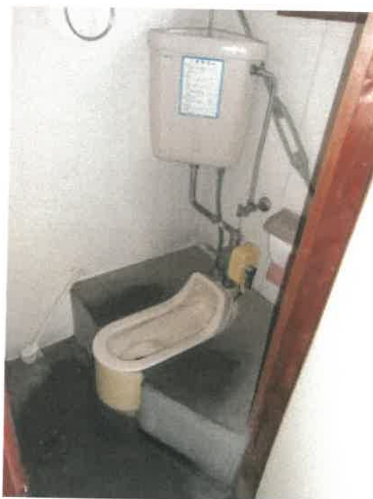
物件3建物内南西側トイレ（簡易水洗式）の状況
