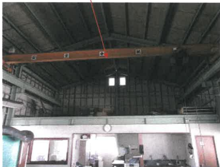
物件3建物内南西側ロフト状物置の状況
