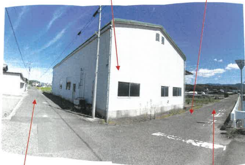
物件1 土地北西側及び南西側境界付近の状況
