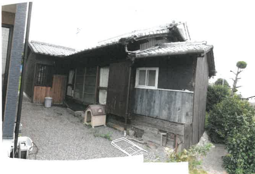
物件5主である建物北西側の状況
