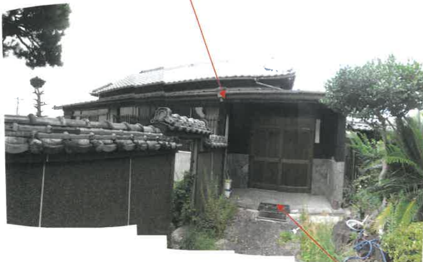
物件 5 主である建物の南側の状況
