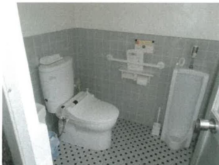
物件5主である建物のトイレの状況
