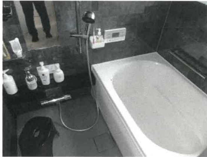
物件6建物東側エリアの浴室の状況
