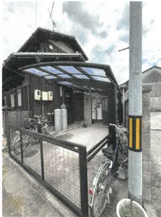
物件1 北西側カーポートの状況
