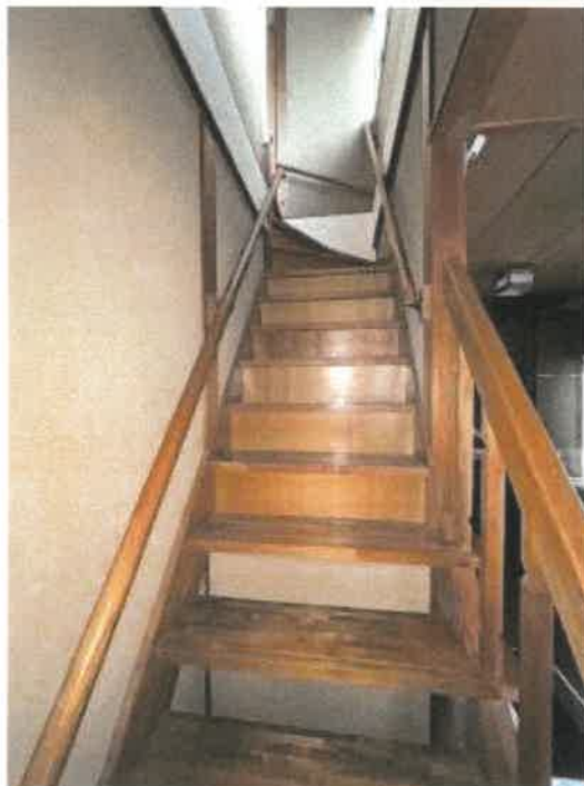
物件3 階段の状況
