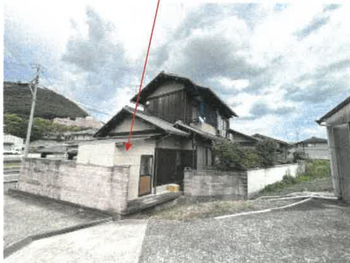
本件物件南西側の状況
