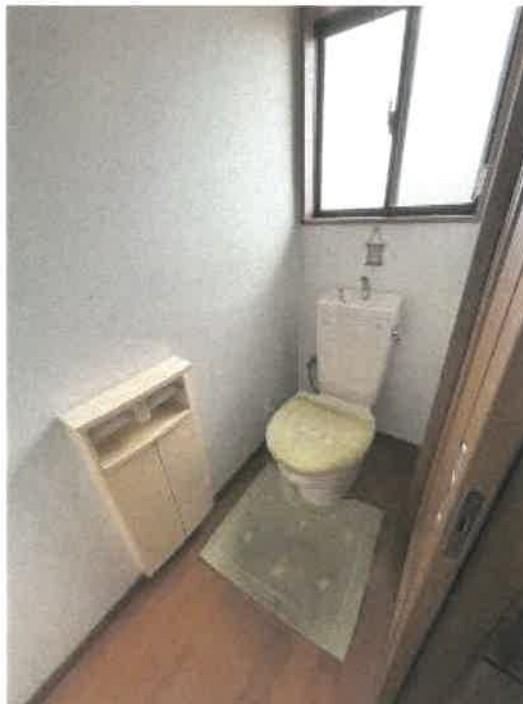
物件2 2階トイレの状況
