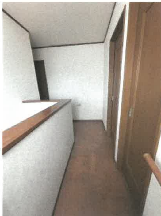
物件2 2階ホールの状況
