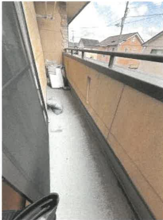
物件 2 2階バルコニーの状況
