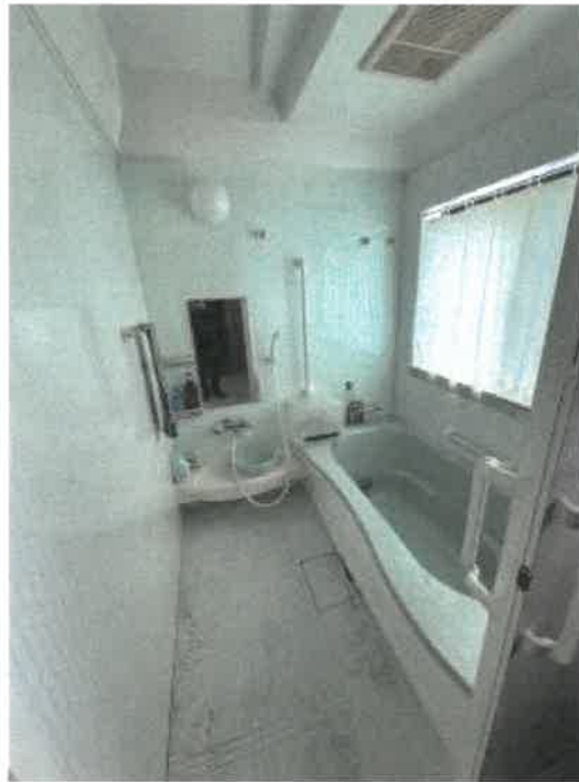
物件2 1階浴室の状況
