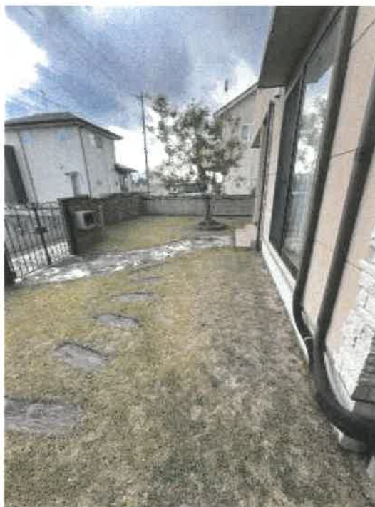
物件1 南側の状況
