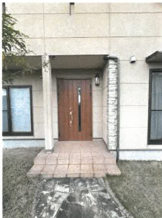
物件2 玄関付近の状況
