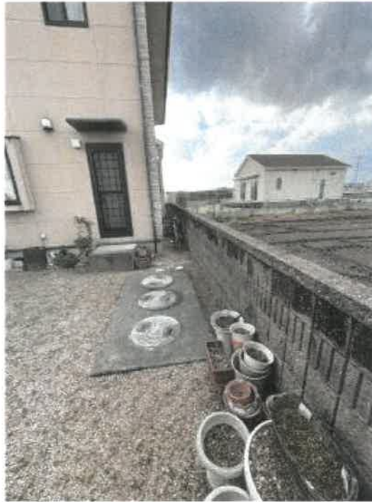
物件1 北東側の状況
