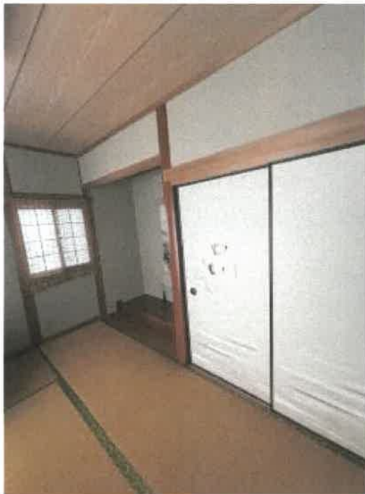
物件2 1階和室の状況
