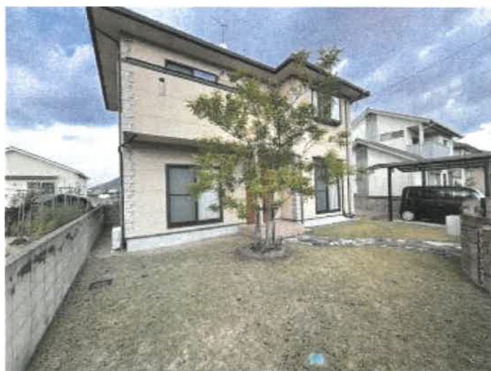
物件1 南西側の状況
