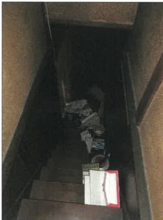
物件 2 建物の階段の状況
