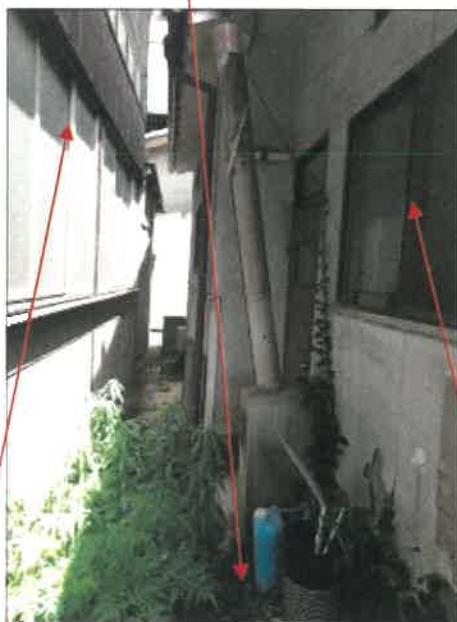
物件 1 土地北側境界付近の状況
