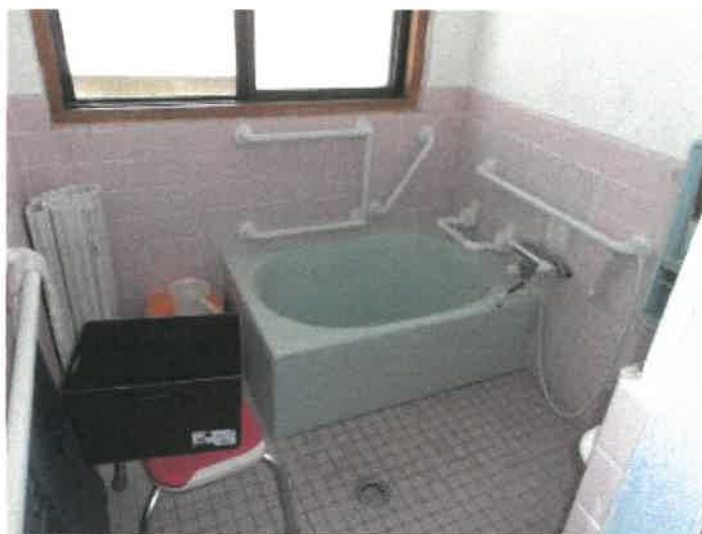
物件 2 建物の 1 階浴室の状況
