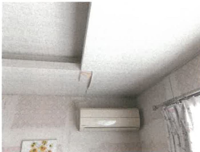
物件 2 建物の 1 階 L D K の天井南東角付近の壁紙の損傷状況
