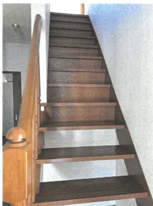
物件2建物の階段の状況
