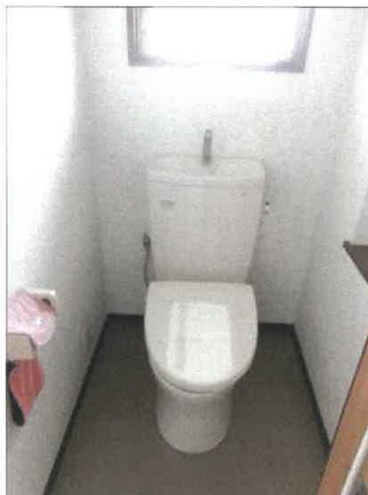
物件2建物の1階トイレの状況
