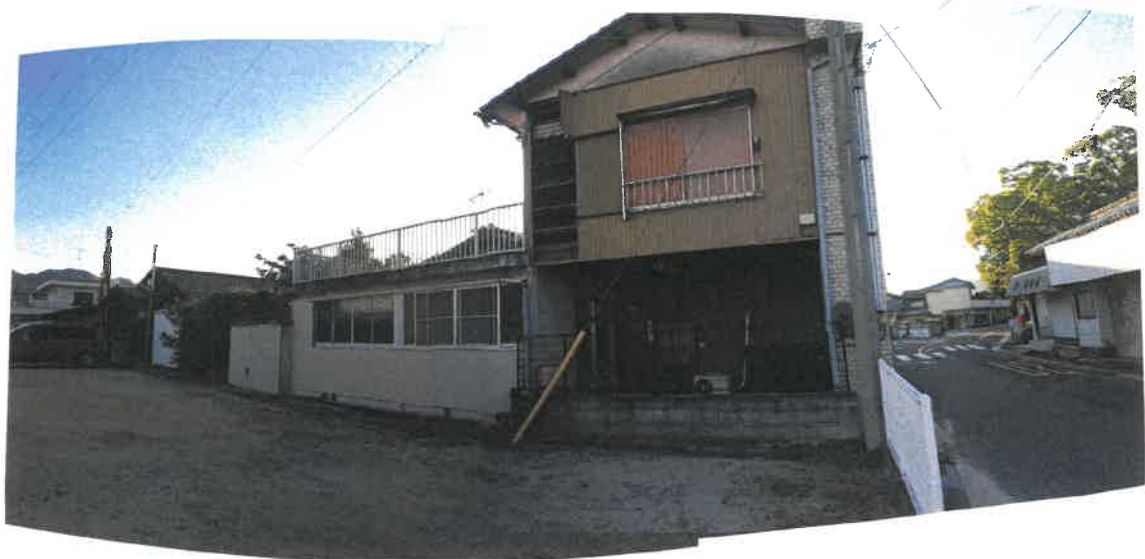
物件 4 主である建物部分東面の状況
