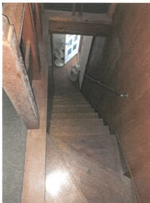
物件 4 主である建物部分の階段の状況
