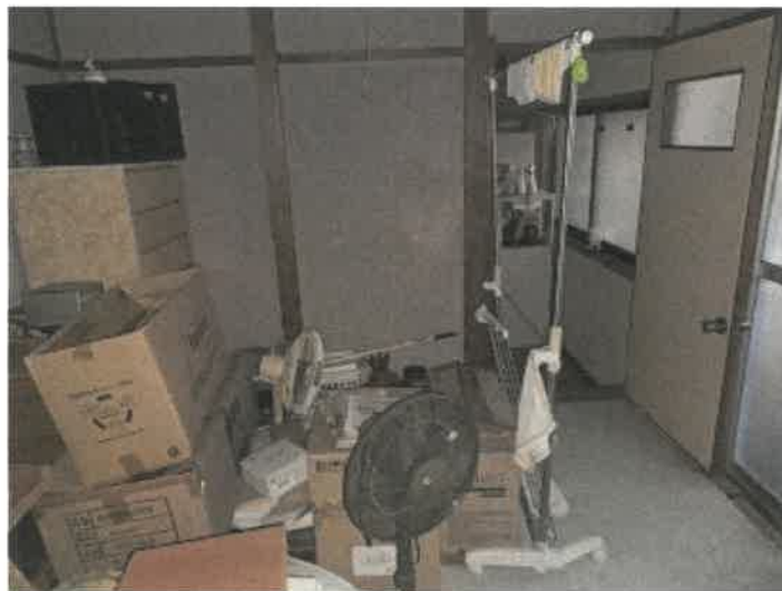
物件4 附属建物符号1 部分の北側和室の状況
