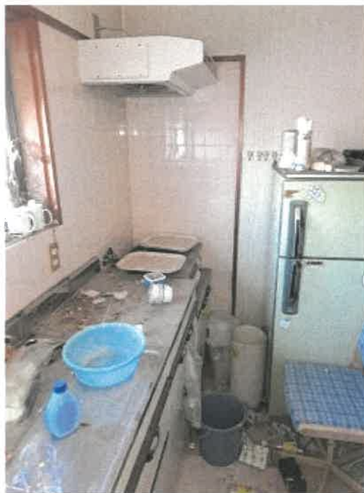
物件4 附属建物符号1 部分の東端キッチン周りの状況
