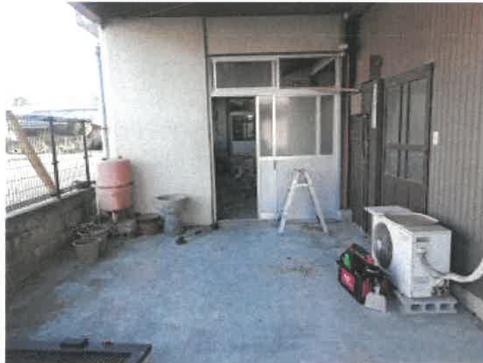
物件4主である建物部分北東側駐車場付近の状況
