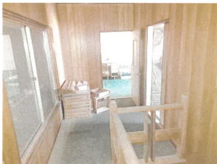
物件 4 主である建物部分 2 階の階段ホールの状況
