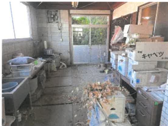
物件4主である建物部分東側の倉庫（増築部分）の状況
