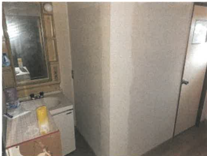
物件4主である建物部分1階南東角の洗面所及びトイレ前の状況
