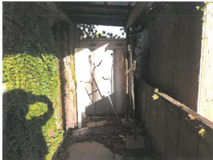
物件4附属建物符号1部分の南東角付近のスチール製物置（動産）の状況
