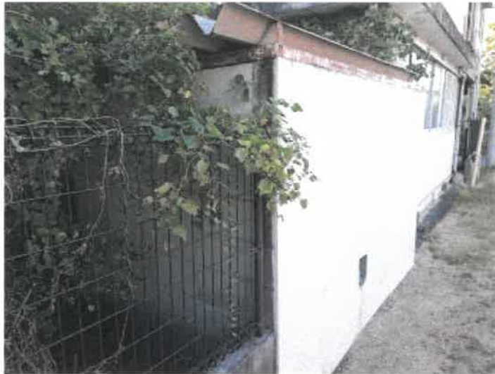
物件4附属建物符号1部分の北東角付近のスチール製物置（動産）の東側の状況
