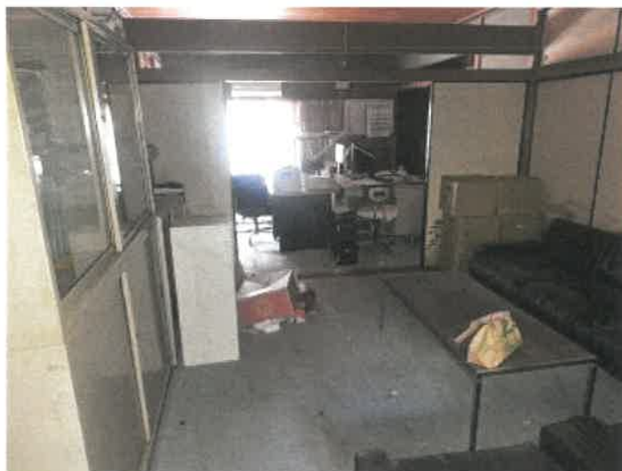
物件 4 附属建物符号 1 部分の西側和室 2 間の状況
