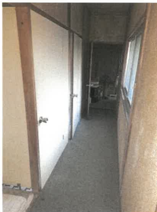
物件 4 附属建物符号 1 部分のトイレ前廊下の状況
