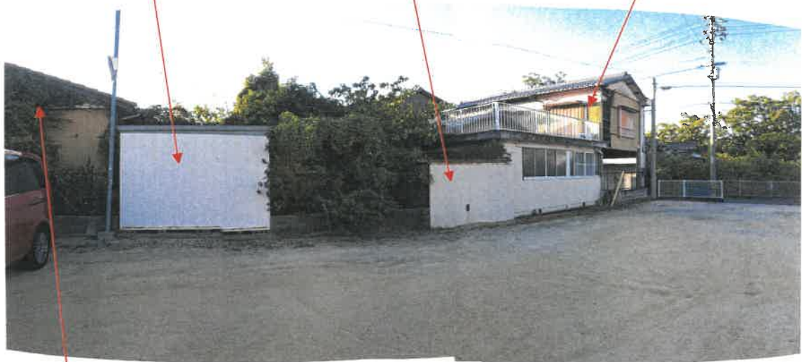
物件 4 主である建物部分及び物件 4 附属建物符号 1 部分の東面の状況
