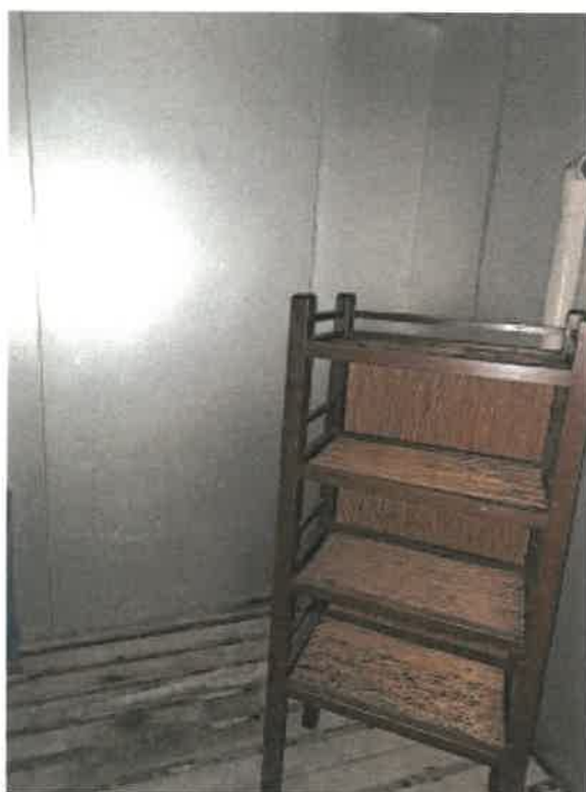
物件4主である建物部分1階北端の店舗部分東側冷蔵庫内の状況
