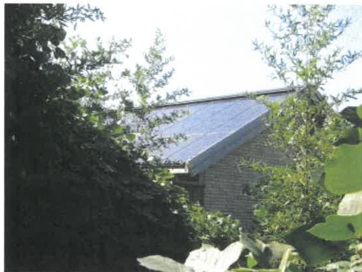
物件2建物の屋根の太陽光発電パネル設置状況
