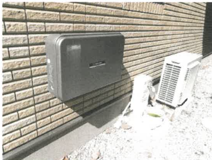
物件2 建物南東側外壁の太陽光発電パワーコンディショナーの状況
