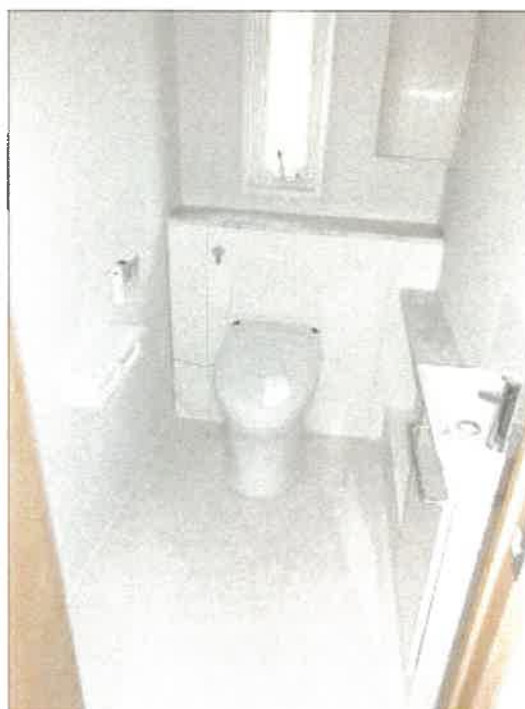
物件 2 建物の 2 階トイレの状況
