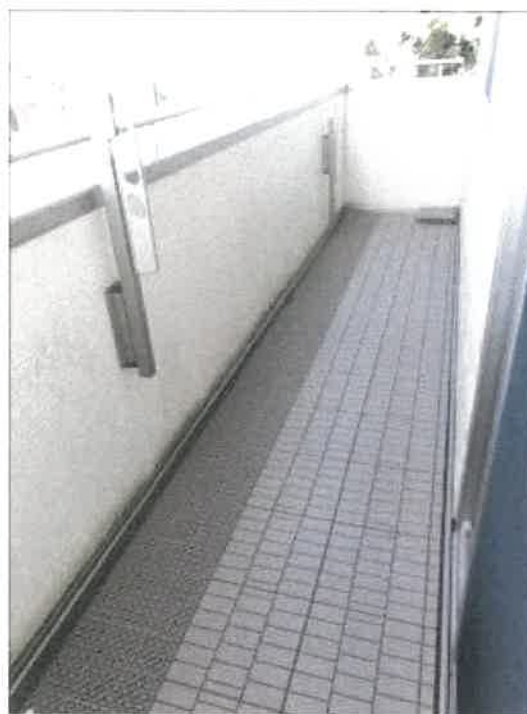
物件 2 建物の 2 階北西側ベランダの状況
