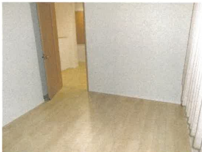
物件 2 建物の 2 階北東側北洋室の状況
