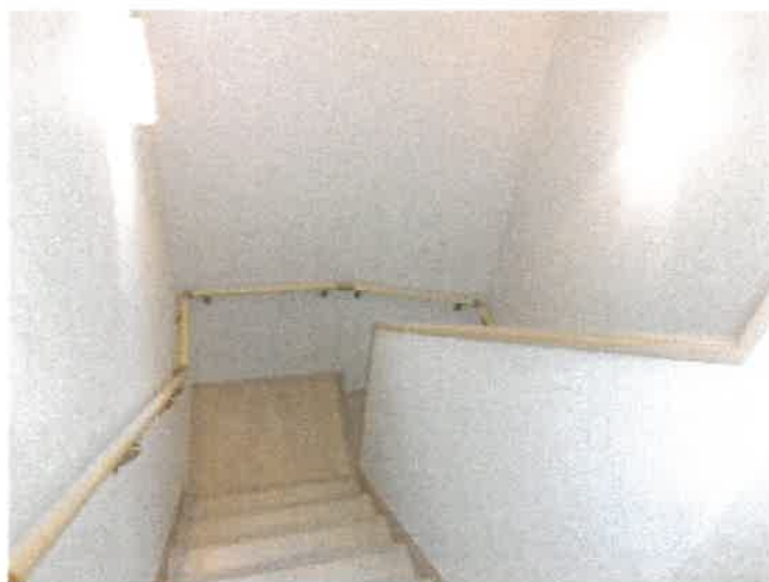
物件 2 建物の階段の状況
