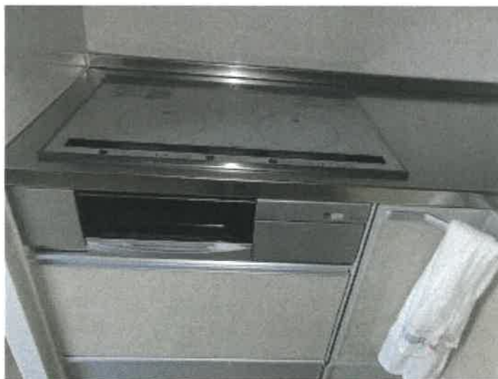
物件2建物の1階キッチンのIHクッキングヒーターの状況
