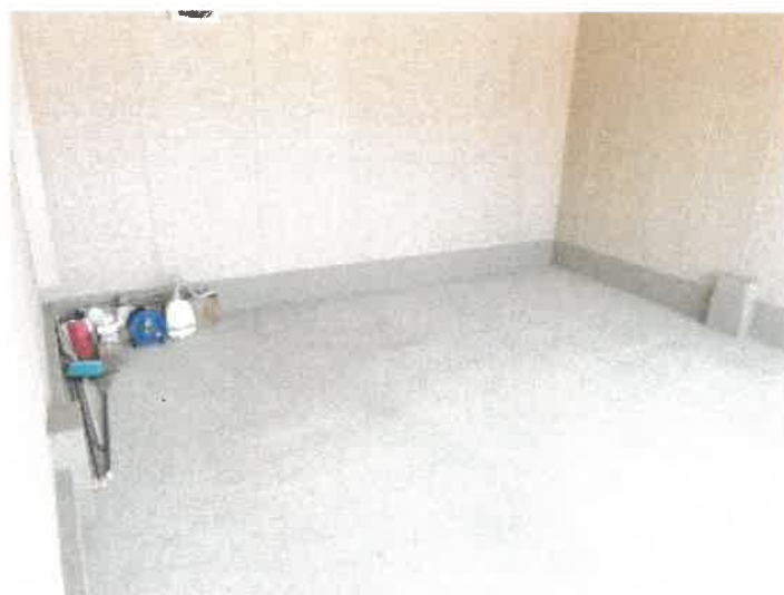
物件 2 建物の 1 階ガレージの状況
