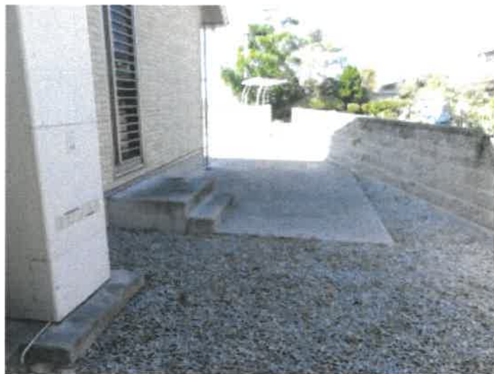
物件 2 建物北東側の状況
