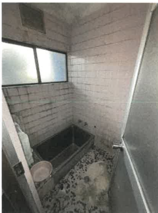
物件2 浴室の状況
