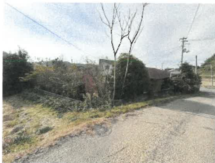
本件物件北東側の状況
