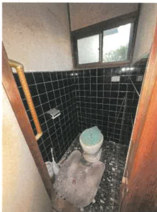
物件2 トイレの状況
