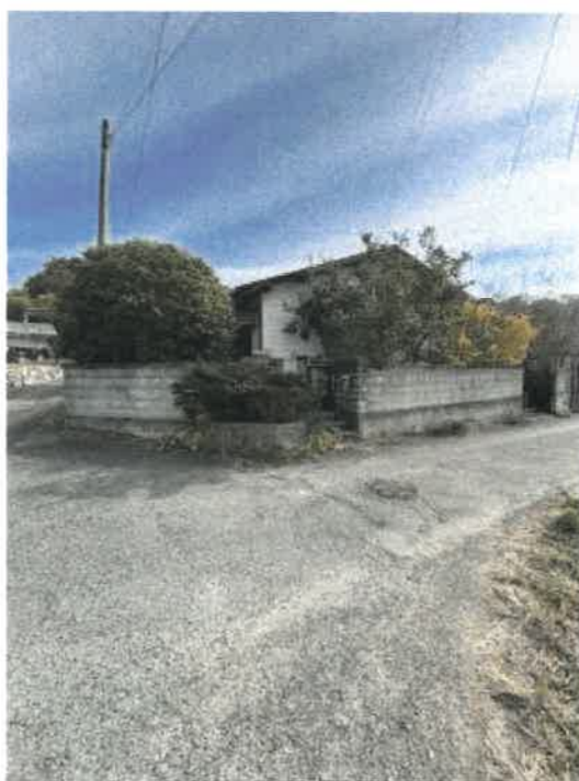
本件物件北西側の状況
