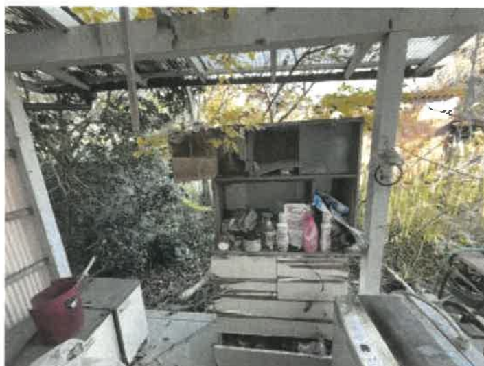
物件2 東側（キッチン外）の状況
