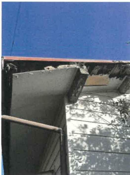
物件2 軒先付近の状況
