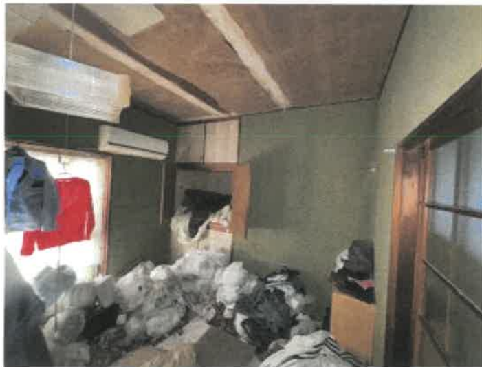
物件2 南東側和室の状況
