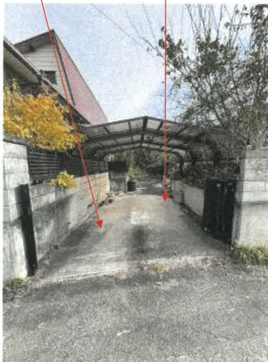
物件 1 南西側カーポートの状況
