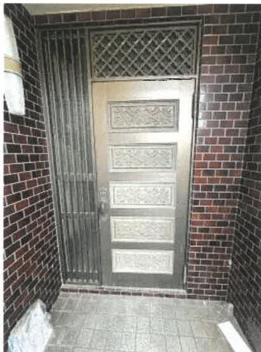
物件2 玄関入口付近の状況
