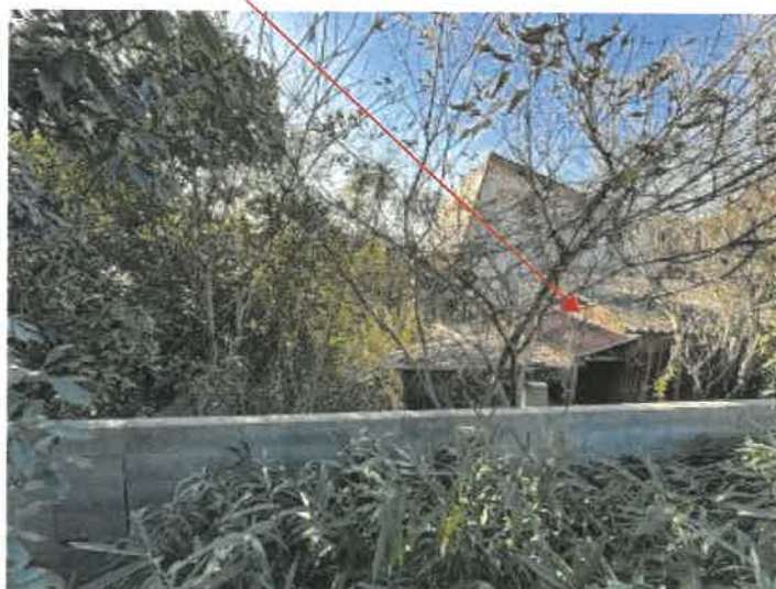
本件物件南東側の状況
