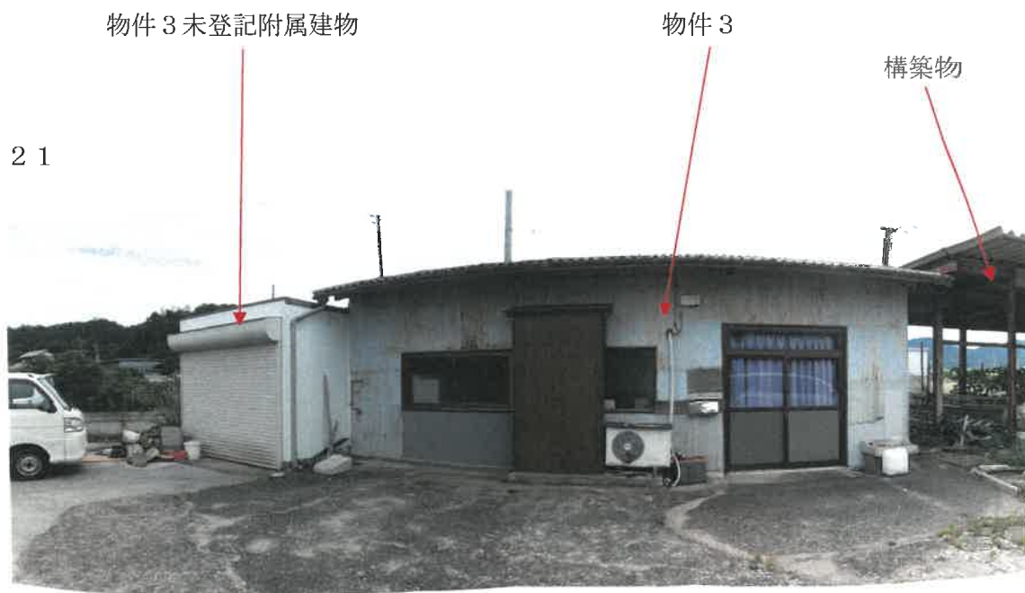
物件 3 附属建物符号 1 及び未登記附属建物の状況
