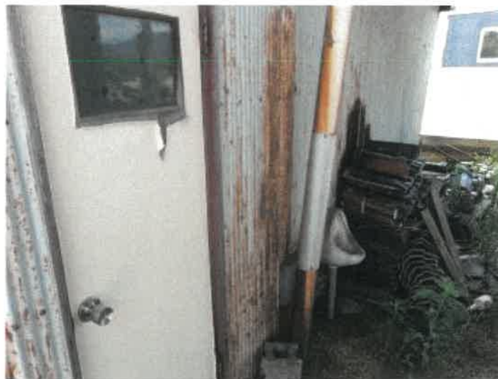
物件3附属建物符号1の北西側トイレの状況
