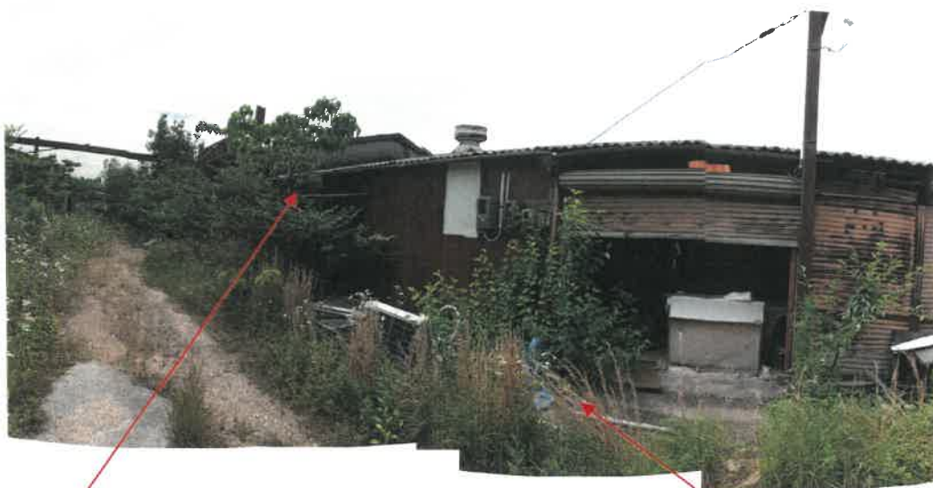
物件3主である建物南側の状況
