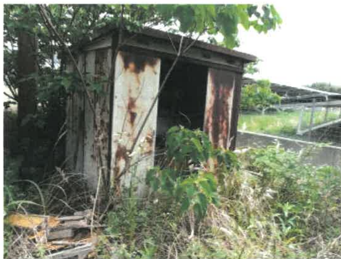
物件1 土地南西角に存在するスチール製物置（動産）の状況
