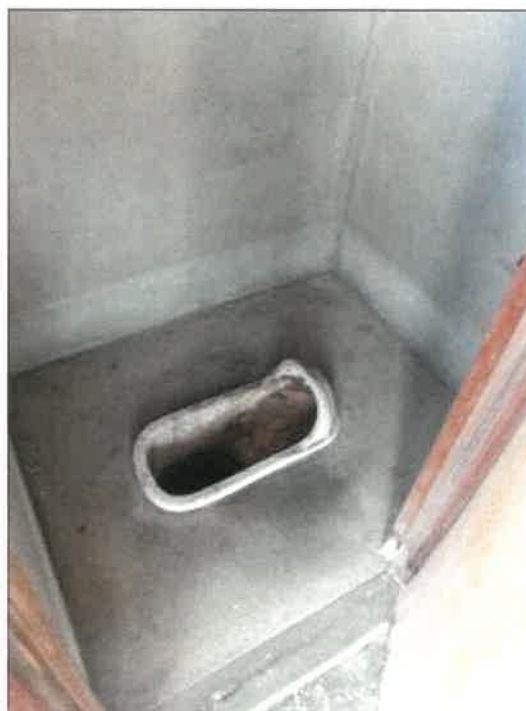
物件3附属建物符号1の北西側トイレの状況
