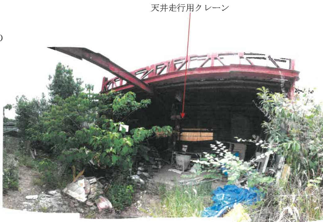
物件 3 主である建物の南西側端の区画部分の状況
