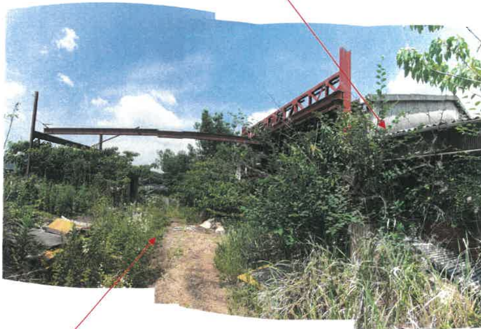
物件 3 主である建物の南西端付近の状況
