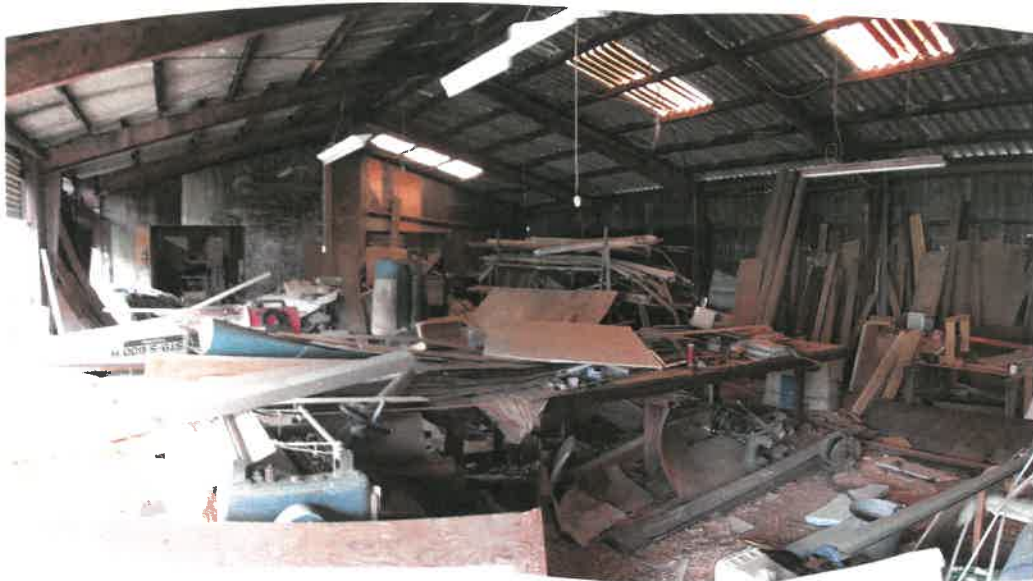
物件 3 主である建物北東側作業所内部の状況
