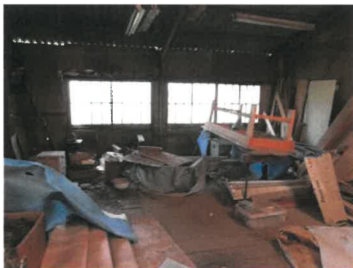
物件3主である建物南西側端から2区画目の作業所内部の状況
