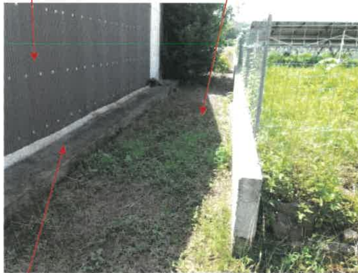
物件1 土地南西側境界付近の状況
