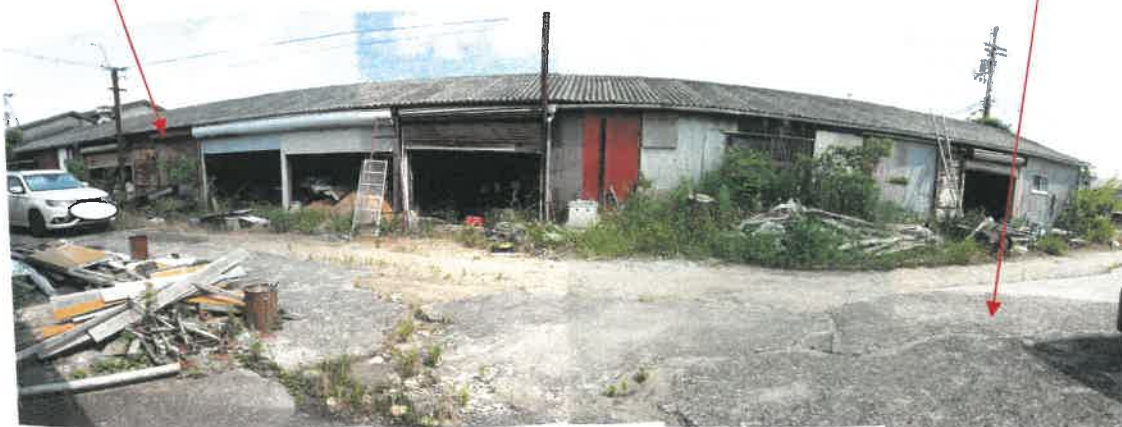
物件3主である建物南側の状況
