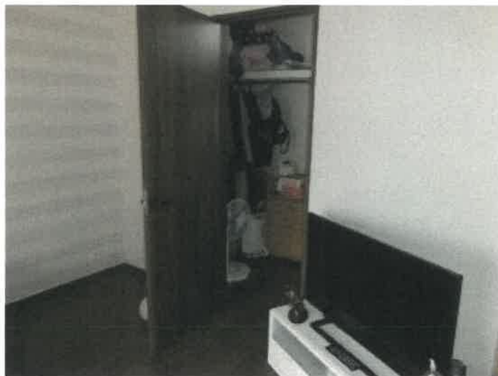
物件2建物の2階南西側洋室のクローゼットの状況
