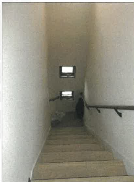
物件2建物の階段の状況
