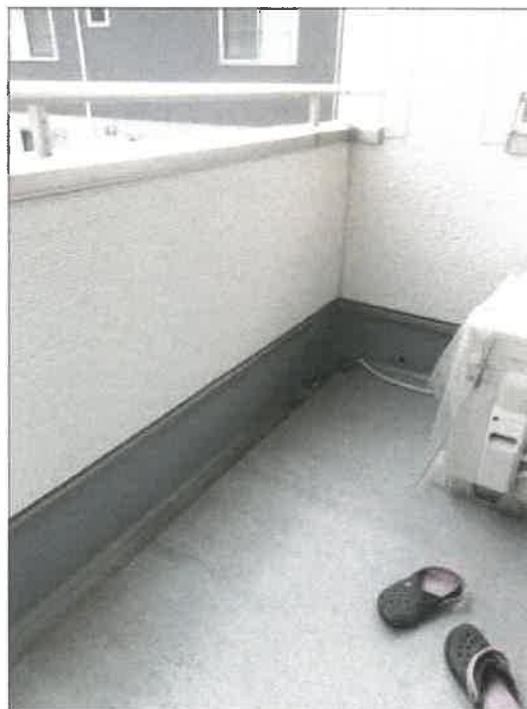
物件2建物の2階南東側バルコニーの状況
