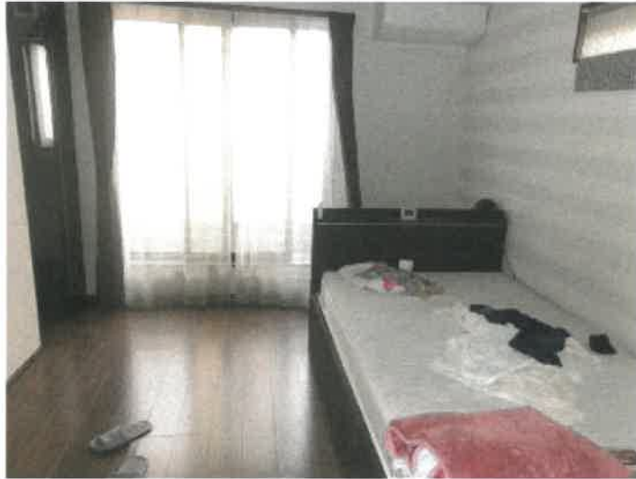
物件2建物の2階南西側洋室の状況
