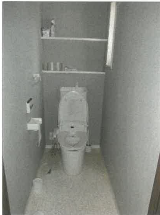
物件2建物の2階トイレの状況
