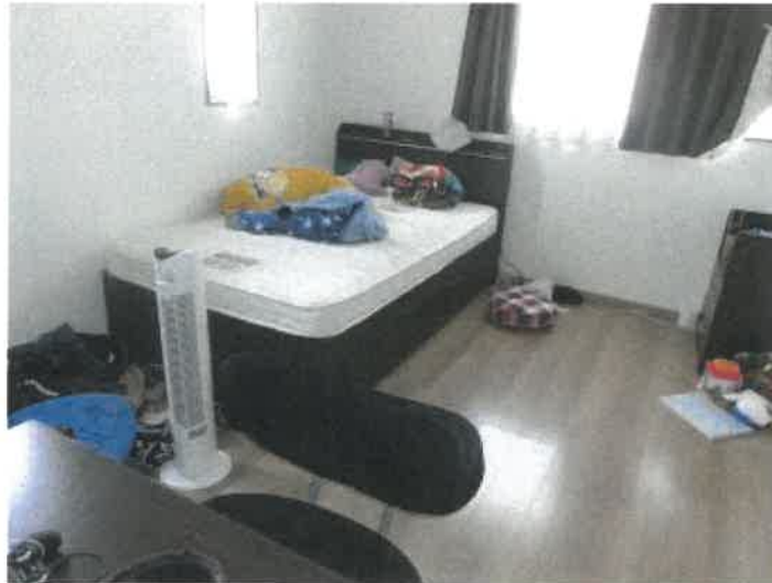
物件 2 建物の 2 階北東側北洋室の状況
