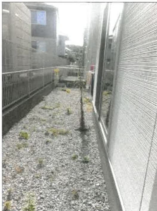
物件2建物南東側の状況
