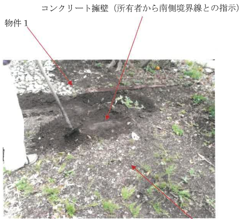
物件 1 土地南側境界線付近の状況
