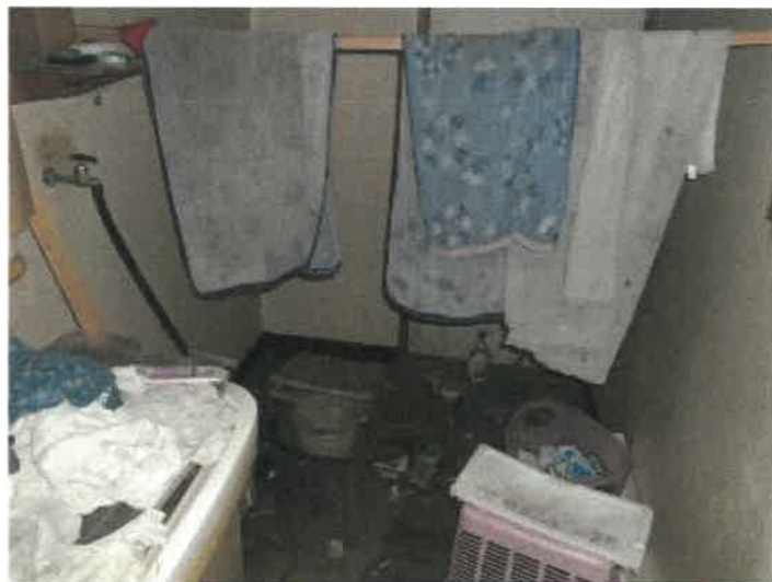
物件 2 建物の元の部分の北側中央付近洗面脱衣所の状況
