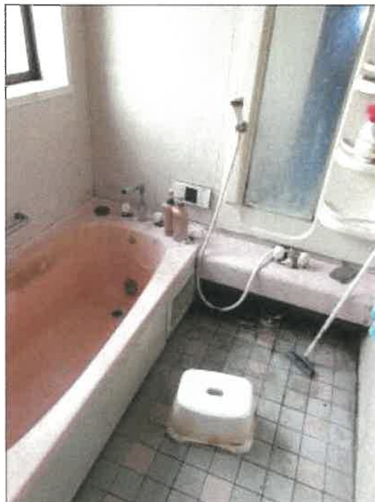
物件 2 建物の増築部分 1 階浴室の状況
