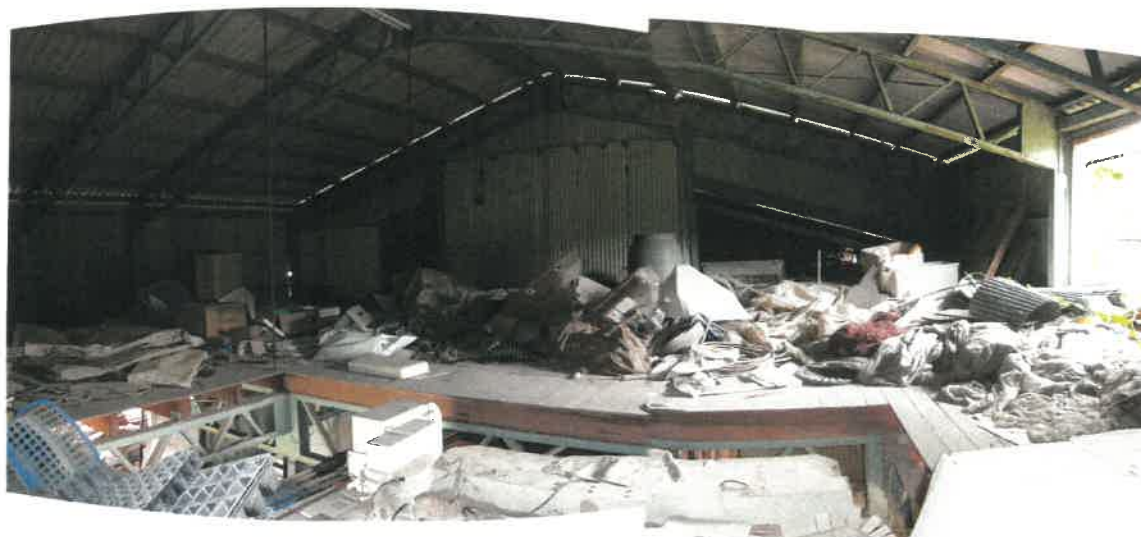
物件 2 建物西側倉庫内 2 階部分の状況
