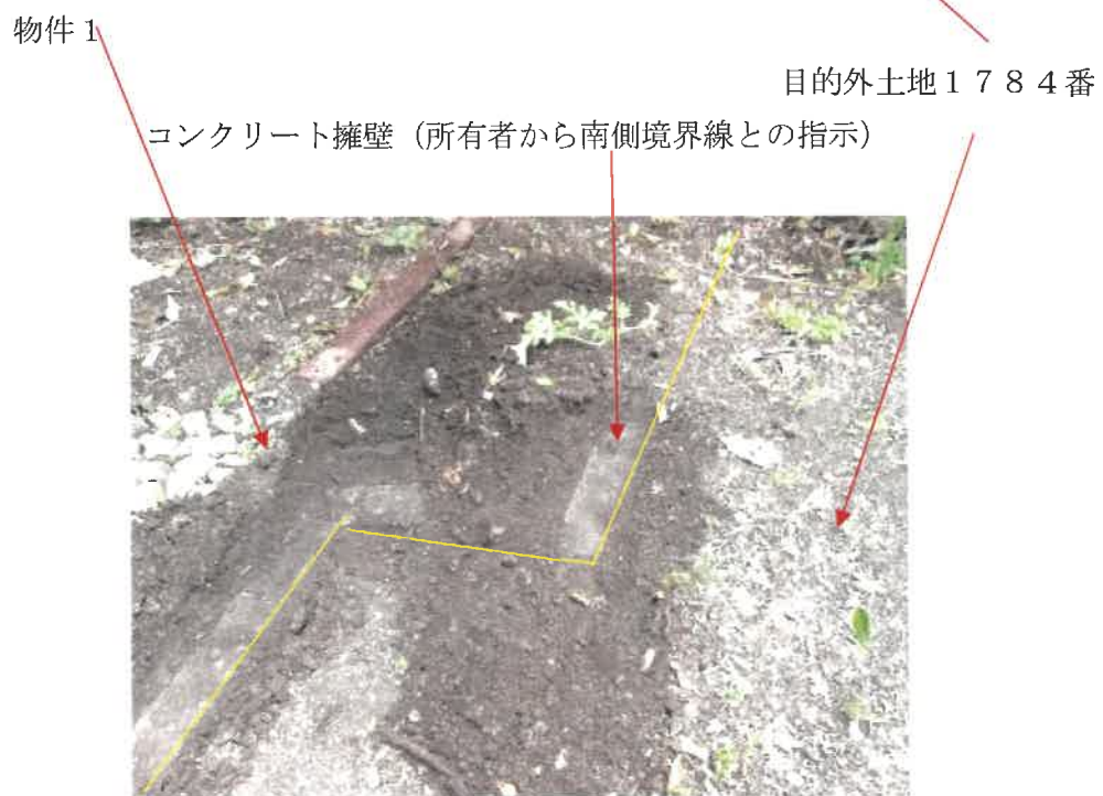
物件 1 土地南側境界線付近の状況
