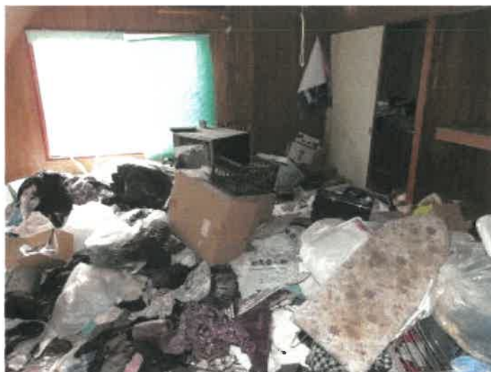
物件 2 建物の元の部分の南東角洋室の状況
