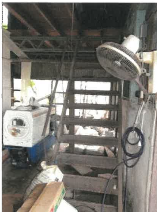
物件 2 建物西側倉庫内の階段の状況
