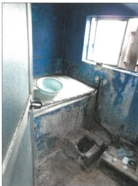
物件 2 建物の元の部分の北側中央付近浴室の状況
