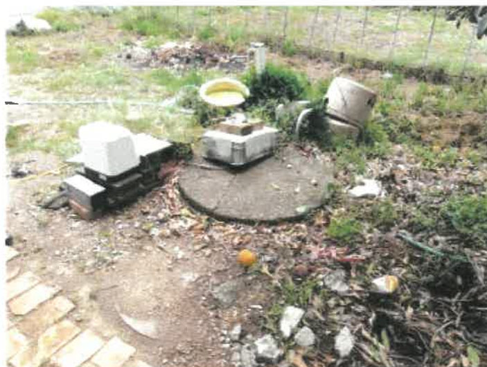
物件 1 土地南東側の井戸の状況
