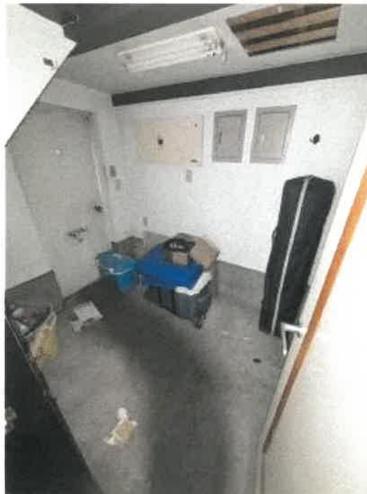
物件2 1階倉庫の状況
