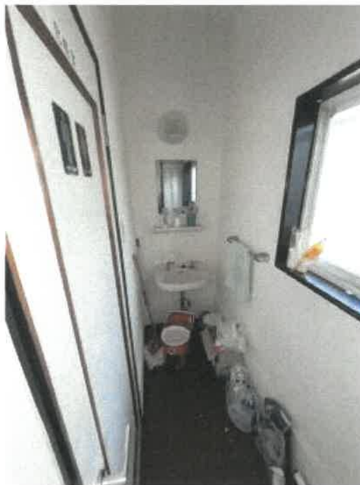
物件2 1階手洗の状況
