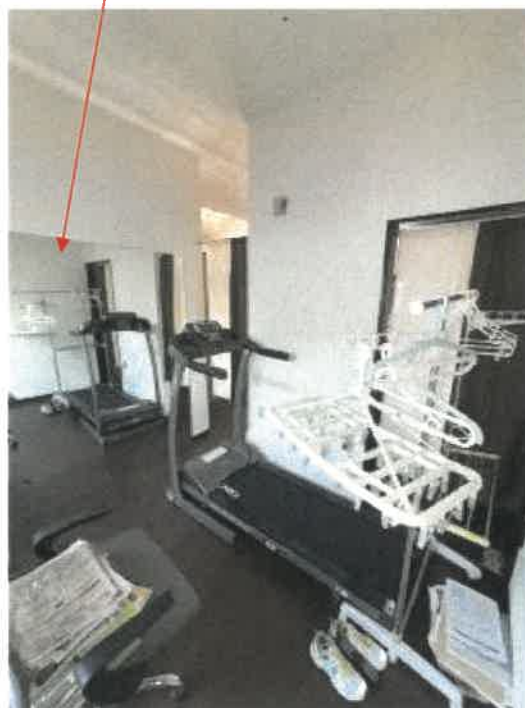
物件2 1階北西側洋室の状況
