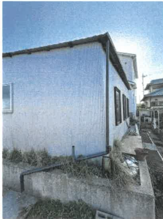
物件1 北西側の状況
