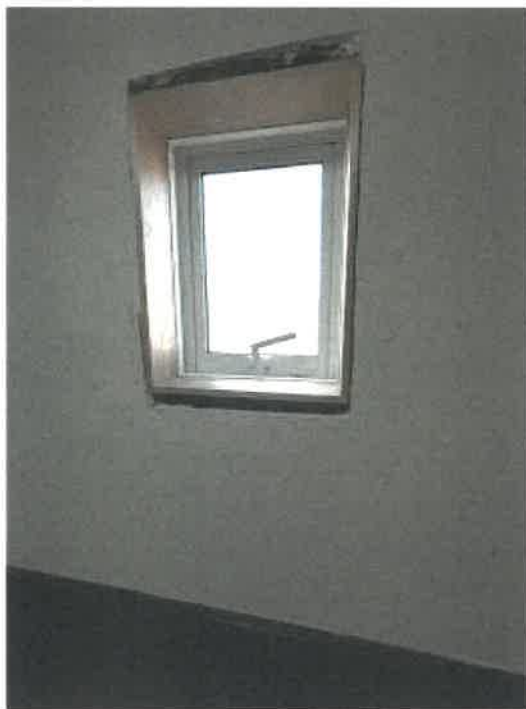
物件 2 2階南西側洋室の窓枠の状況
