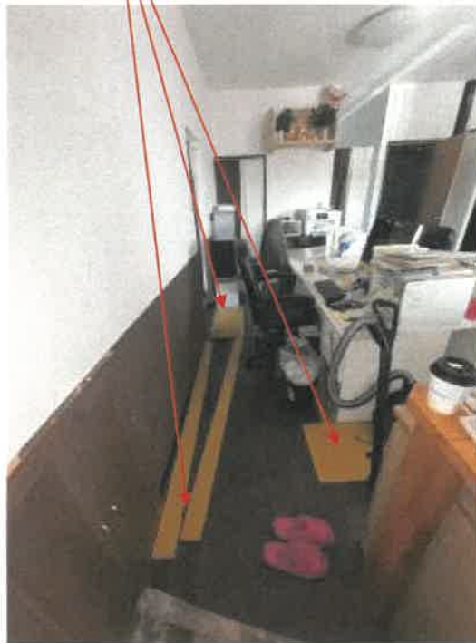
物件 2 1 階中央事務室西側の状況
