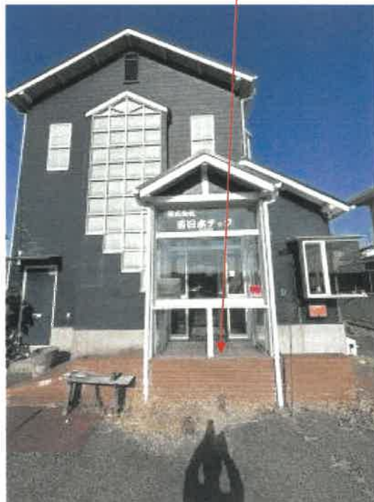
物件2 南側の状況
