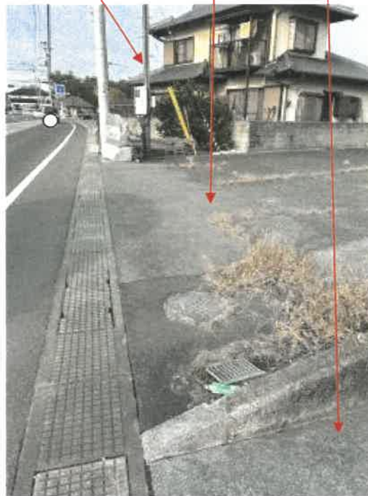
物件1 南東側の状況
