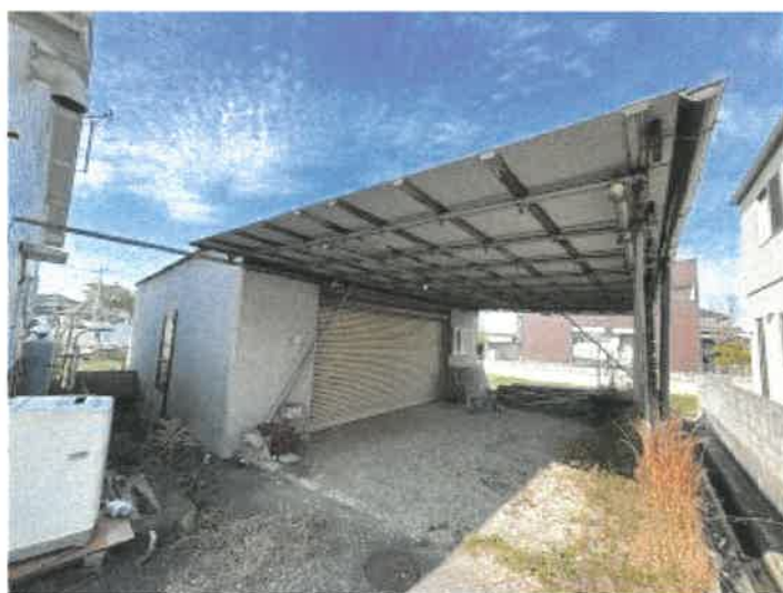
倉庫・下屋の状況
