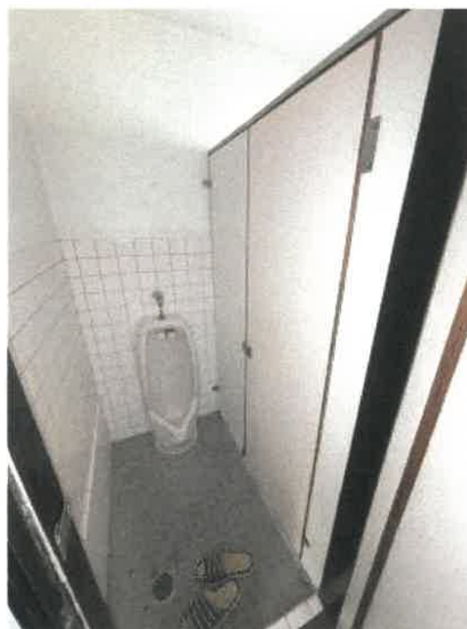
物件2 1階男性用トイレの状況
