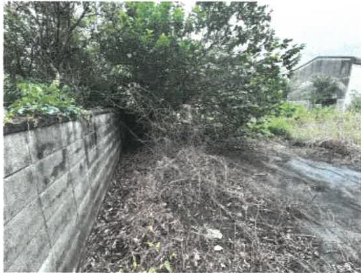
本件物件北側の状況
