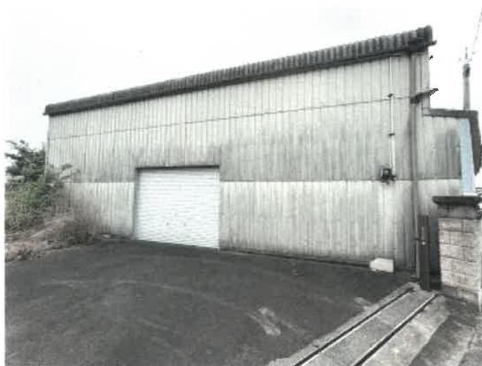
物件 3 倉庫の状況
