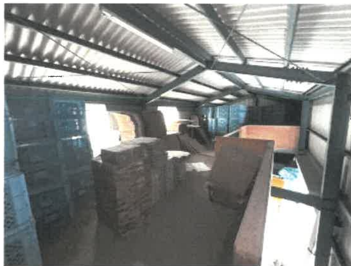
物件3 倉庫屋根裏の状況
