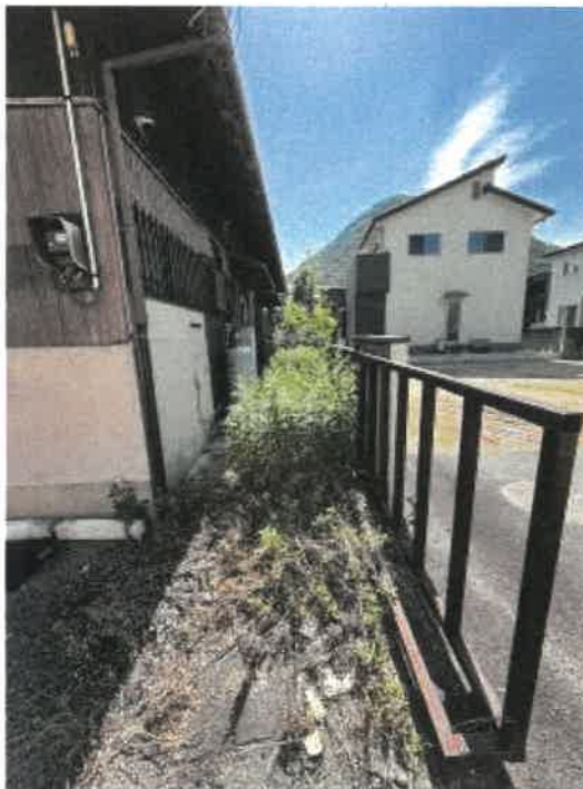
本件物件北側の状況
