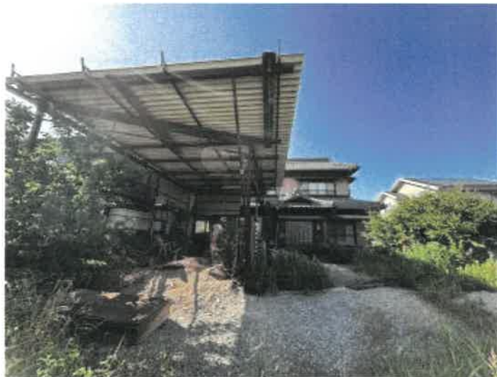
本件物件の外観（南側）
