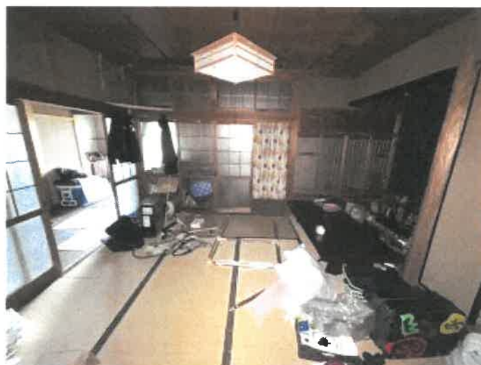
物件 2 1 階南西側和室の状況
