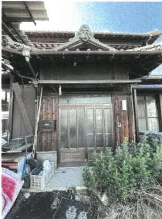
物件2 玄関付近の状況
