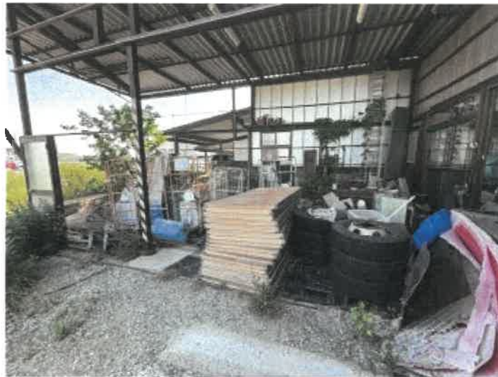
物件 2 南西側付近の状況
