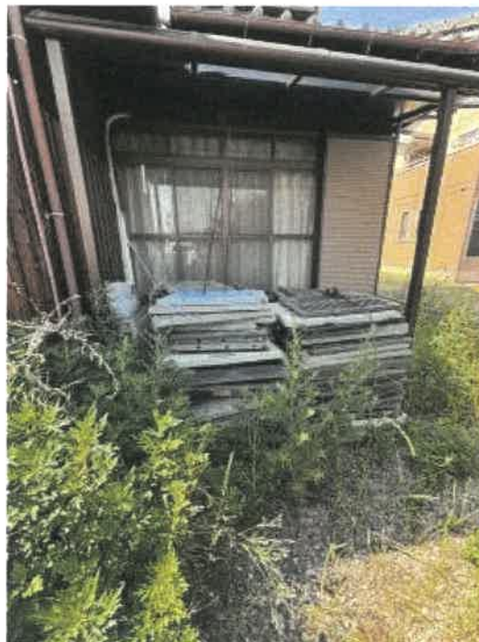
物件 2 南東側付近の状況
