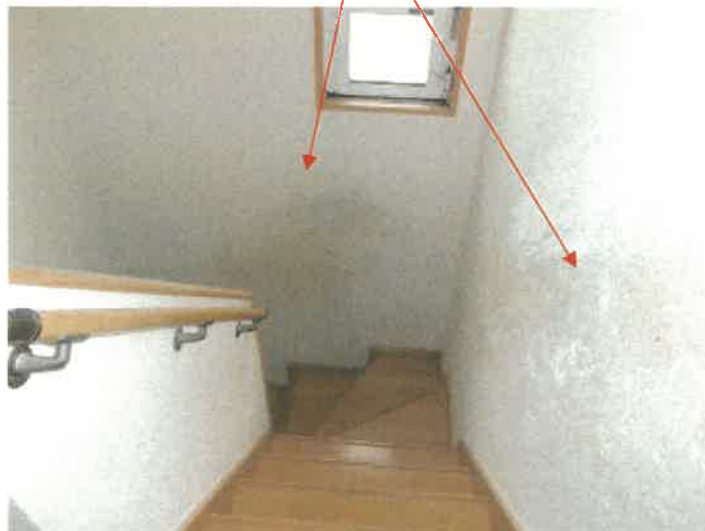
物件 2 建物の階段の状況
