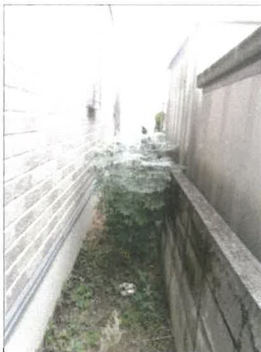
物件2建物北側の状況
