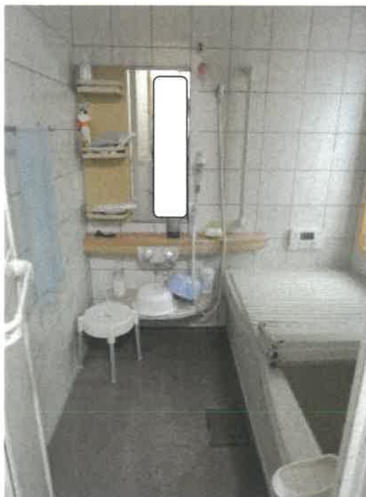
物件 2 建物の 1 階浴室の状況
