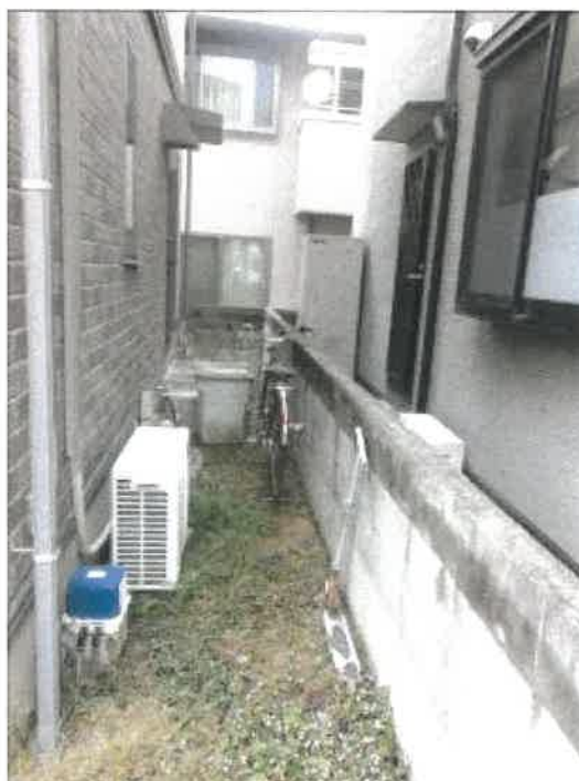
物件 2 建物東側の状況
