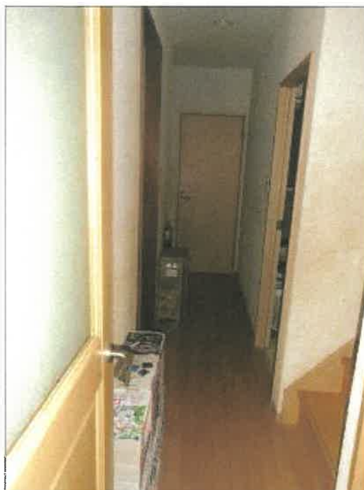
物件2建物の1階階段前廊下の状況
