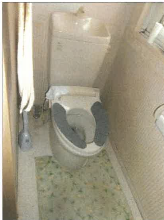
物件 2 建物の 2 階トイレの状況
